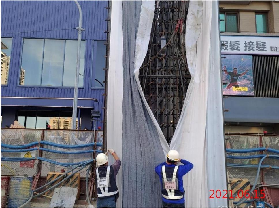
G11 站\_連續壁單元鋼筋籠吊放
