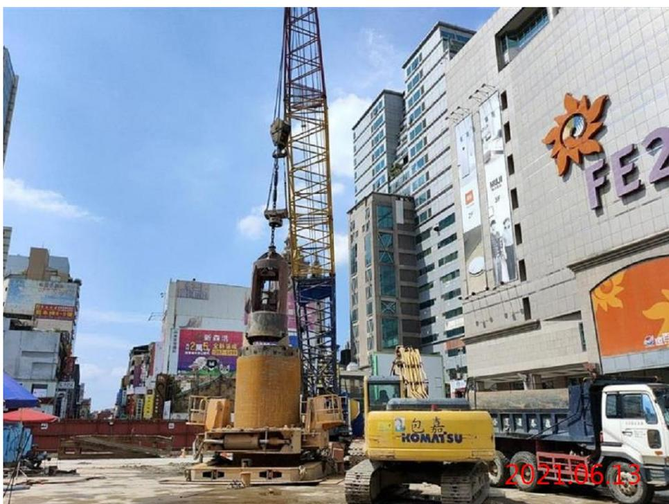
G07 站\_全套管基樁及逆打鋼柱施作
