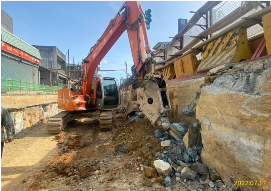
VS4 通風豎井淺挖施作
