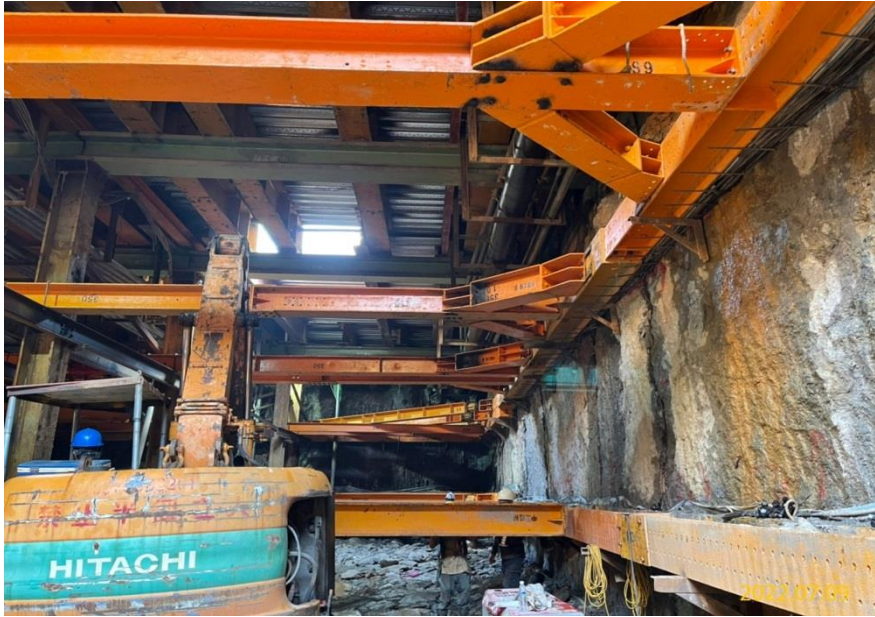
G03 站支撐系統施作
