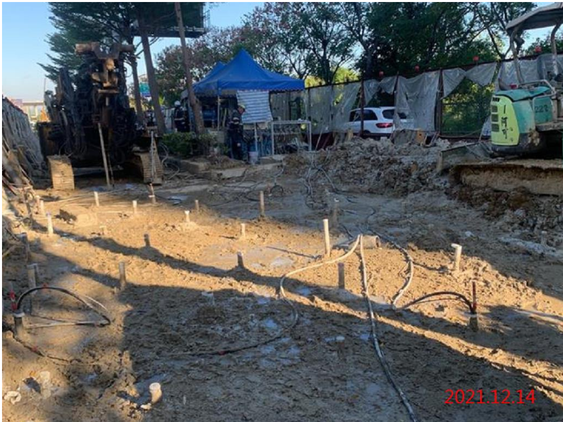
潛盾隧道_CP7 聯絡通道地質改良作業
