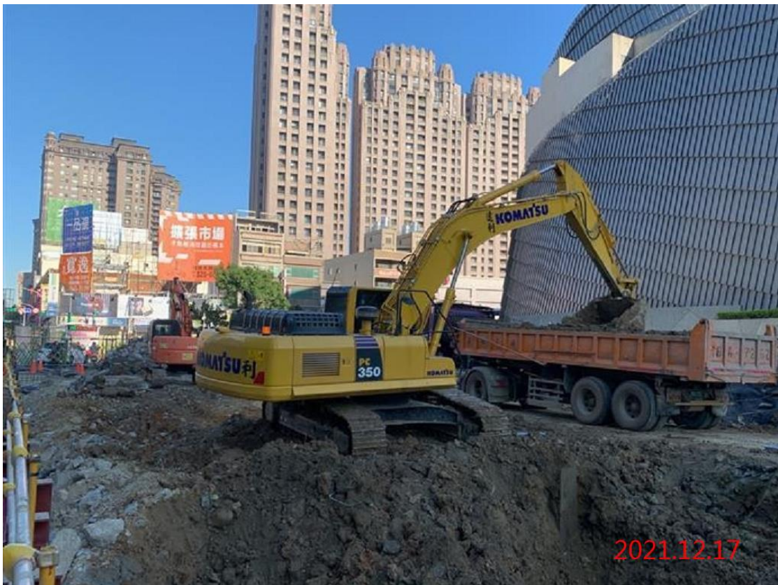
G11 站_站體開挖作業
