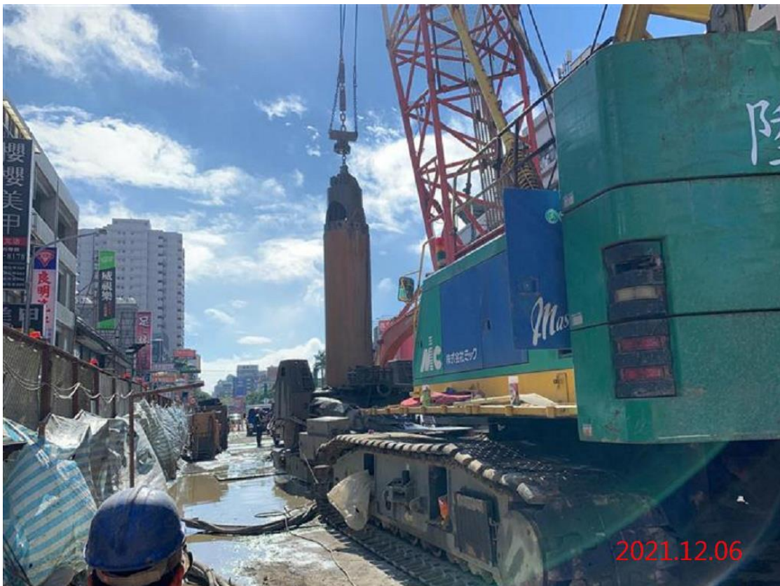
G10 站_站體中間柱施作
