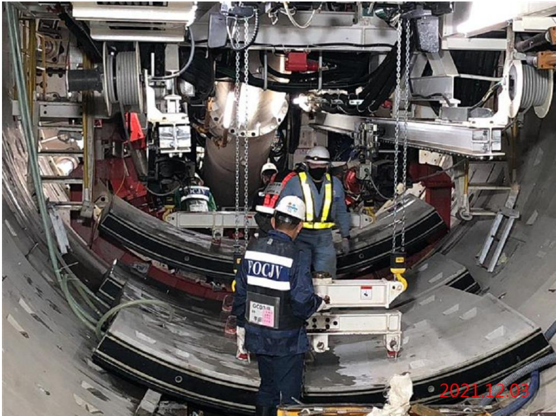
北出土段~G12 車站間 潛盾隧道下行線掘進及環片組立
