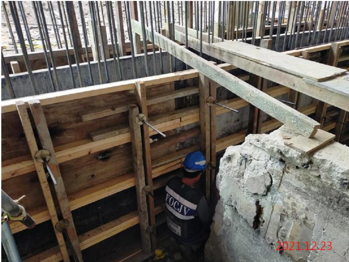
G08 站_連續壁導溝施作
