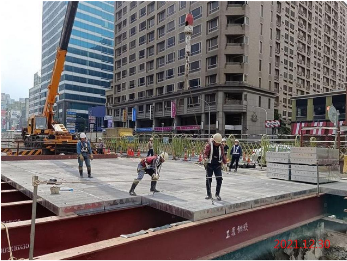
G11 站_覆工系統施作
