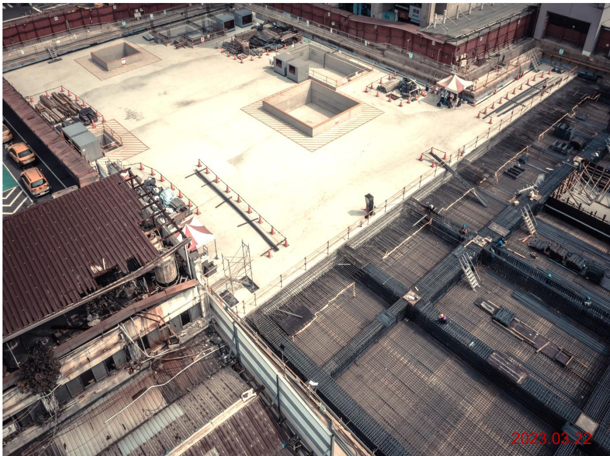
G07 站_站體結構 1FL 施築
