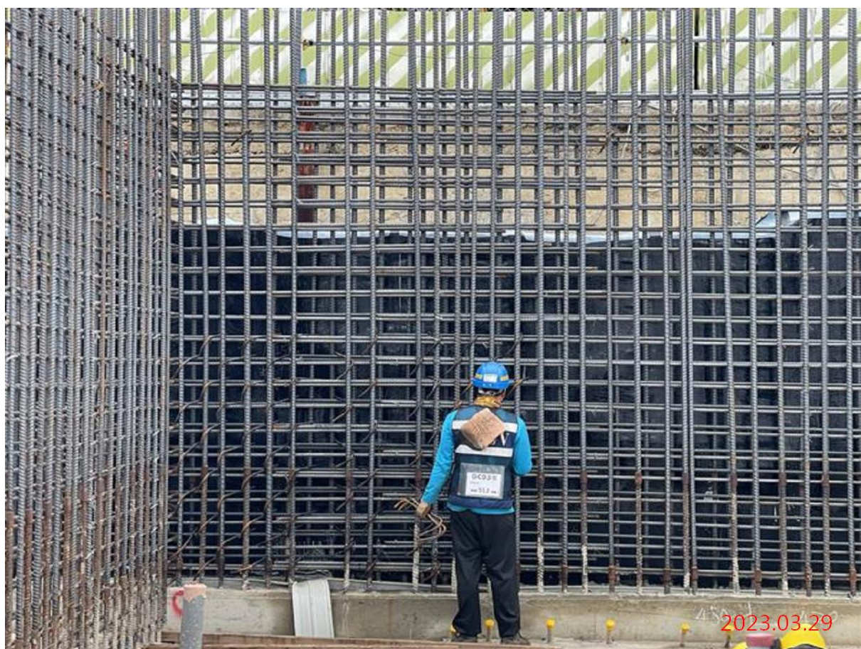
G12 站_出入口昇層牆鋼筋綁紮
