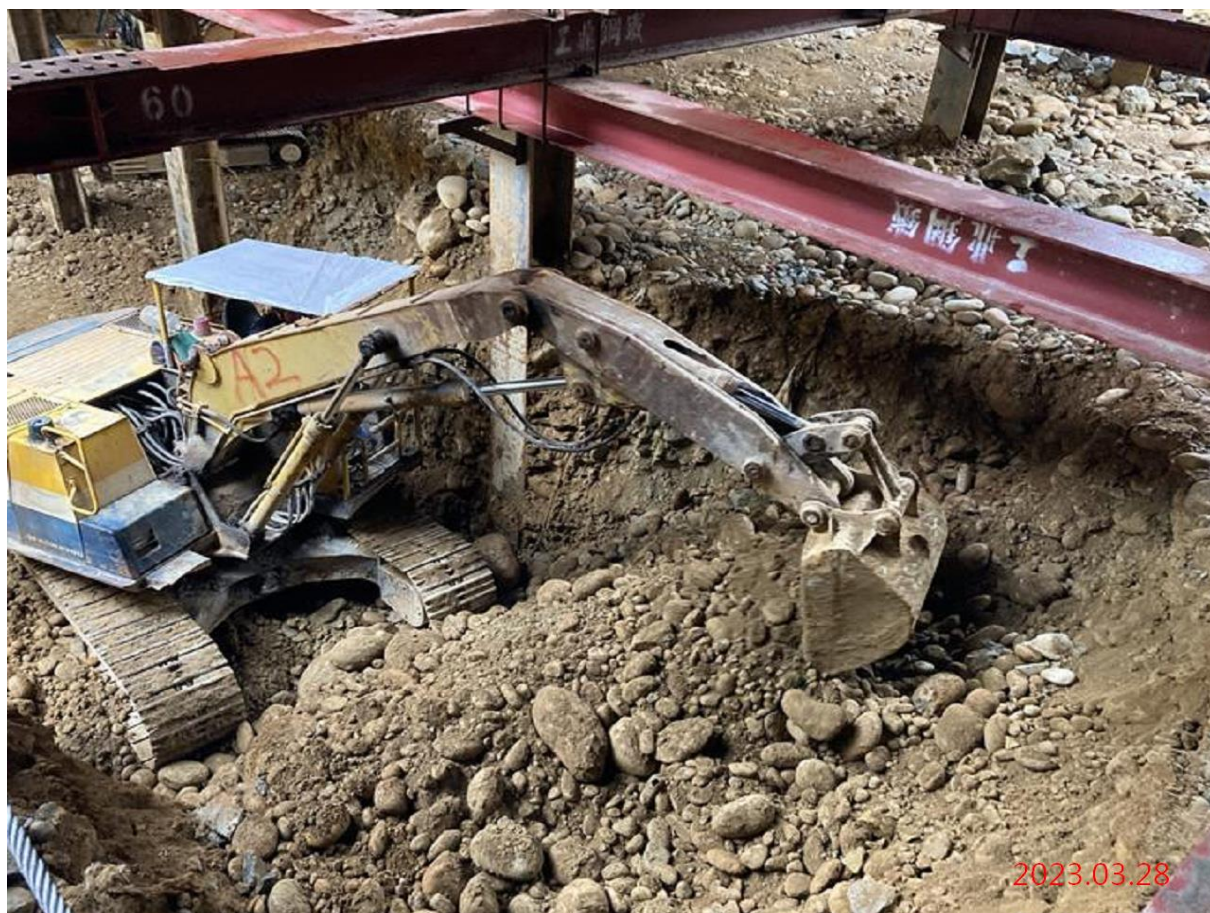
G09 站_站體第三層開挖
