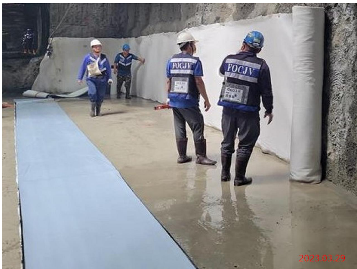
G10 站_結構軌道版防水膜施作
