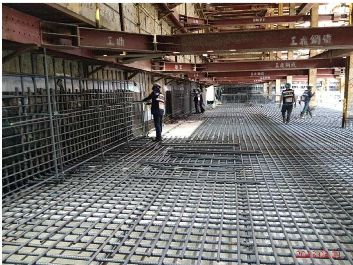
G11 站_ 出入口穿堂版鋼筋綁紮
