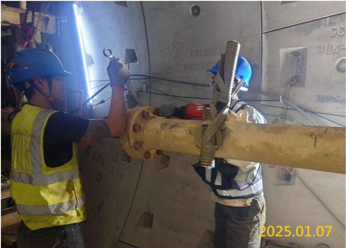
G03 潛盾機拆除作業
