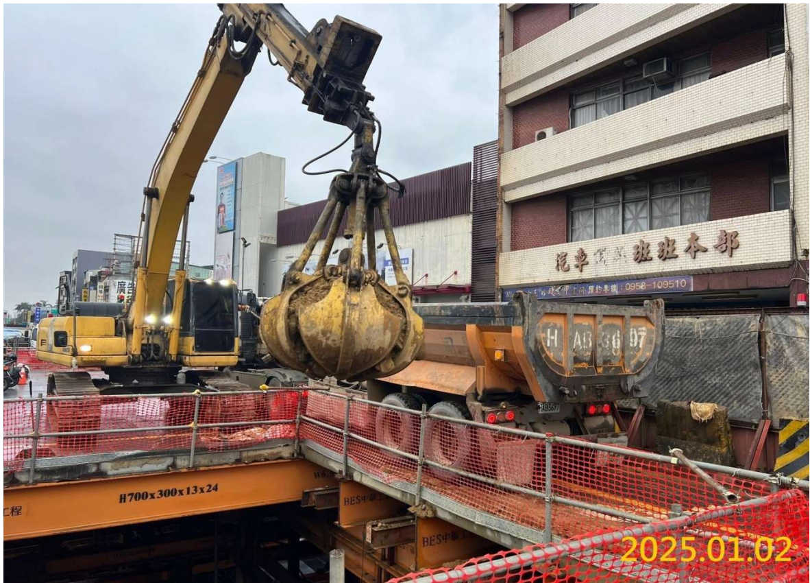
G05 站土方開挖作業
