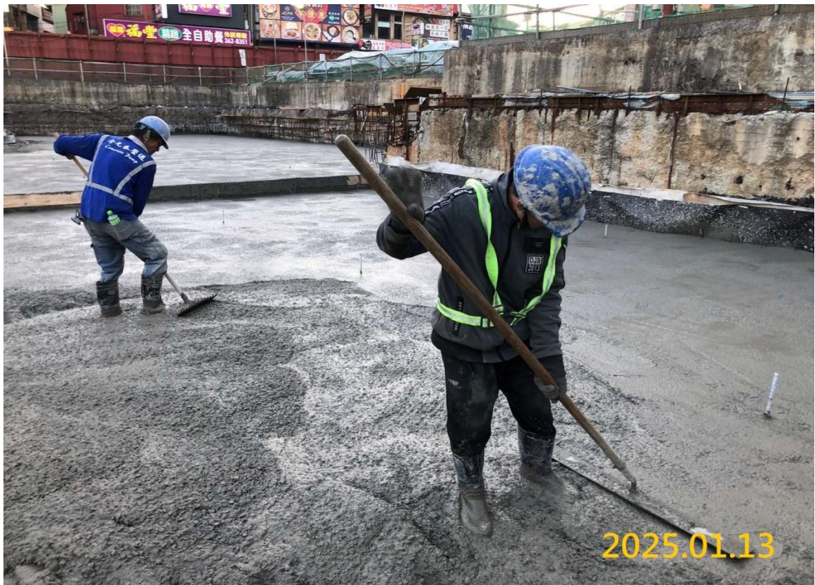
VS6 通風豎井結構頂版施作
