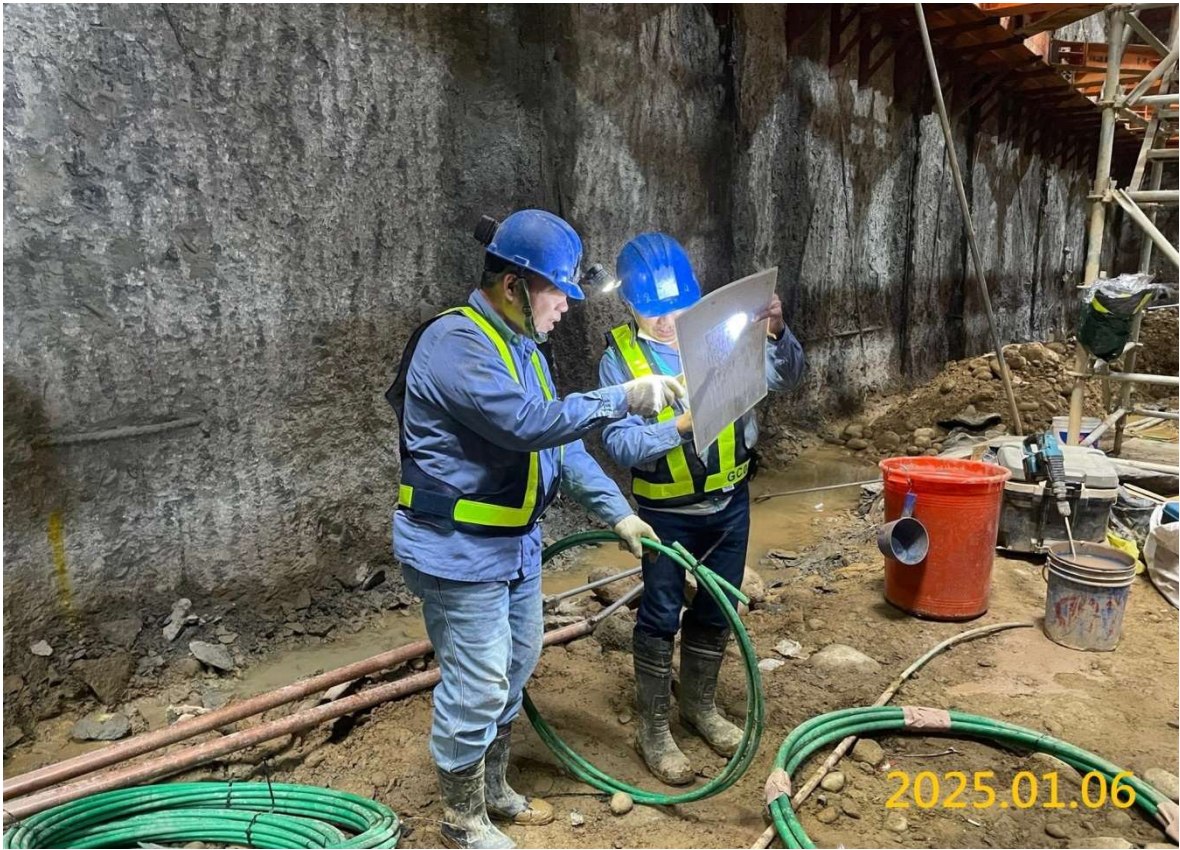
VS4 結構底板接地系統施作
