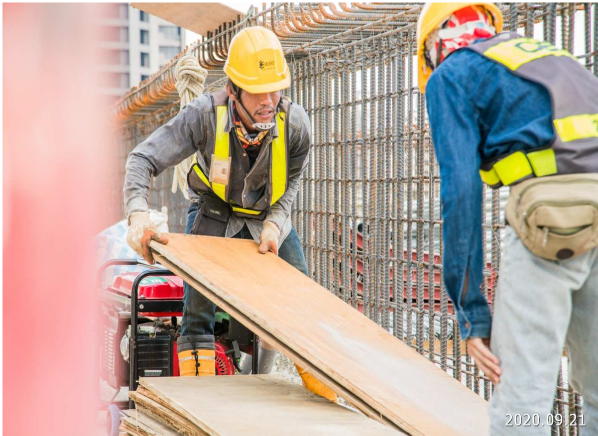
八德建德路 場鑄箱型梁橋面版施作情形
