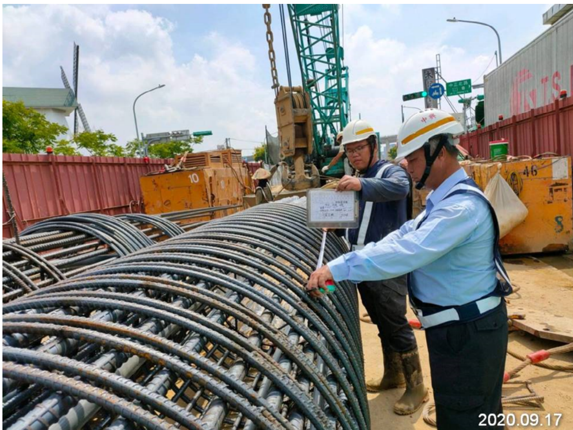
蘆竹中正北路 基樁鋼筋查驗
