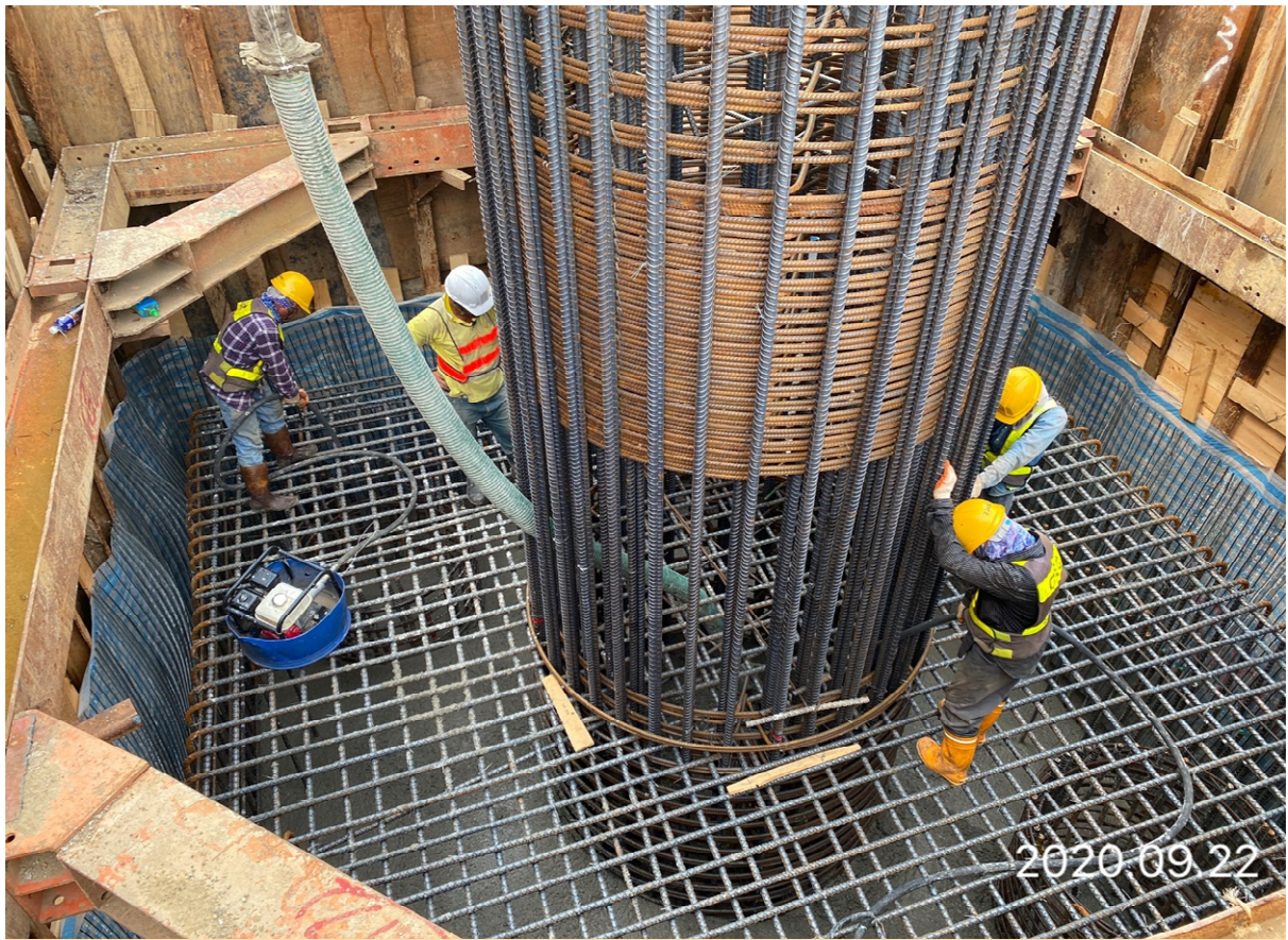
蘆竹中正北路 樁帽混凝土澆置
