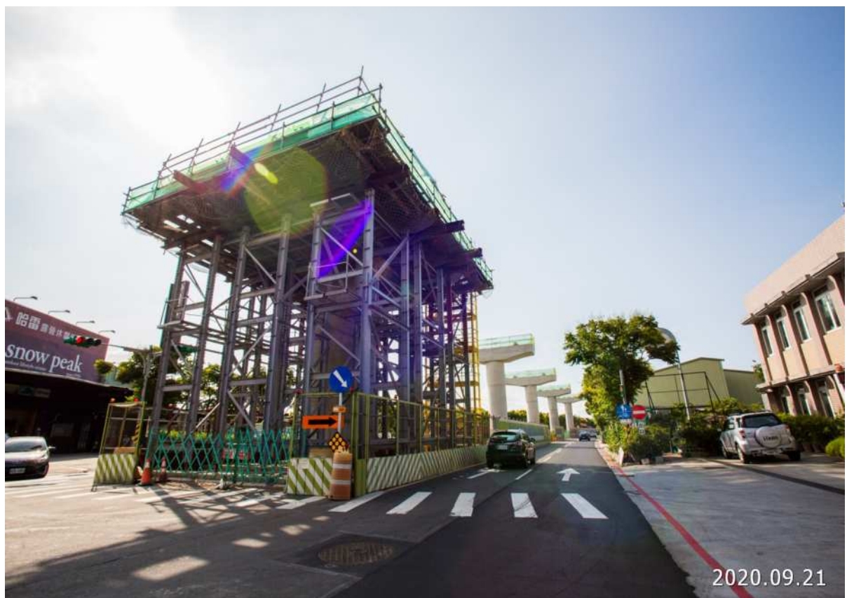
蘆竹中正北路 下部結構施作情形
