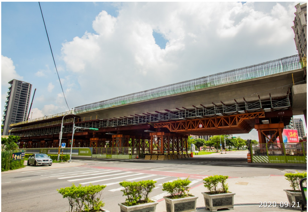
八德建德路 場鑄箱型梁橋面版施作情形
