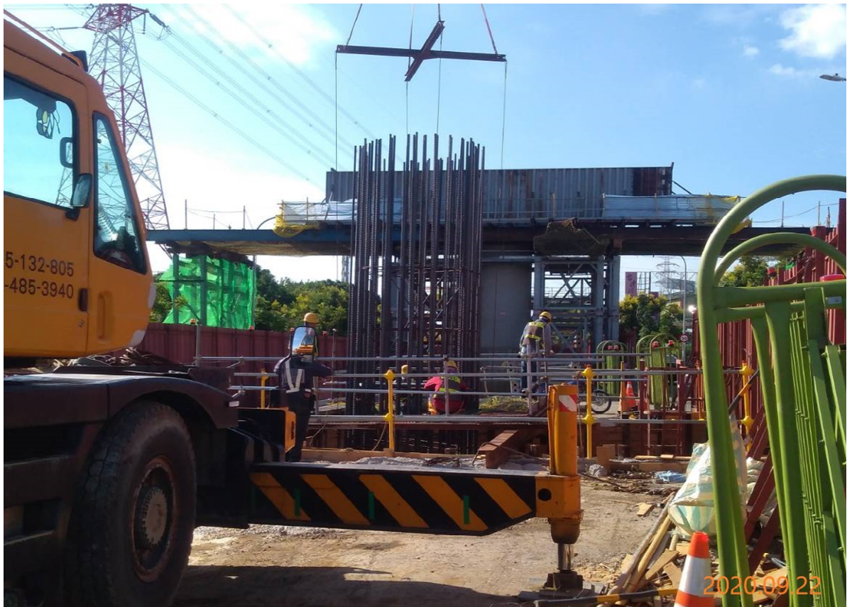
蘆竹中正北路 墩柱鋼筋綁紮
