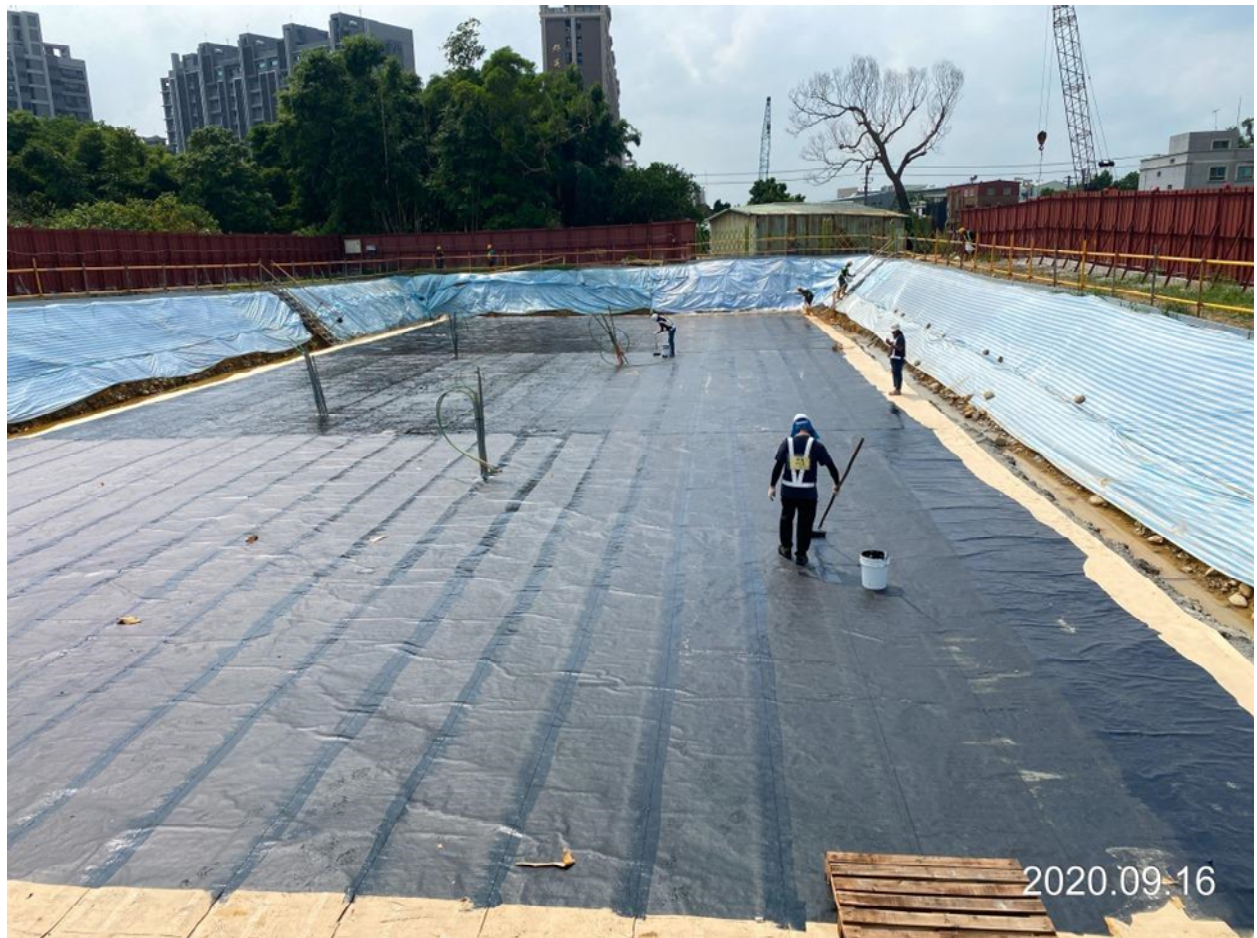
八德建德路 G01 站出入口防水膜施作
