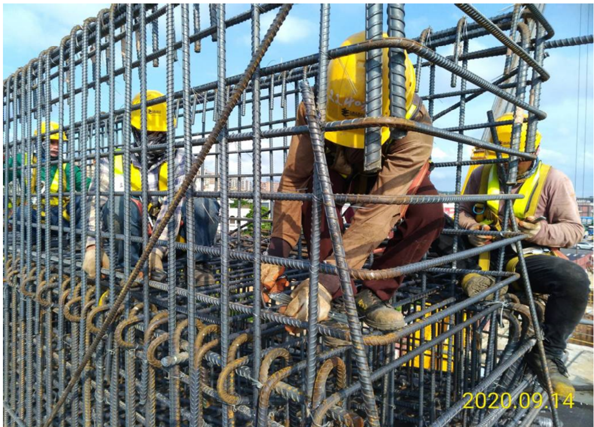
蘆竹中正北路 帽梁鋼筋綁紮
