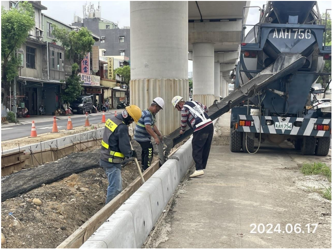
南崁路 2 段中央分隔島復舊緣石底座混凝土澆置
