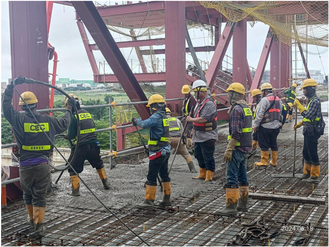
G32 車站站體穿堂層第一單元(D2-D3)及連通道 DECK 板混凝土澆置
