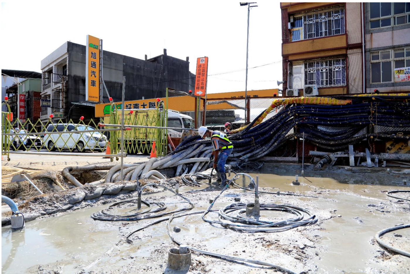
VS5 通風豎井地盤改良處理施作
