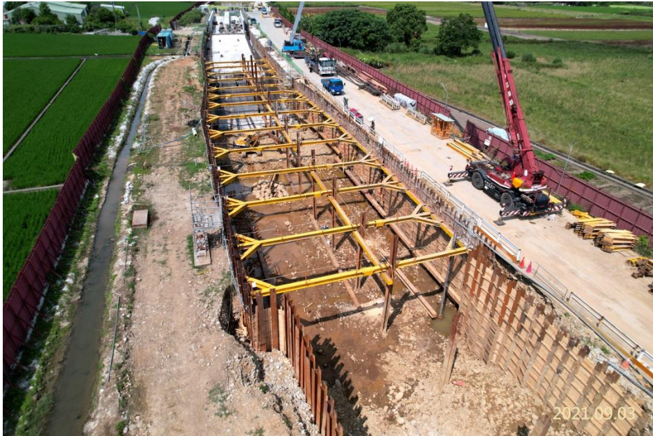
南出土結構體施作
