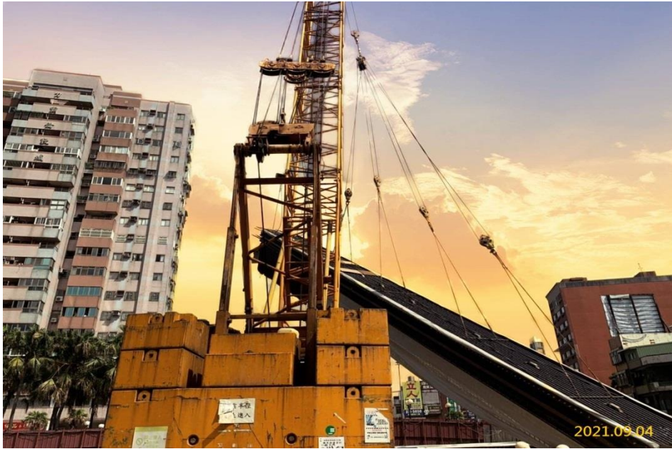
G04 站連續壁鋼筋籠吊放
