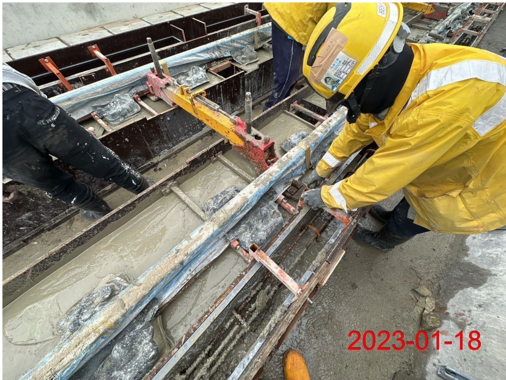
G13~G13a 上行線混凝土澆置作業(U65-U76)
