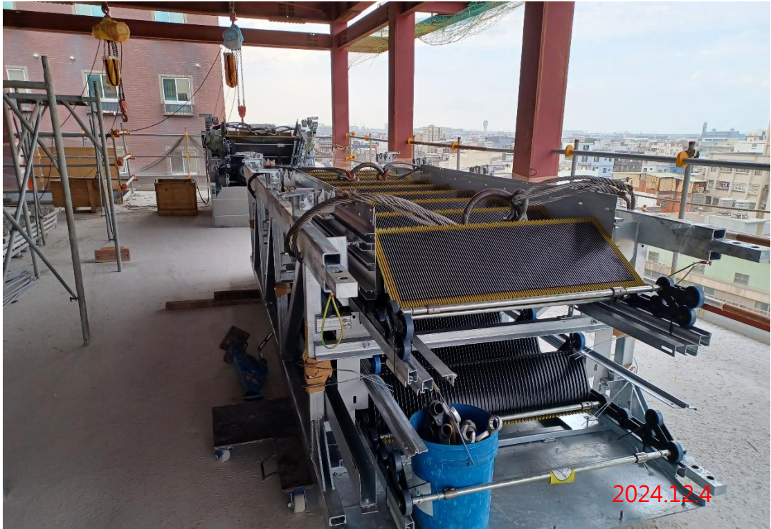
G31 站 5、6 號電扶梯進場吊裝作業
