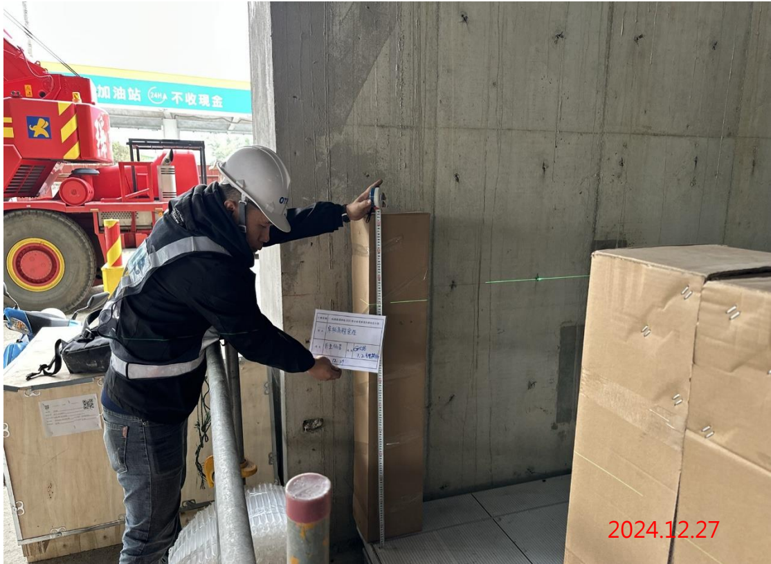
G13a 站 3-4 號電扶梯扶手護欄安裝 · 高程調整作業
