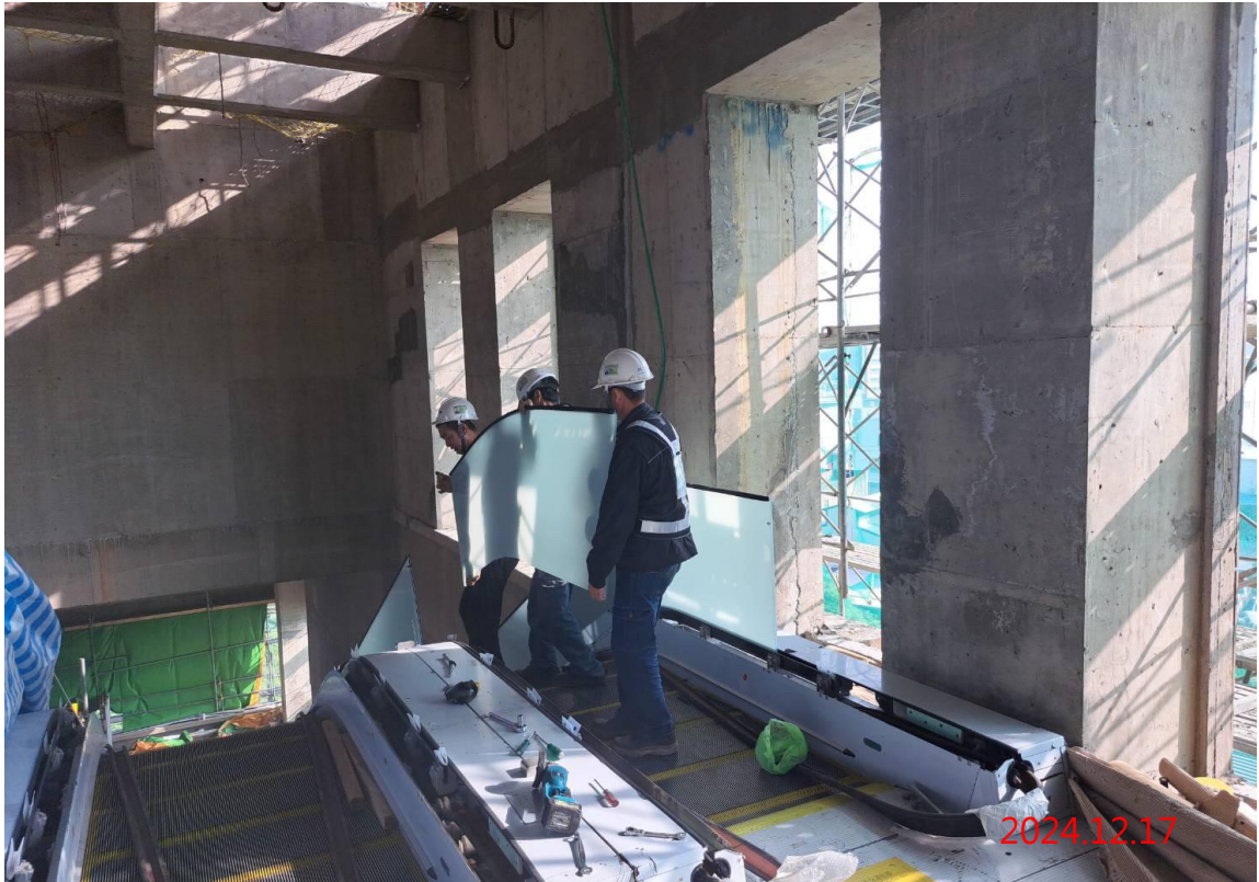
G14 站 1-4 號電扶梯扶手玻璃安裝作業
