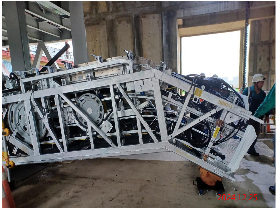
G31 站 04 電扶梯吊裝作業
