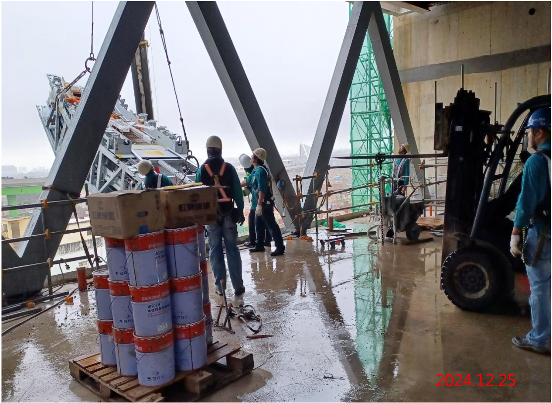
G31 站 04 電扶梯吊裝作業
