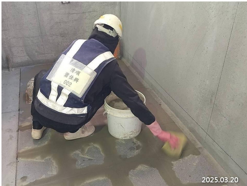
G02 車站出入口室內地磚施作
