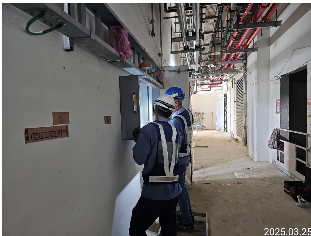
G15b(原 G32)車站 3F 電氣系統施工
