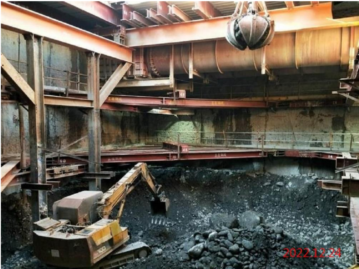
G10 站_站體結構開挖
