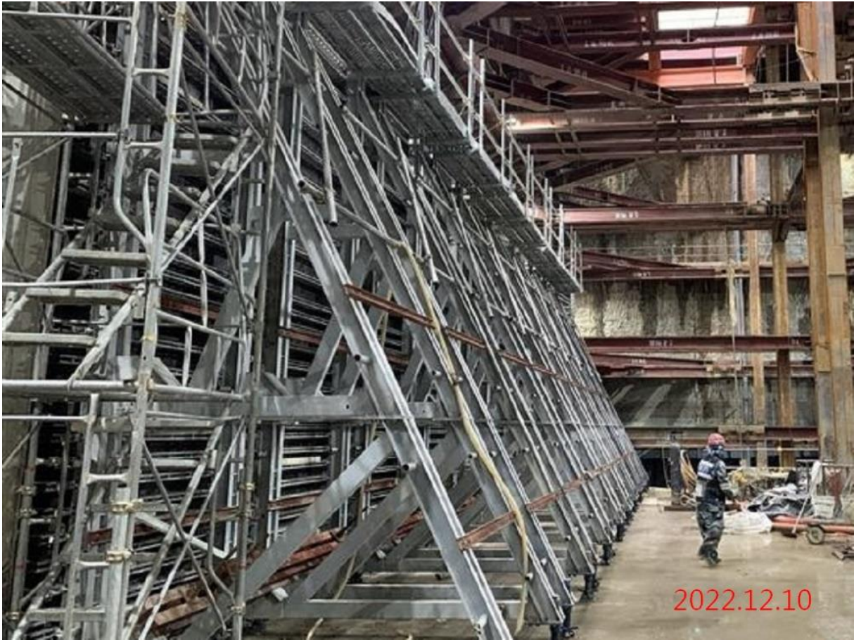
G11 站_站體軌道側牆系統模板組立
