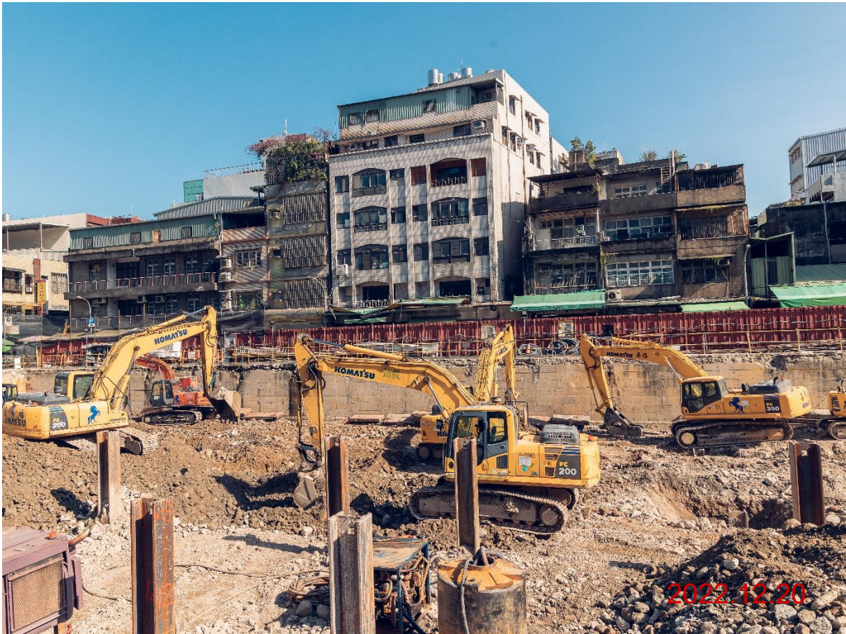
G08 站_站體鋪面破除及開挖
