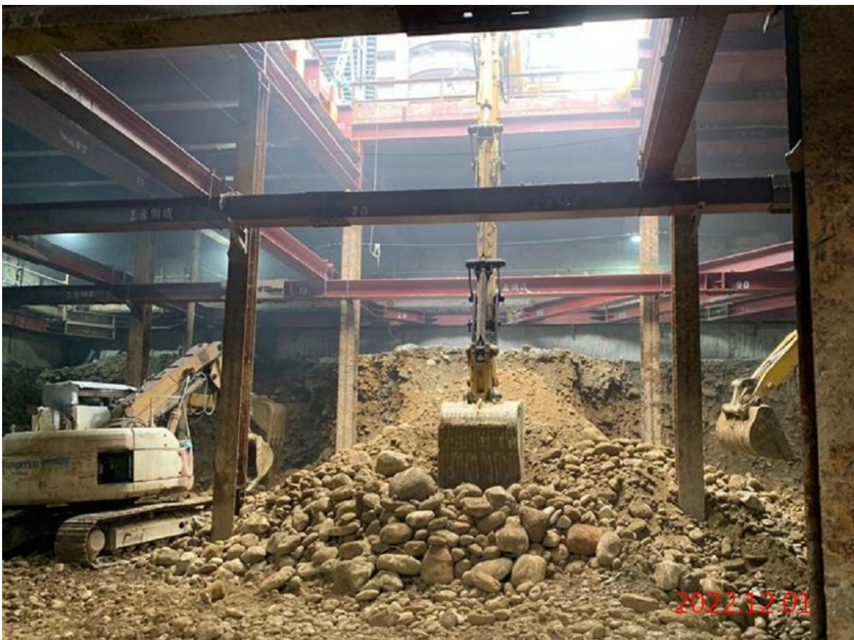
G11 站_出入口結構開挖
