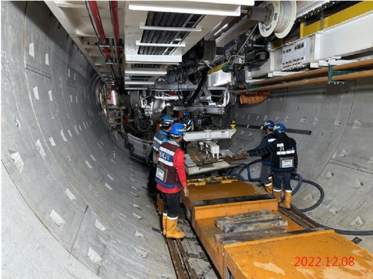
潛盾隧道_小圓掘進及環片組立
