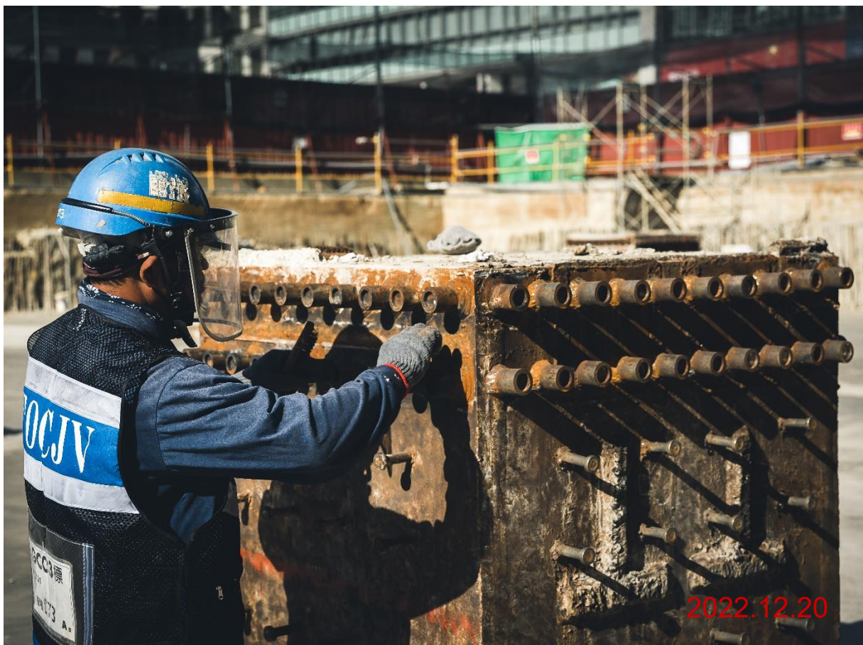
G07 站_站體逆打鋼柱續接器焊接
