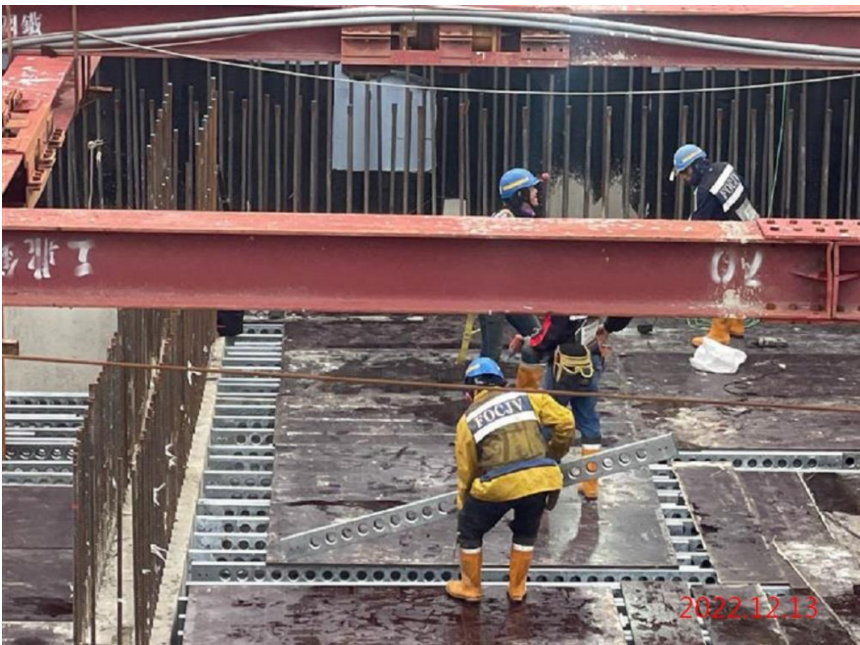
G12 站_出入口版模板組立
