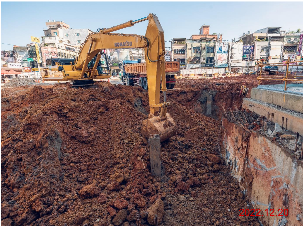
G09 站_站體結構開挖
