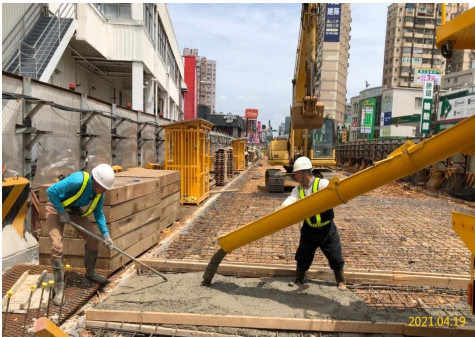
G04 站導溝鋪面施作
