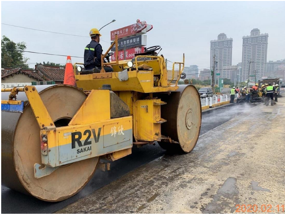
中正路中央分隔島敲除後鋪設 AC
