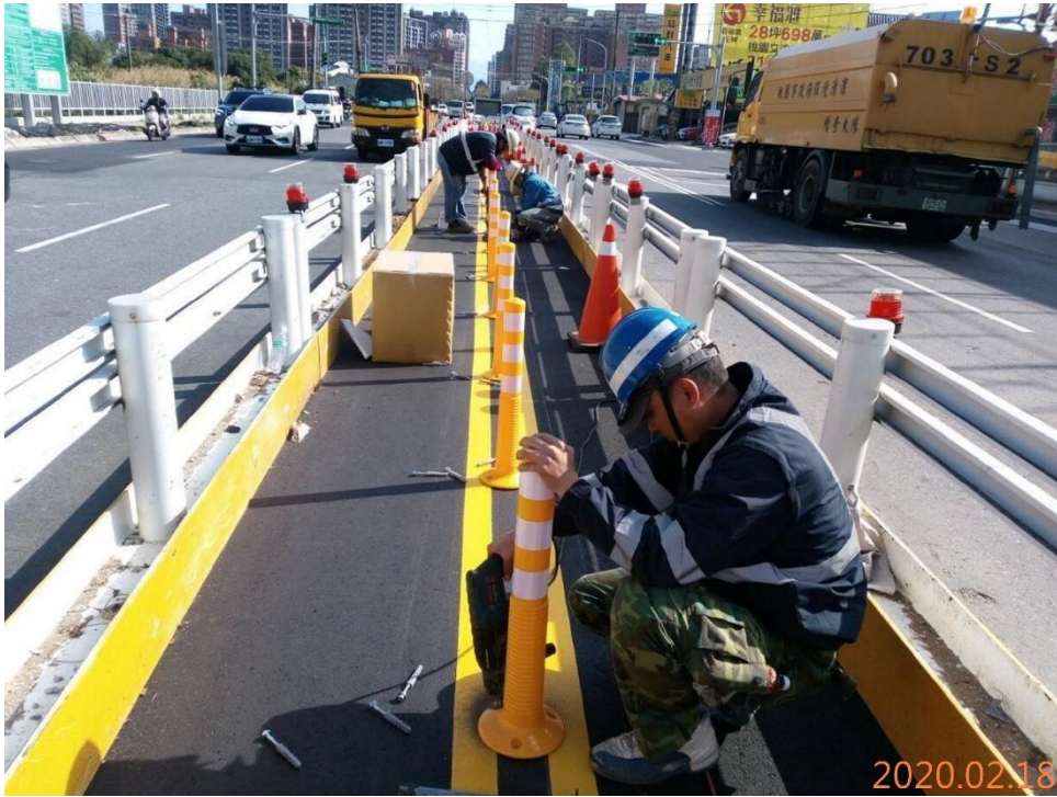
中正路中央分隔島敲除後設置彈性分隔桿
