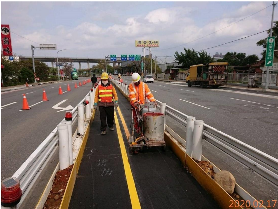
中正路中央分隔島敲除後 AC 標線
