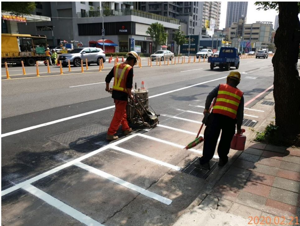
機車停車格移設標線繪製
