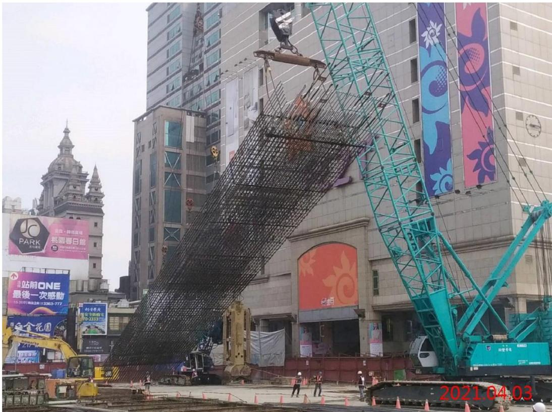
G07 站\_連續壁單元鋼筋籠吊放
