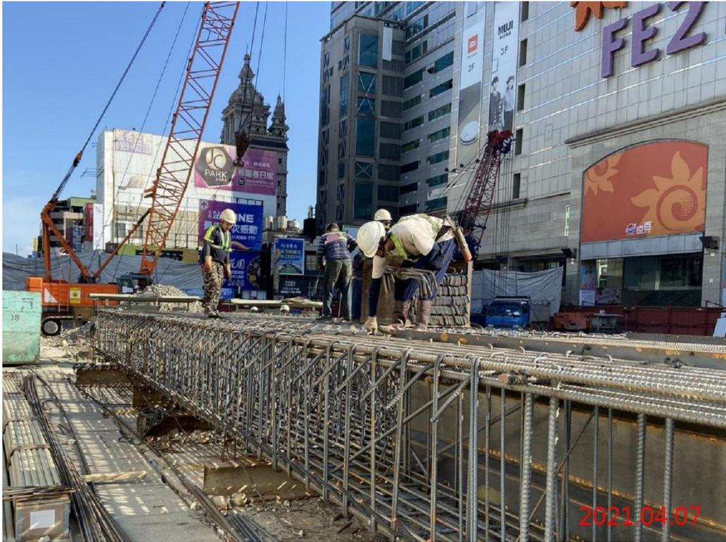
G07 站\_連續壁單元鋼筋籠綁紮
