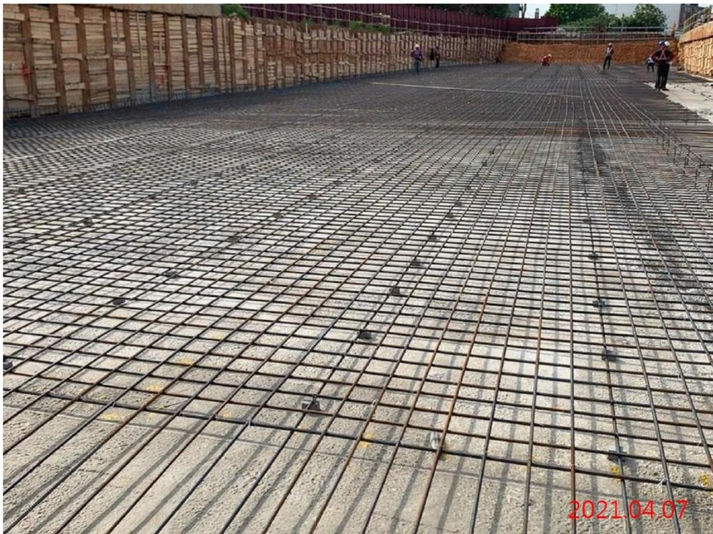
北出土段\_臨時底版鋼筋綁紮
