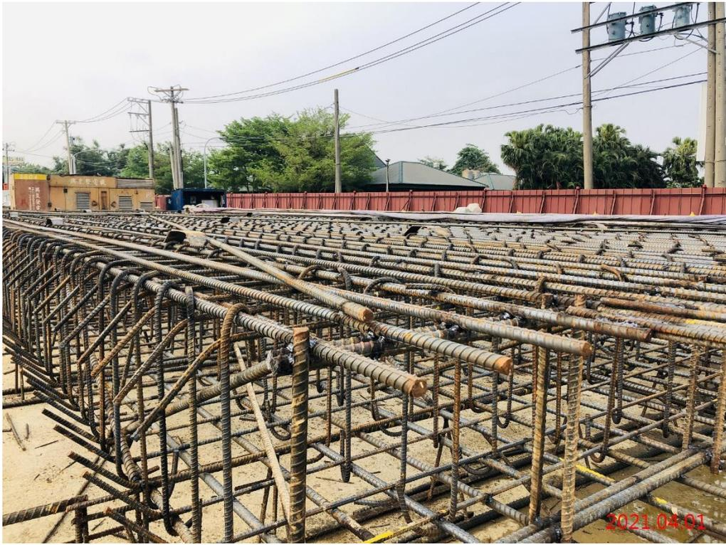
G12 站\_連續壁單元鋼筋籠綁紮
