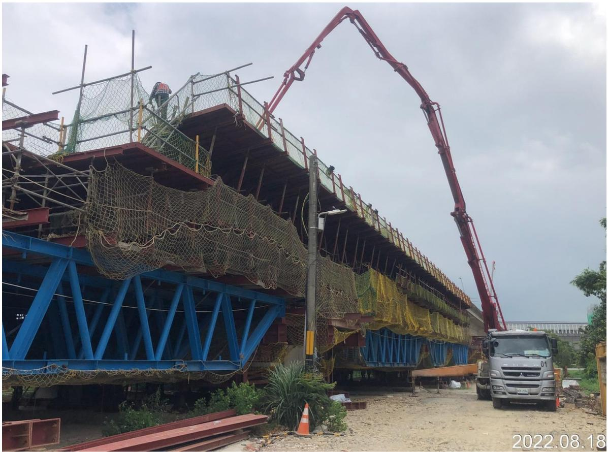
大園坑菓路 場撐箱型梁混凝土澆置
