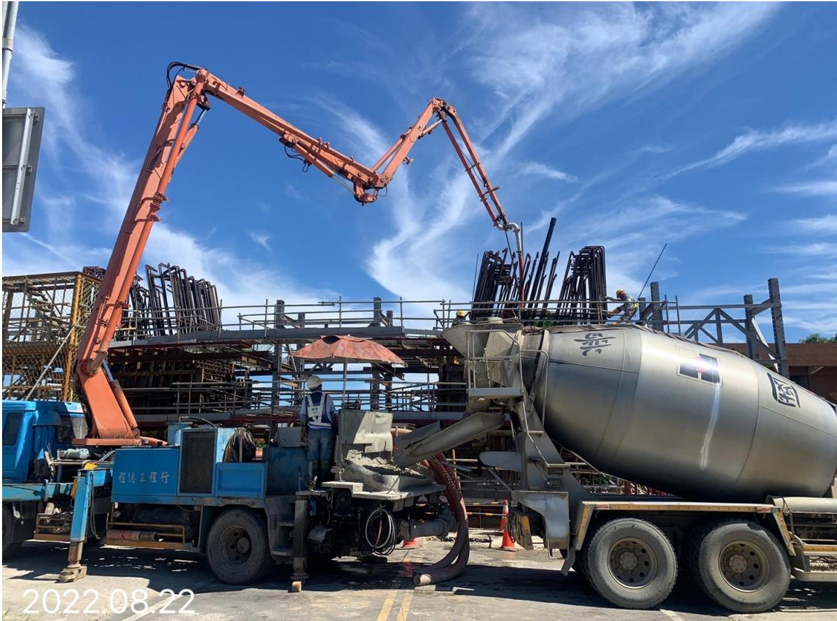
大園坑菓路 墩柱混凝土澆置
