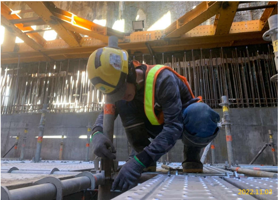
VS6 通風豎井結構體支撐架施作
