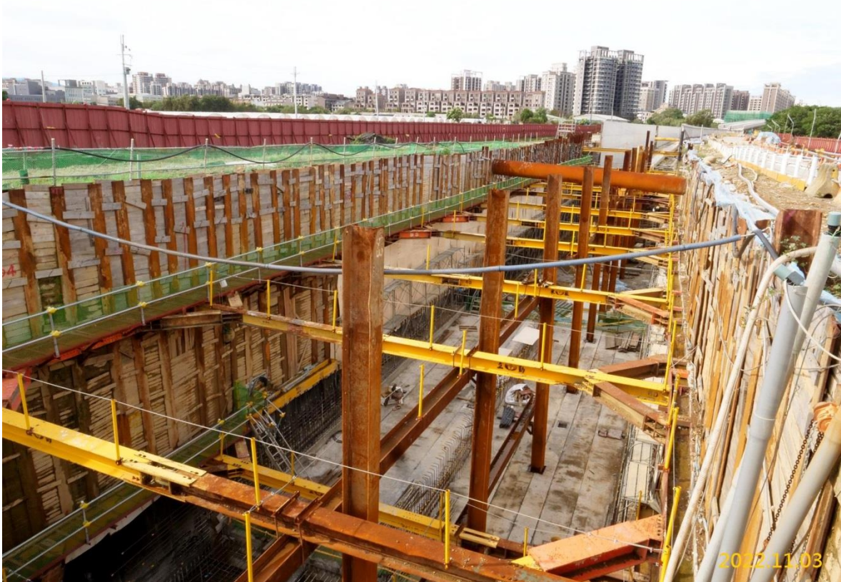
南出土段支撐施作
