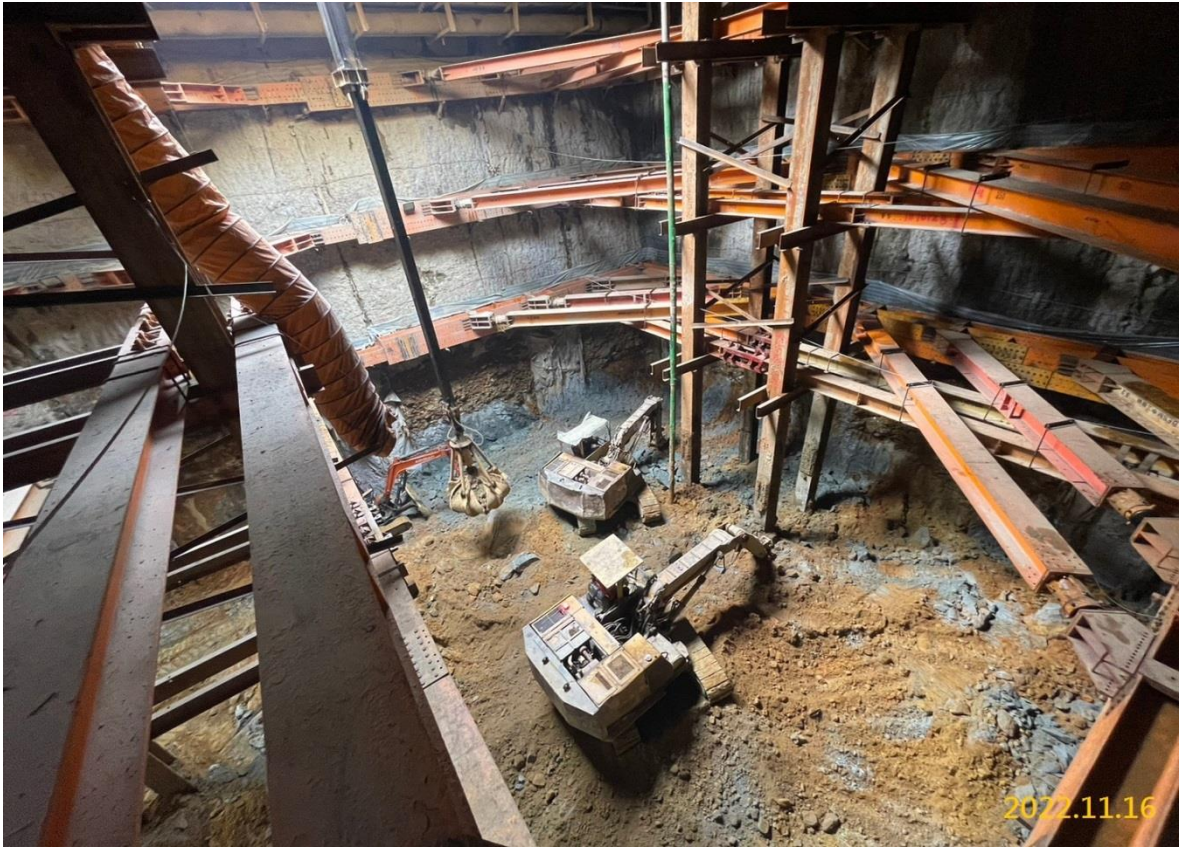
G03 站結構體開挖施作
