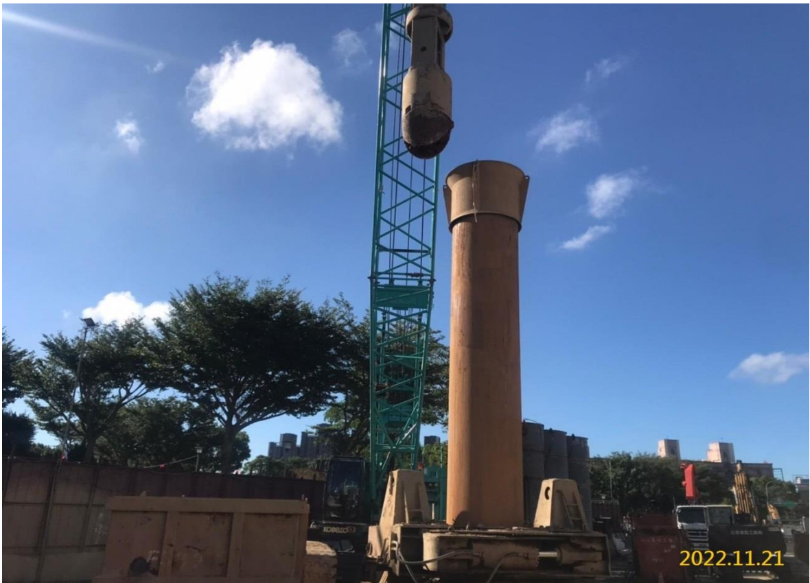
G06 站中間柱施作
