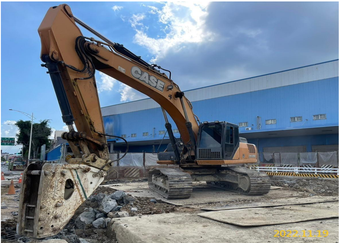
G03 站淺挖施作
