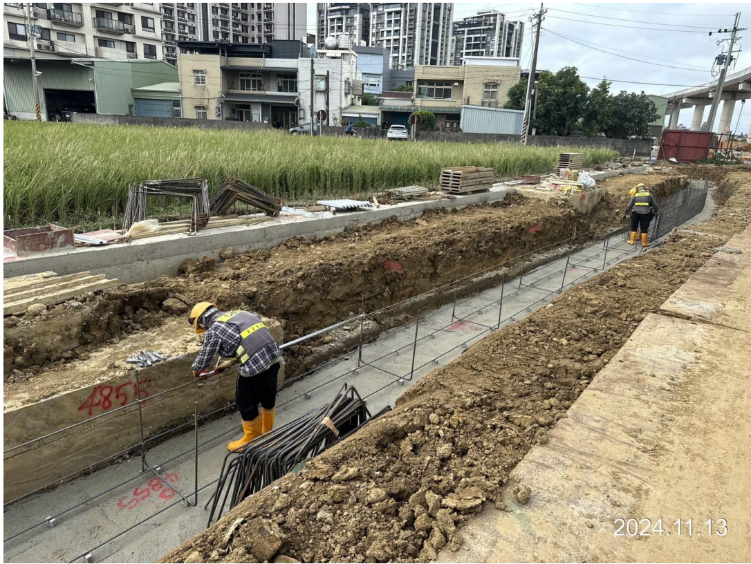
南段_出流管制 SCS-0304 側溝 ( 4k+840~890 ) 鋼筋綁紮
