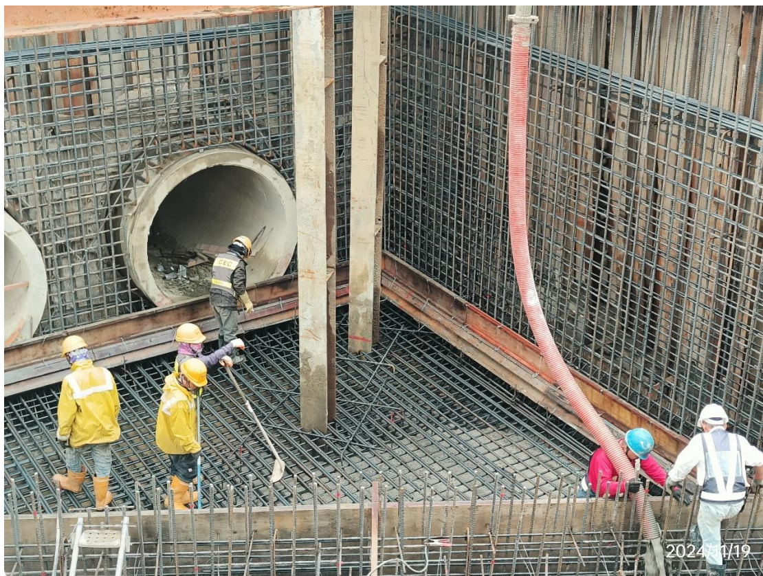
南段_雨水箱涵消能井底板混凝土澆置
