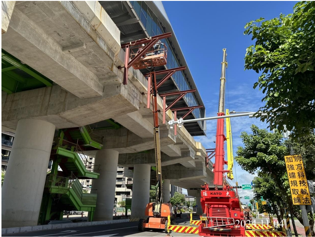
G01 車站站體施工懸吊平台吊拆
