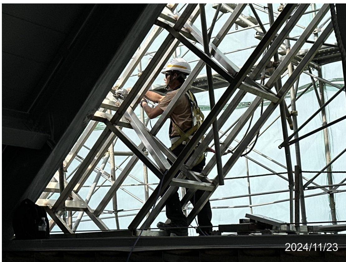
G13 車站站體外牆帷幕施作
