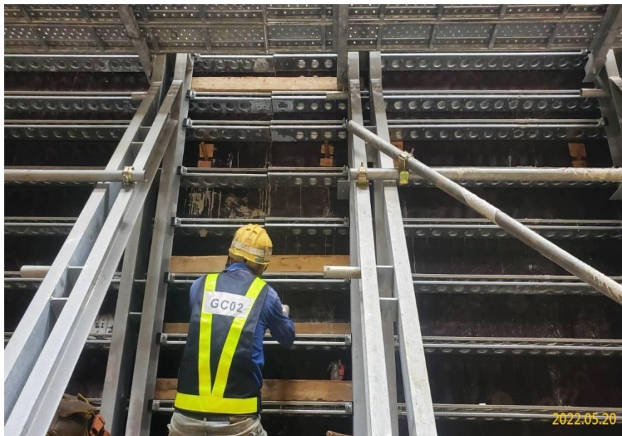
VS6 通風豎井系統模板組立安裝施作
