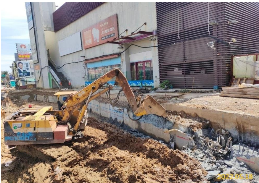
G05 站淺挖施作
