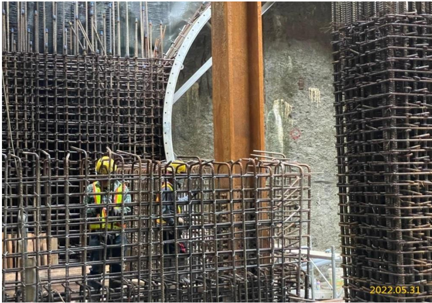
VS6 通風豎井結構體鋼筋綁紮
