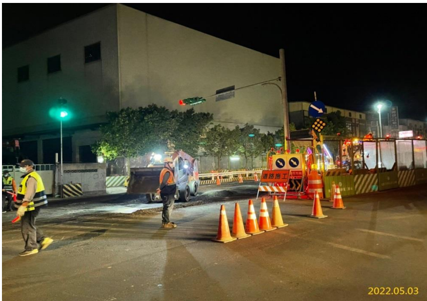
G03 站交通維持措施切換及道路刨鋪
