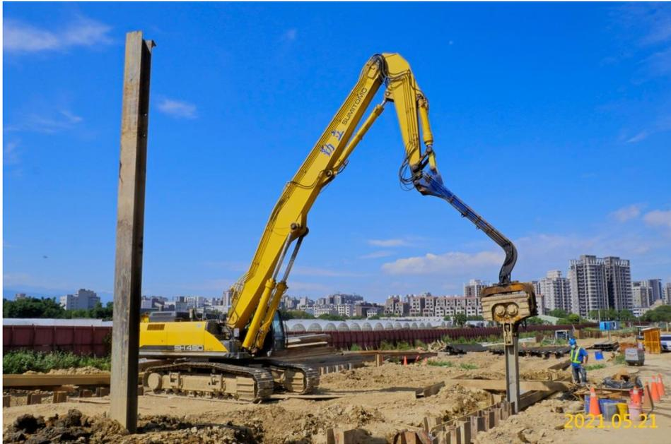
南出土段鋼軌樁打設
