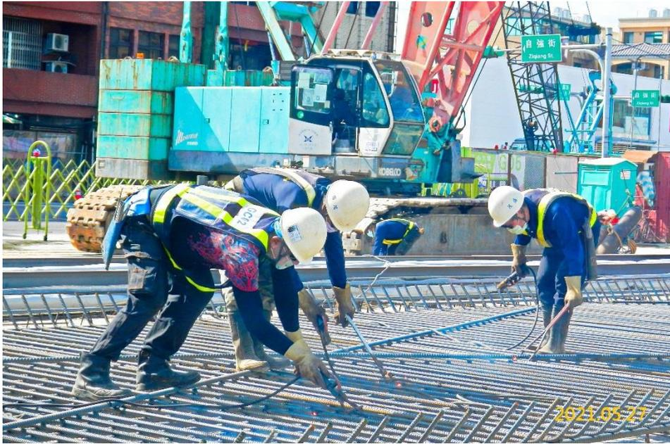
G05 站連續壁鋼筋加工
