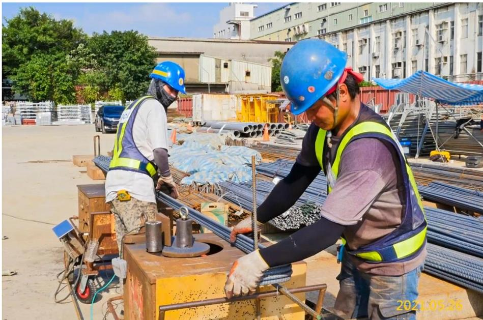
南出土段結構體單元鋼筋加工
