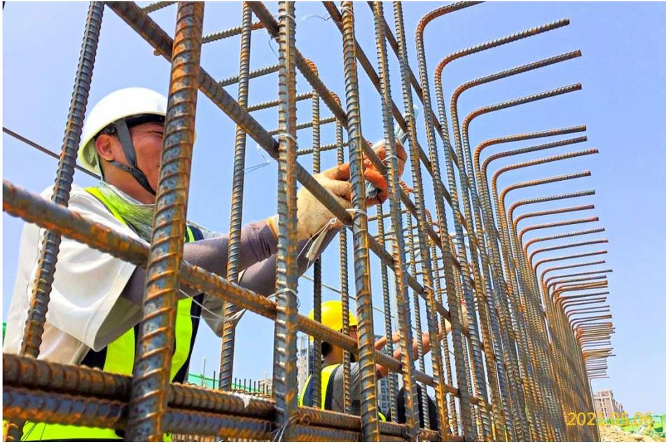
南出土段結構體單元鋼筋綁紮
