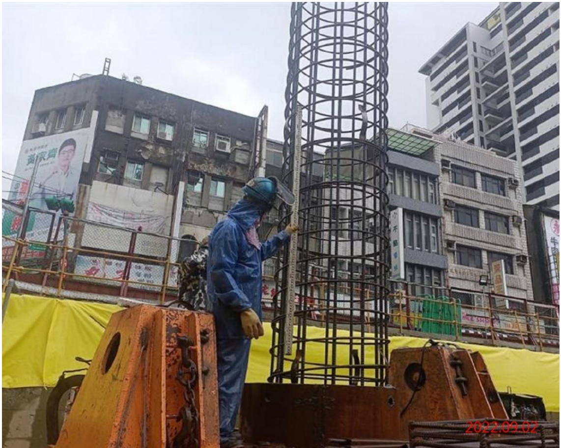
G08 站_中間樁鋼筋籠吊放
