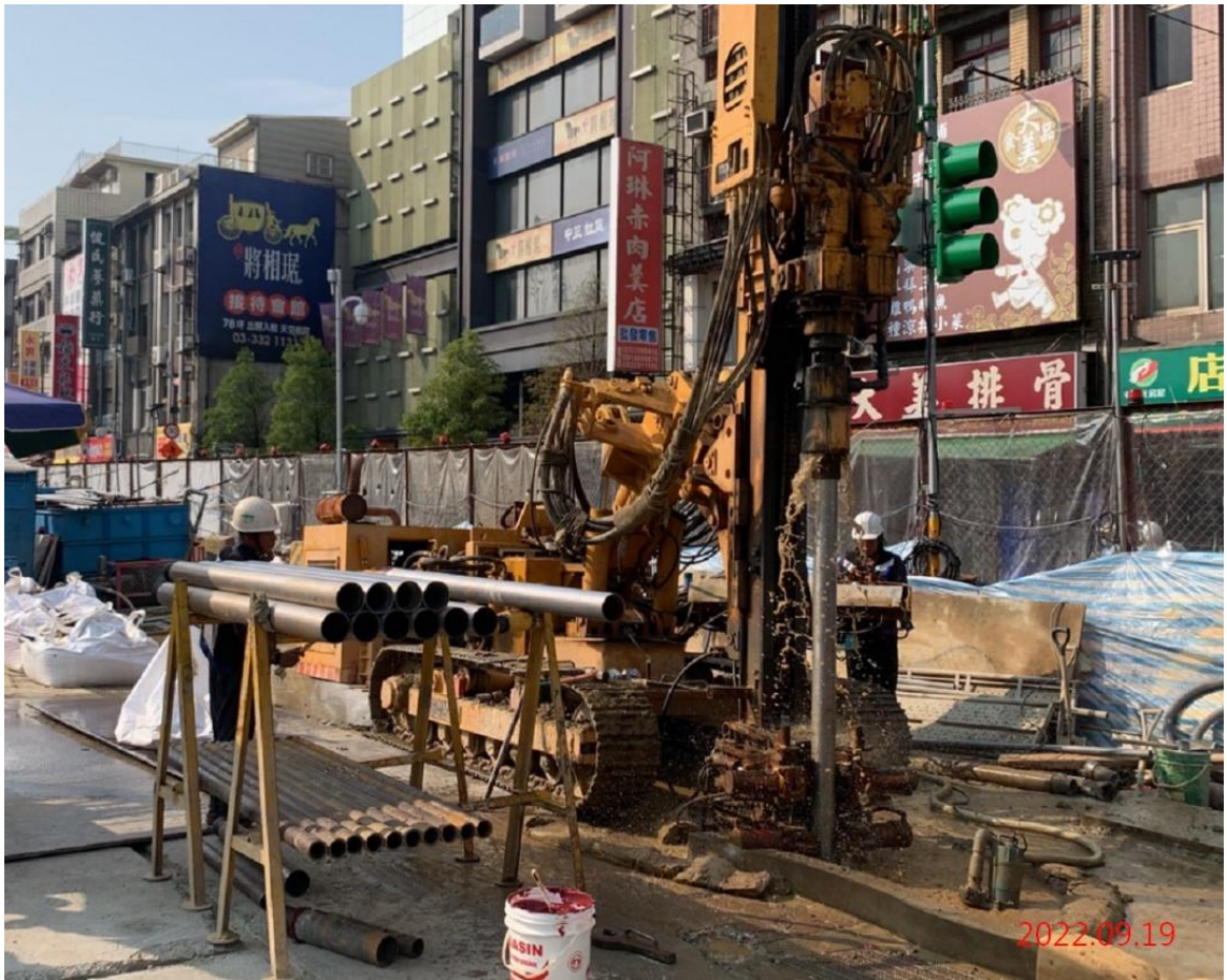
潛盾隧道_換齒區地改鑽孔
