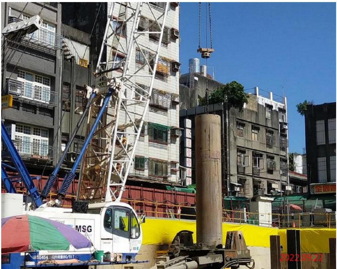
G08 站_中間樁抓掘
