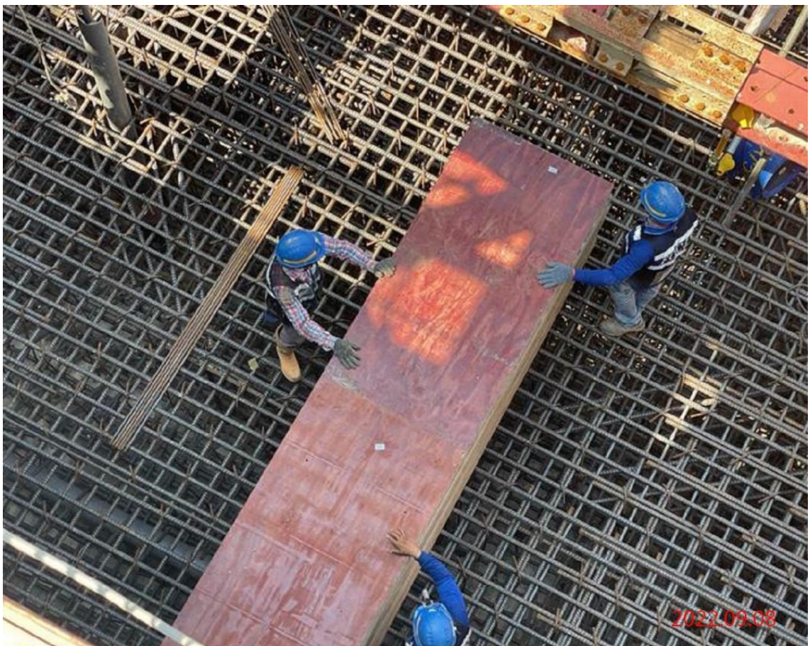
G12 站_站體模板組立
