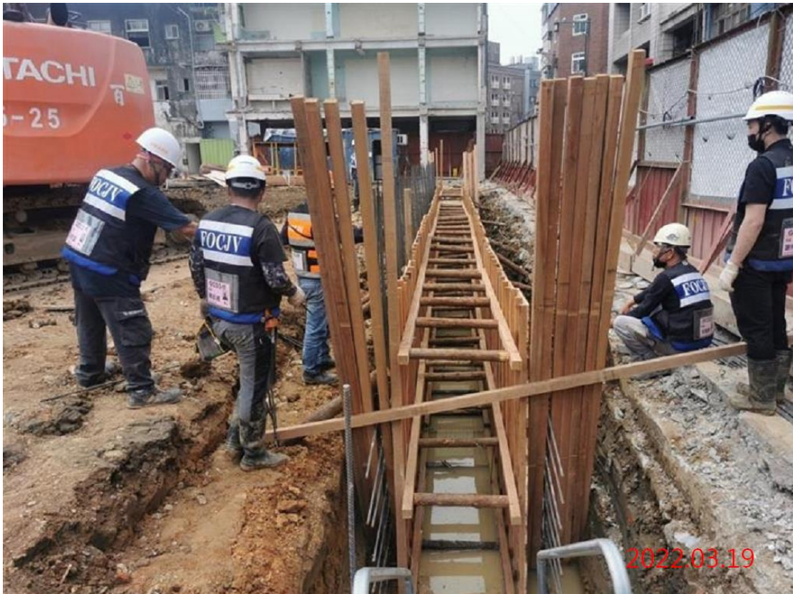
G09 站_連續壁導溝施作
