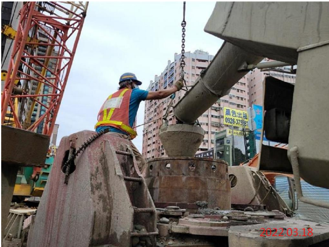
G10 站_中間柱混凝土澆置
