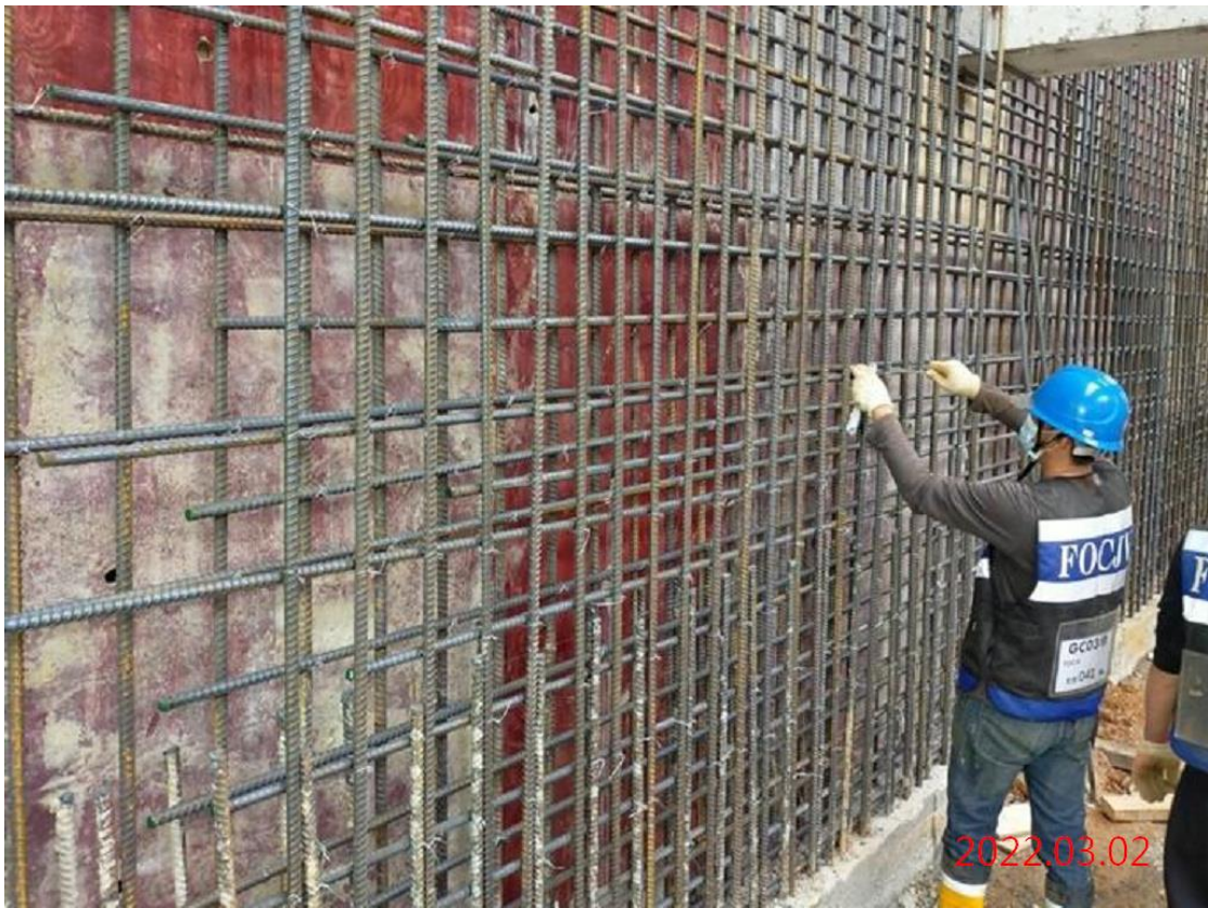
G08 站_連續壁深導溝鋼筋綁紮
