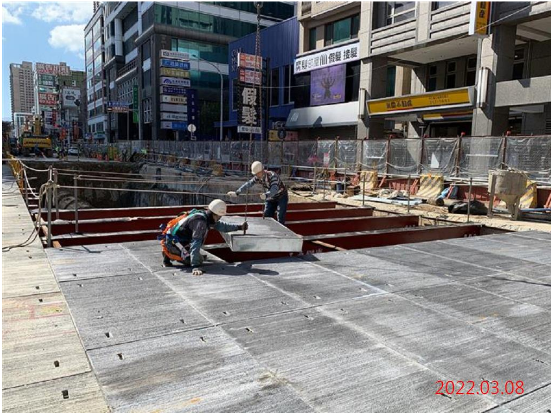
G11 站_站體西側淺挖及覆工
