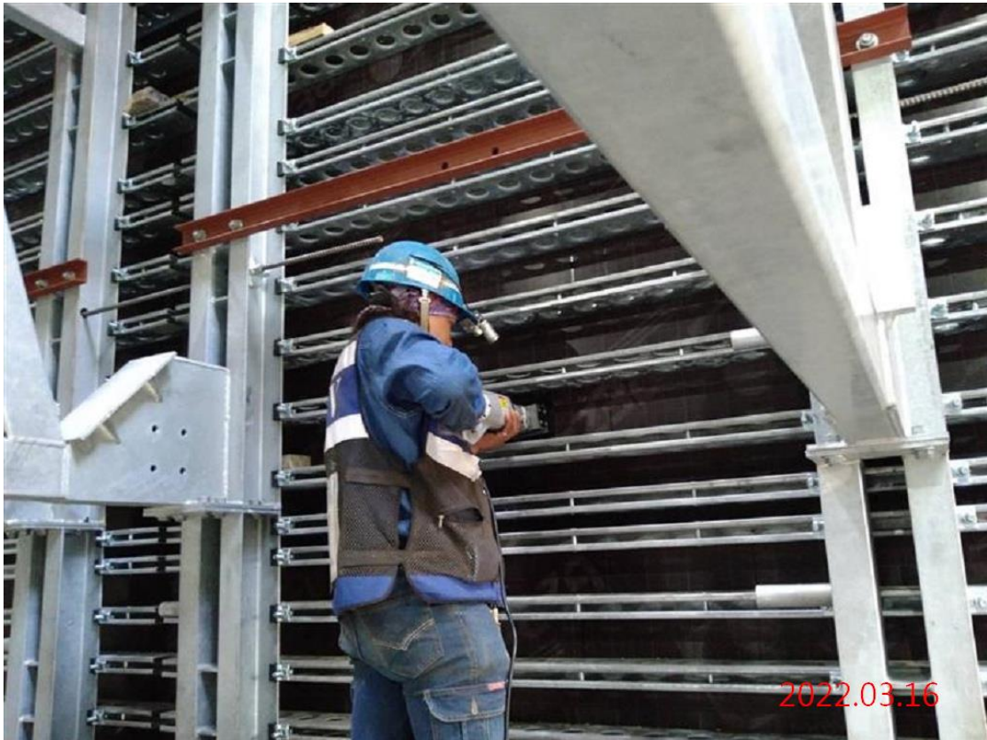
G12 站_站體軌道側牆模板組立
