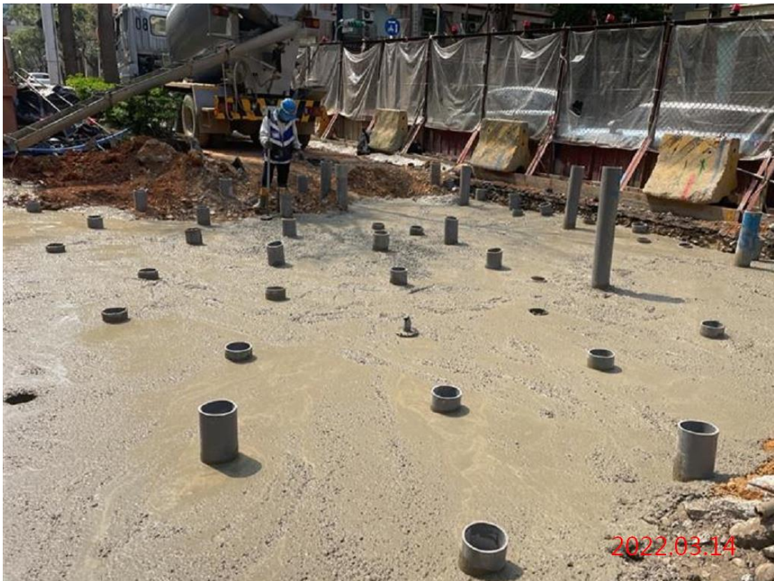
潛盾隧道_聯絡通道地質改良
