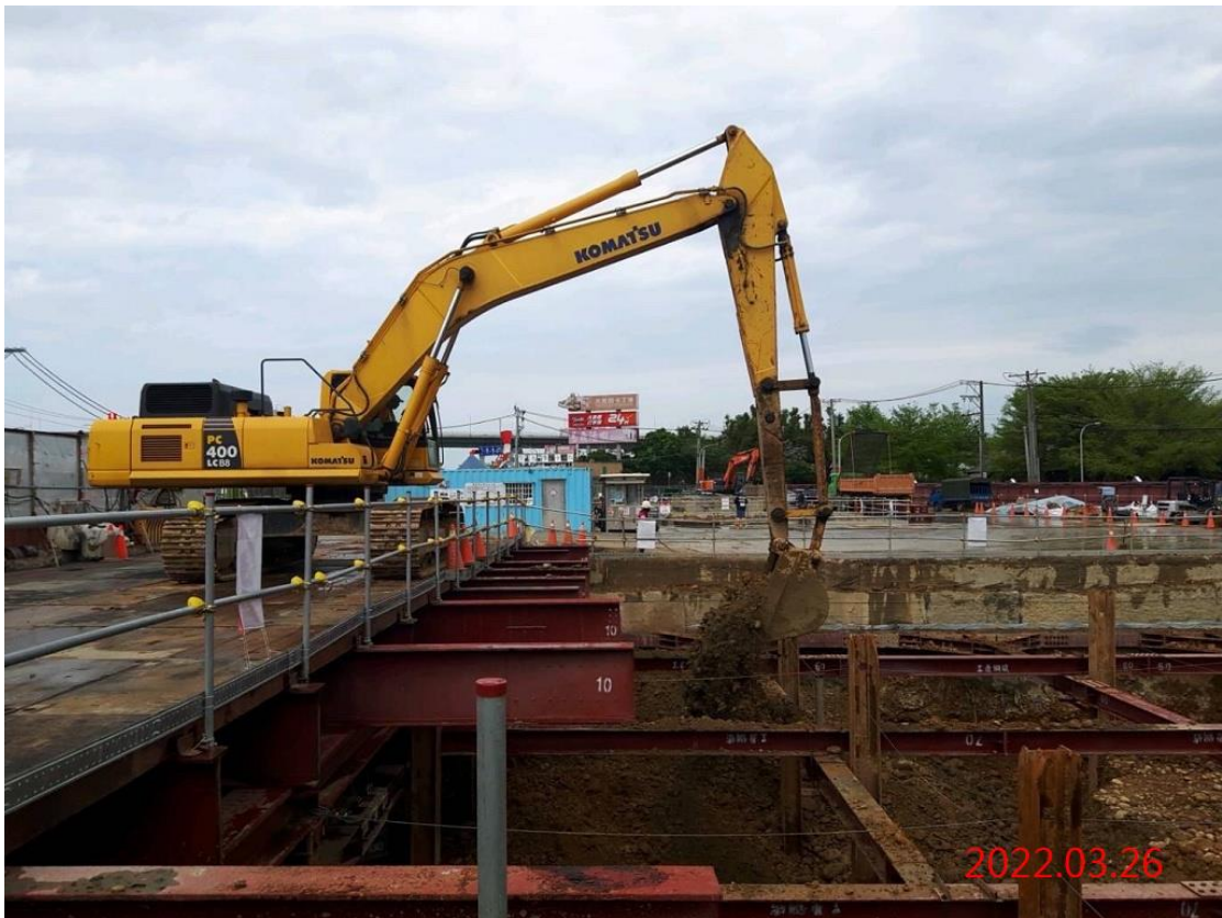
G12 站_出入口開挖及支撐作業
