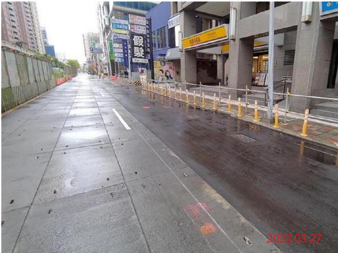
G11 站_第八階段交維移設
