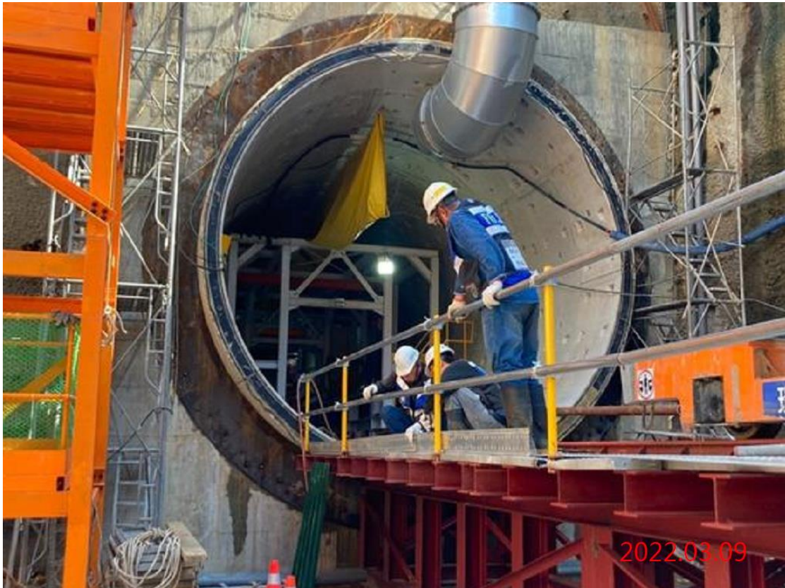
潛盾隧道_設備轉換作業
