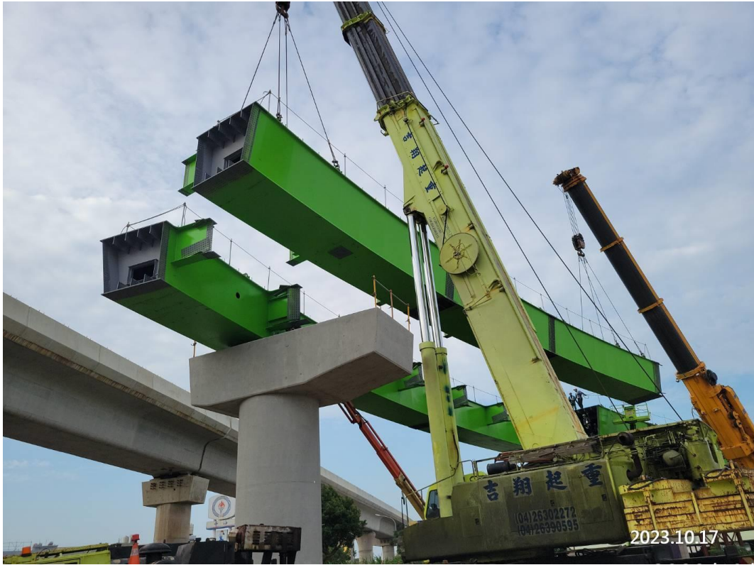
DU14a-01 鋼箱梁結塊起吊
