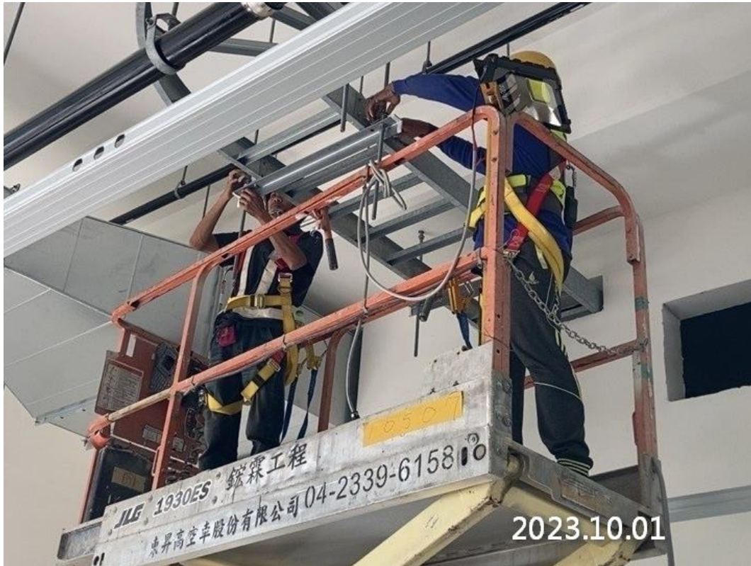
G01 站電氣管路施工
