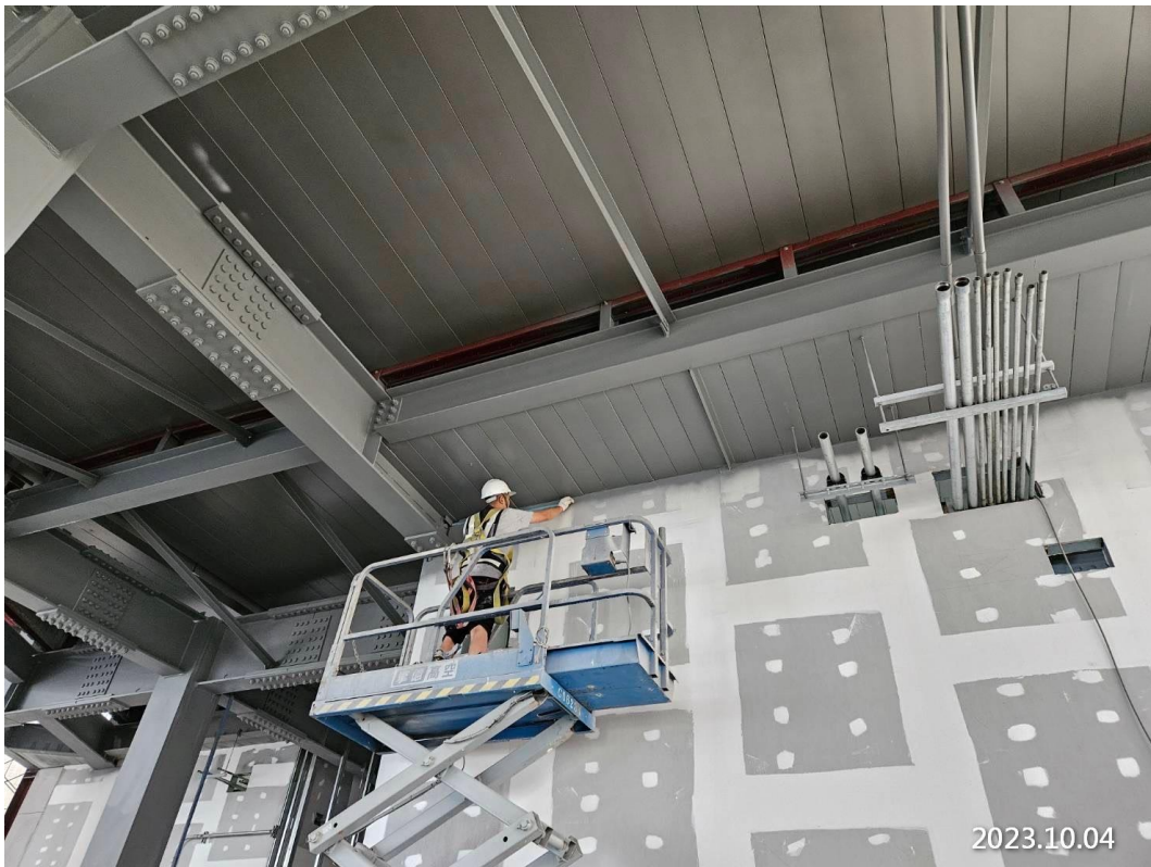
G13a 車站站體穿堂層防火填塞
