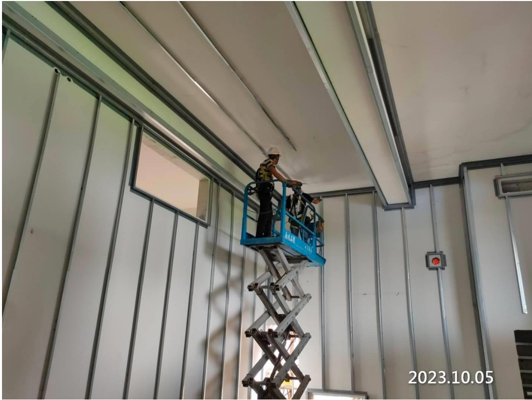
G01 車站出入口三樓機房吸音牆板施作
