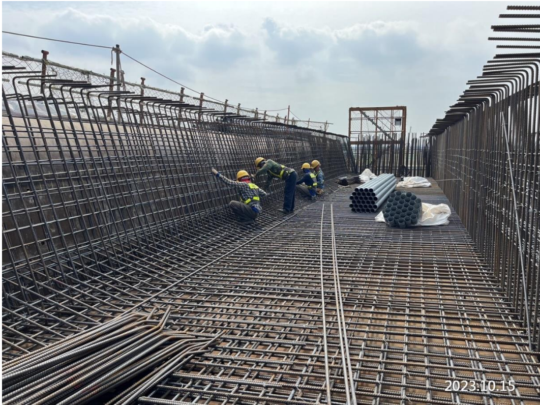
P14-29~PD-1 第一階段隔梁底腹版鋼筋綁紮
