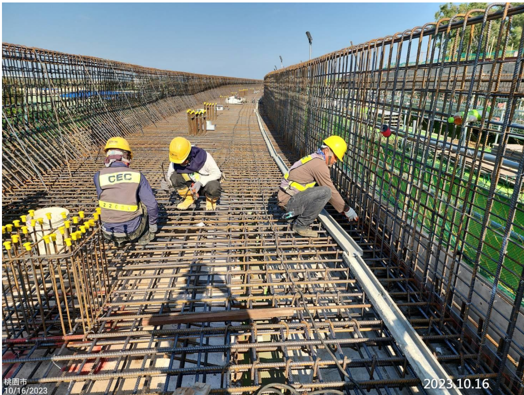
DU14-03 下行線鋼橋面排水格柵安裝,底模組立
