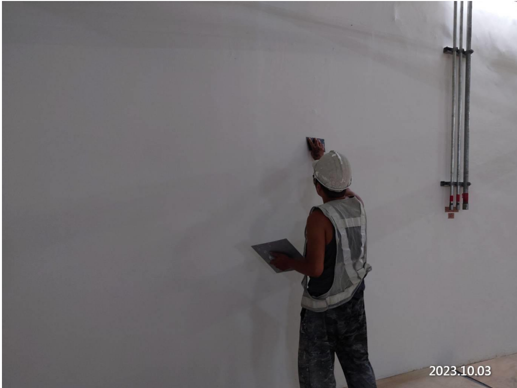
G13 車站出入口一樓油漆修整
