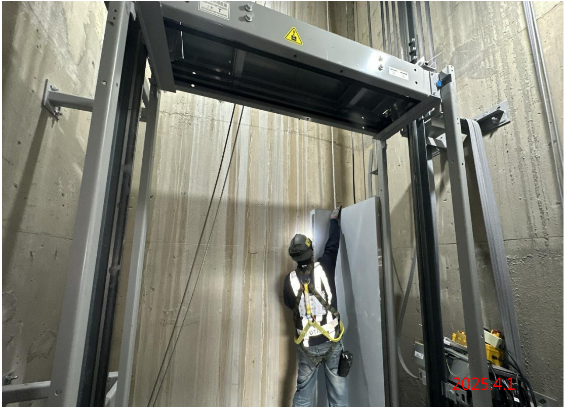
G13 站 1 號電梯車廂安裝作業
