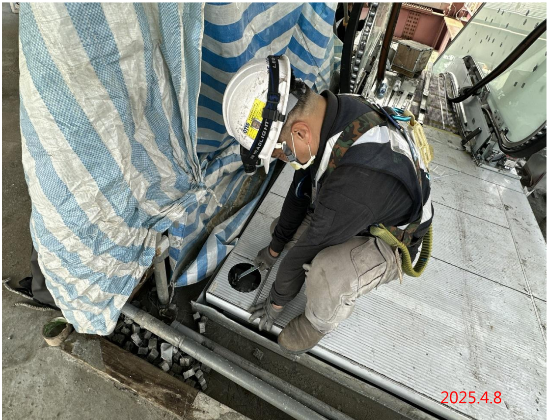
G15a 站 5-6 號電扶梯床板安裝調整作業
