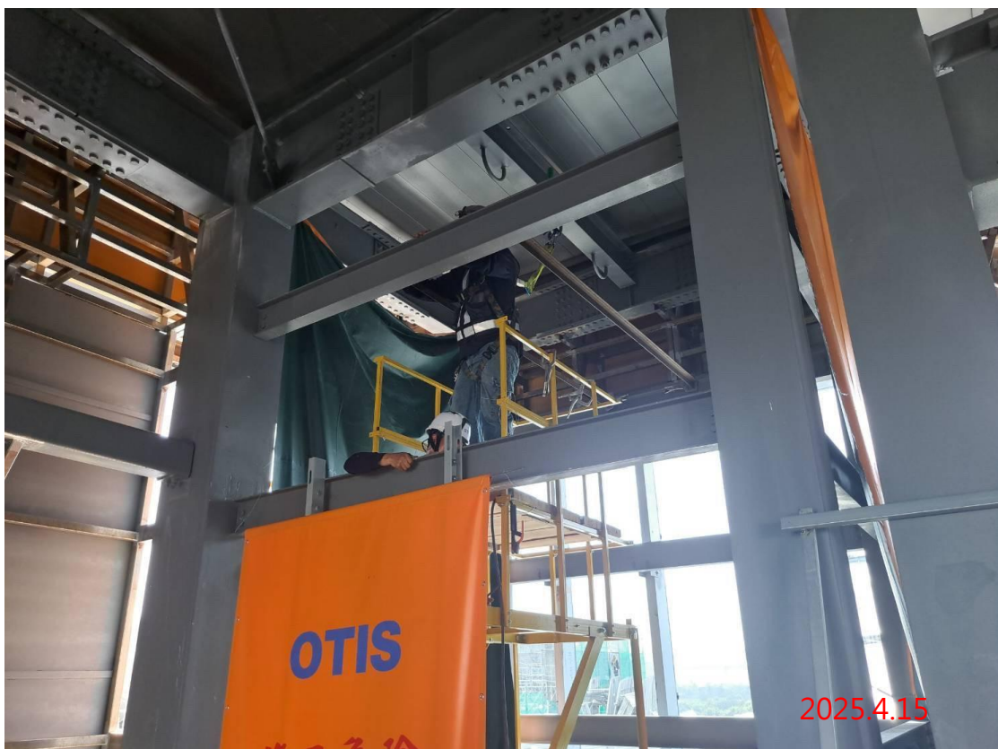
G13 站 2 號電梯定芯作業
