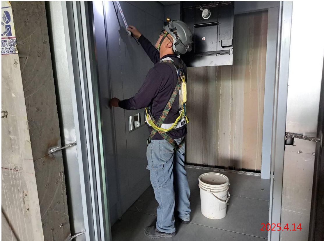
G13 站 1 號電梯門板安裝作業
