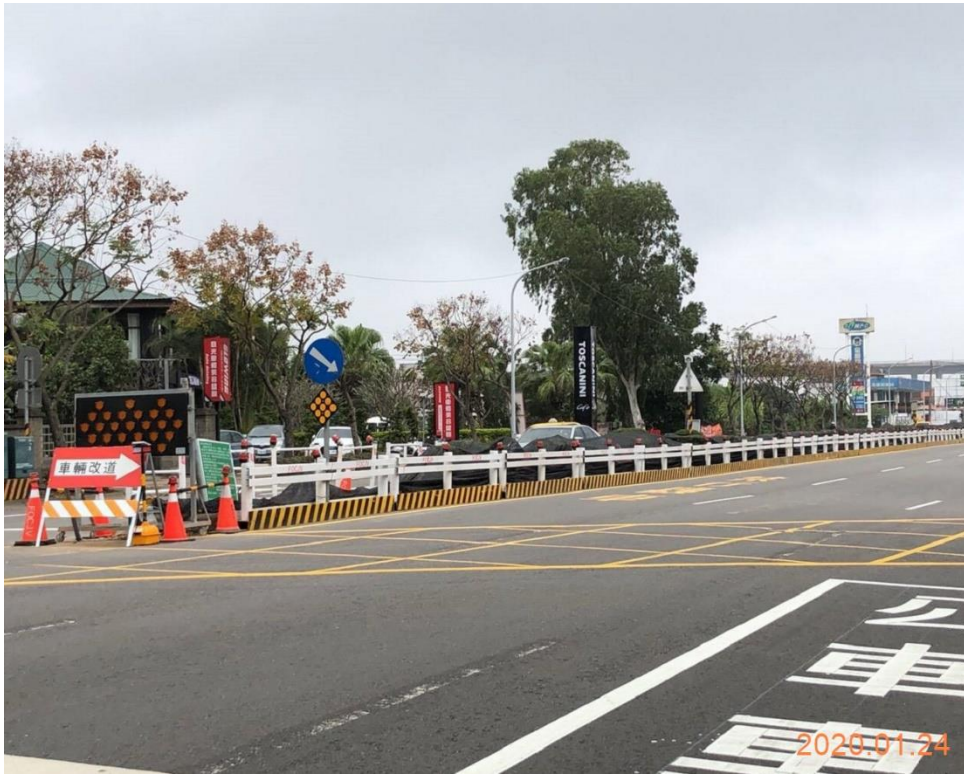
中正路路樹及地上設施遷移、人行道削減及中央分隔島敲除
