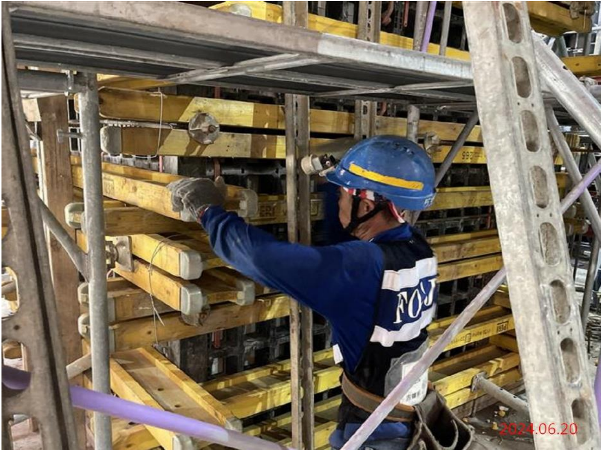
G09_B4F 獨立柱混凝土澆置
