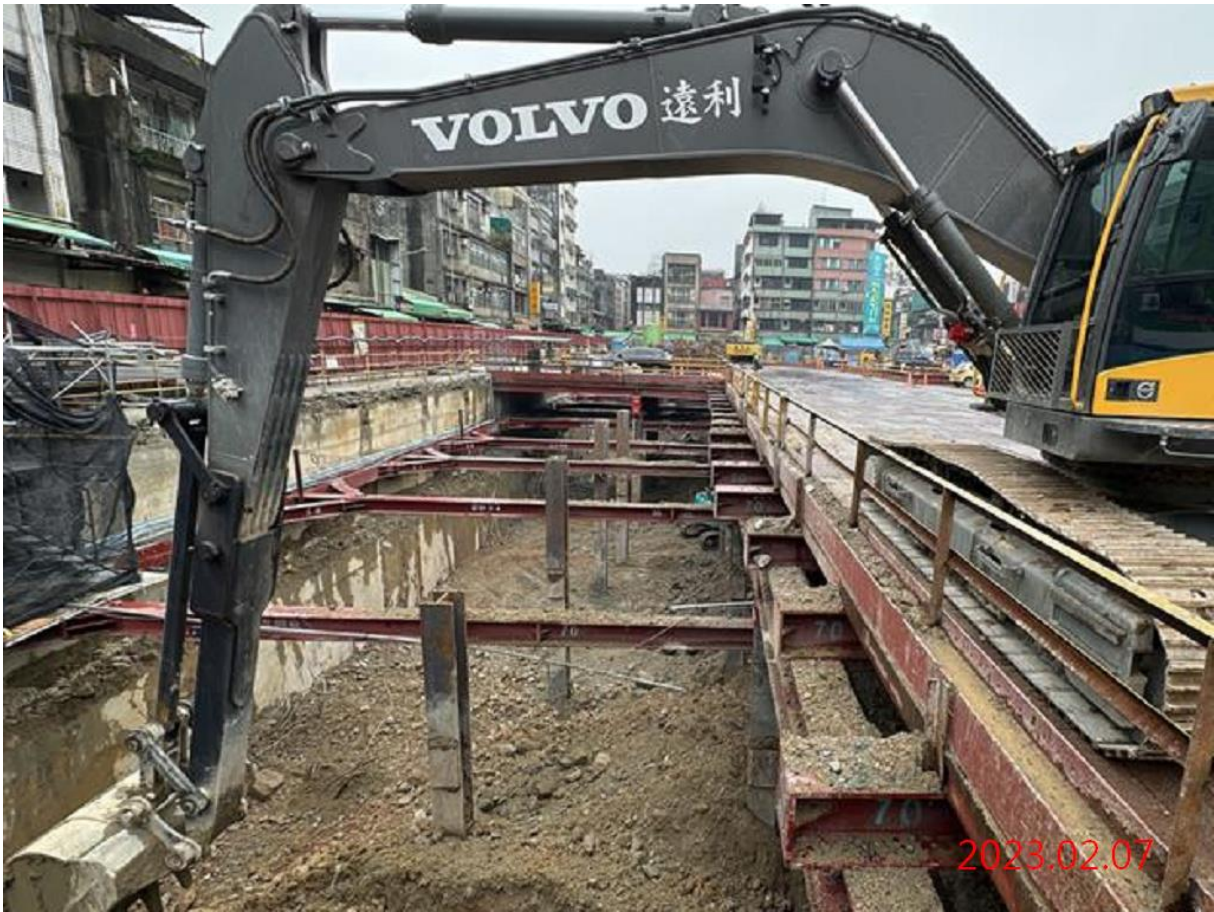
G08 站_站體第二層開挖
