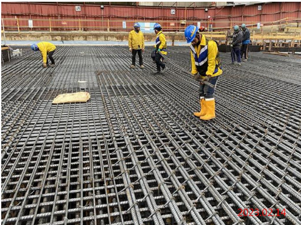
G07 站_站體結構 1FL 版鋼筋綁紮
