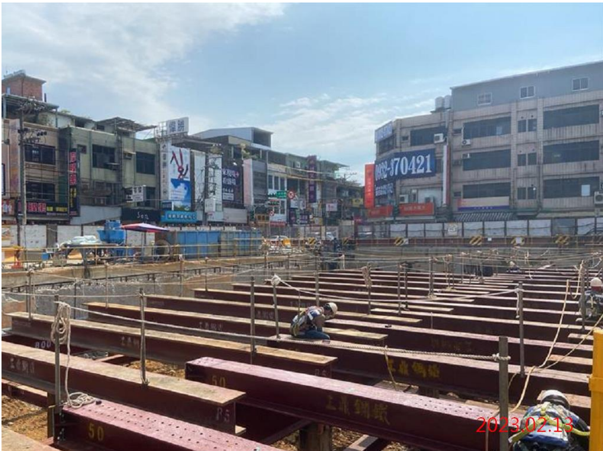
G09 站_站體覆工系統施作
