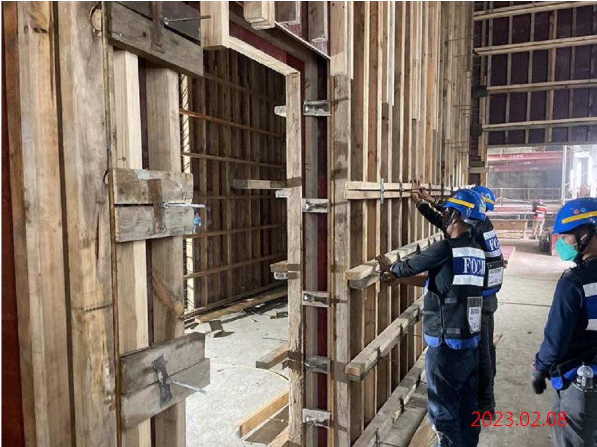
G12 站_站體穿隔間牆模板組立
