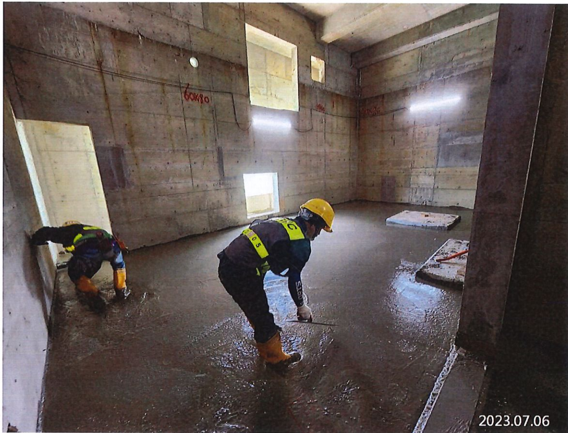
G32 車站出入口三樓混凝土墊層澆置
