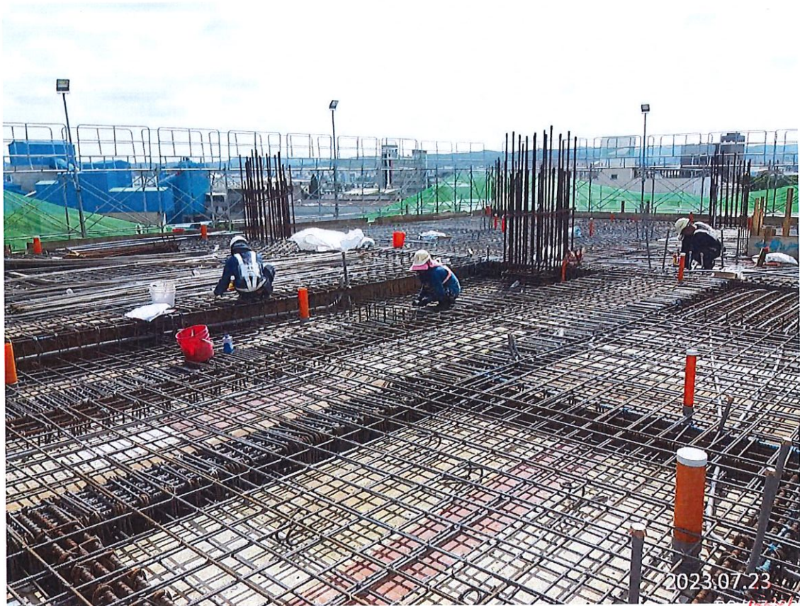
G14 車站出入口三樓梁版鋼筋綁紮
