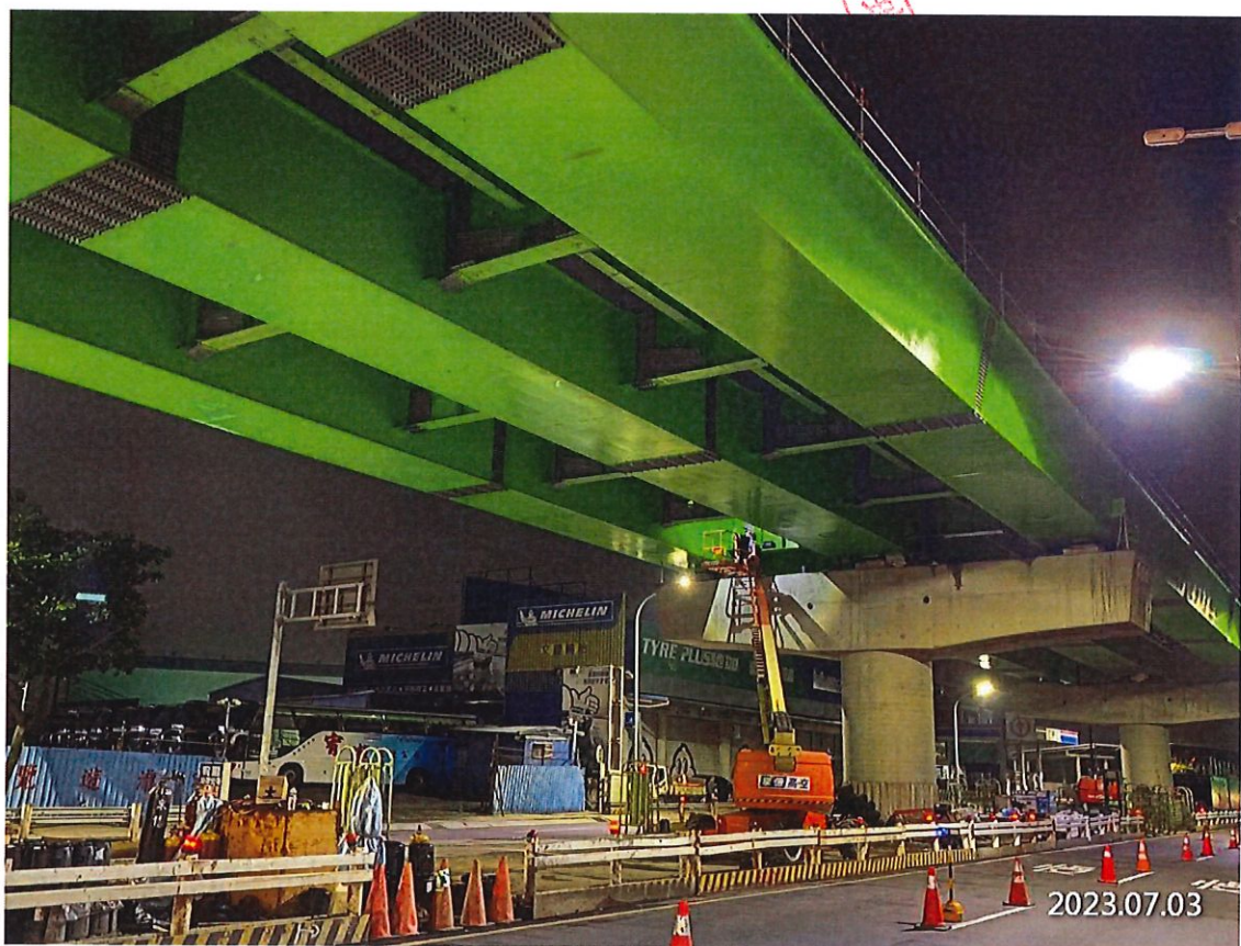
北段 DU14-01 橫縱梁螺栓穿鎖
