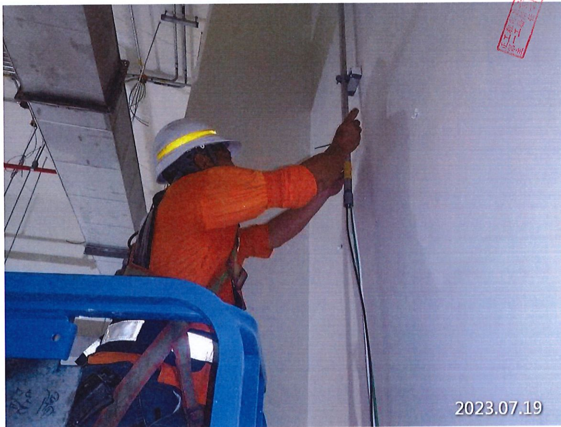
G13a 車站月台層機房電氣管路施作
