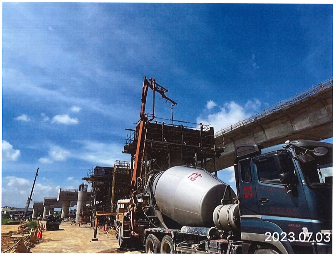
北段帽梁 PD-03 盤支混凝土澆置
