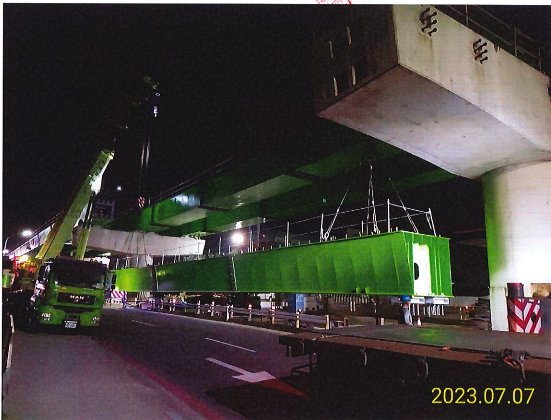
北段 DU14-02 鋼箱梁吊裝
