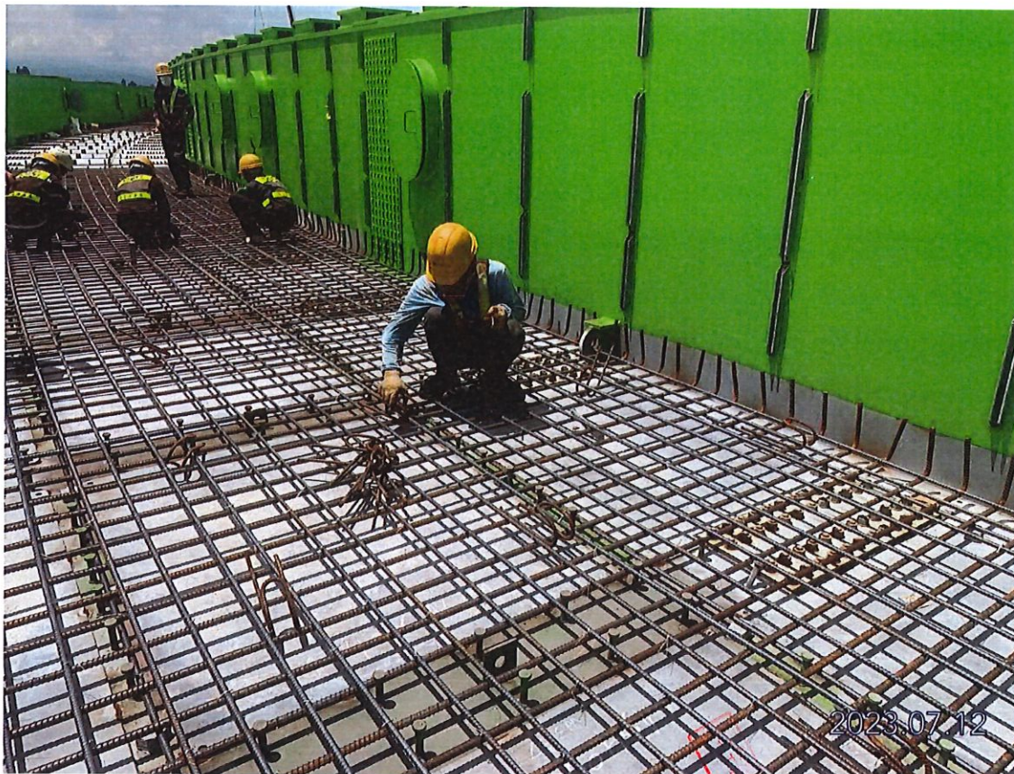
北段 DU13a-11 鋼筋綁紮
