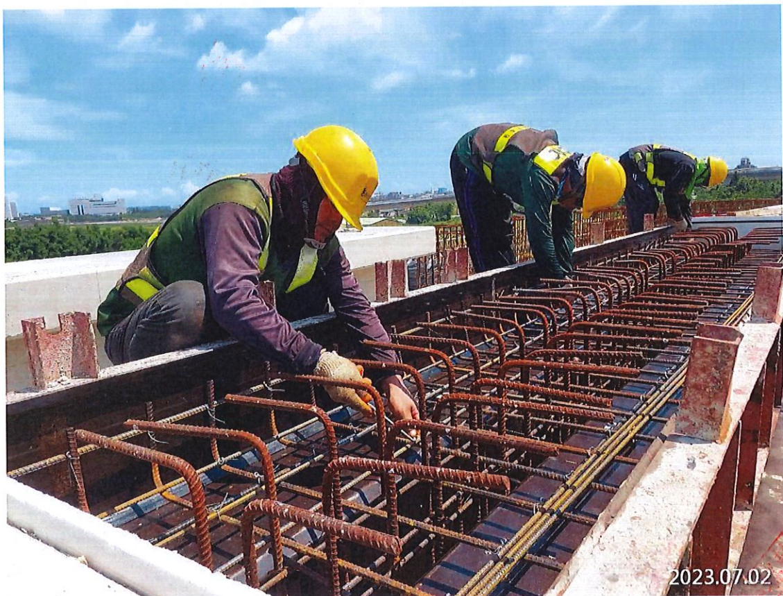
北段 DU31-09 中央走道鋼模組立、鋼筋綁紮
