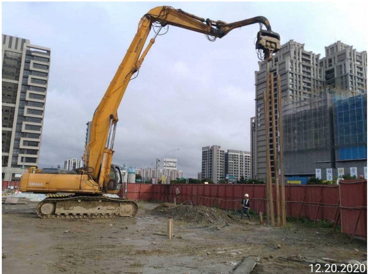
八德新闢道路 樁帽鋼軌樁打設
