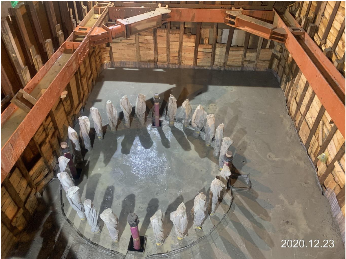
蘆竹中正北路 樁帽混凝土澆置完成
