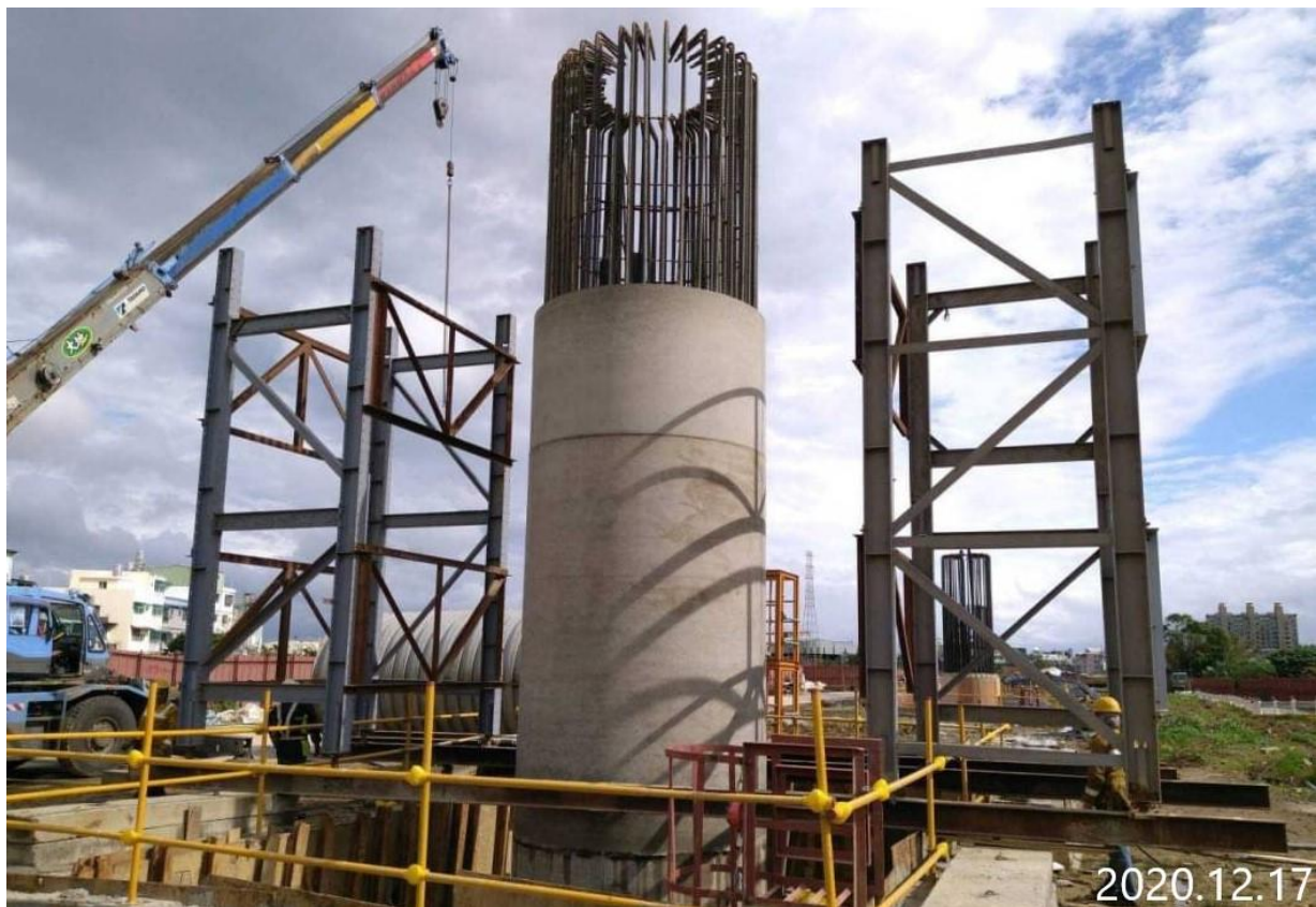
八德新闢道路 墩柱混凝土澆置完成
