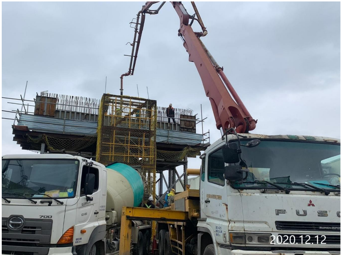
蘆竹中正北路 帽梁混凝土澆置
