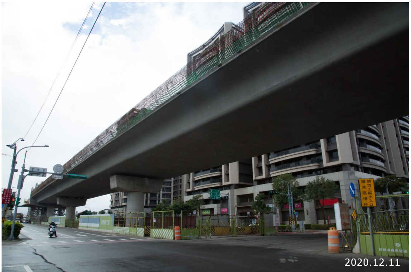
八德建德路 場鑄箱型梁橋面版施作情形
