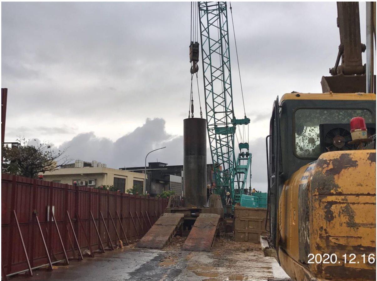
蘆竹中正北路 基樁鑽掘
