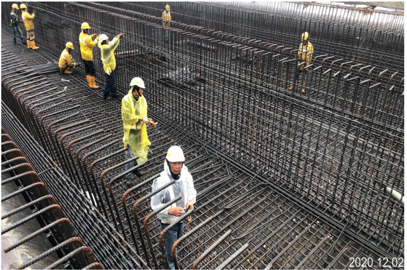
八德建德路 場撐箱型梁橋面版鋼筋綁紮
