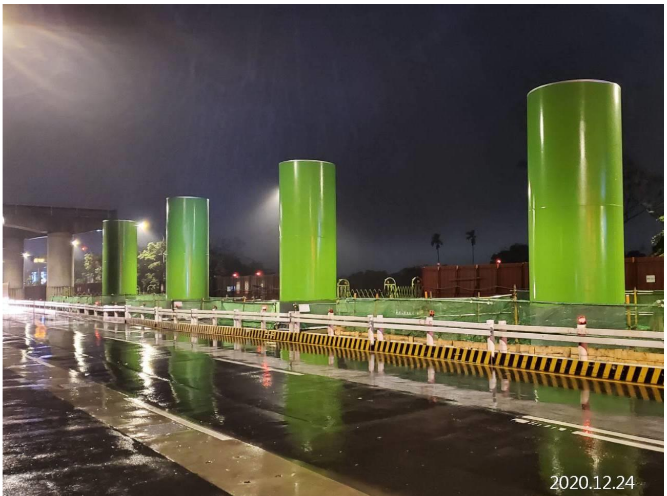
蘆竹中正北路 G13 車站鋼柱吊裝完成
