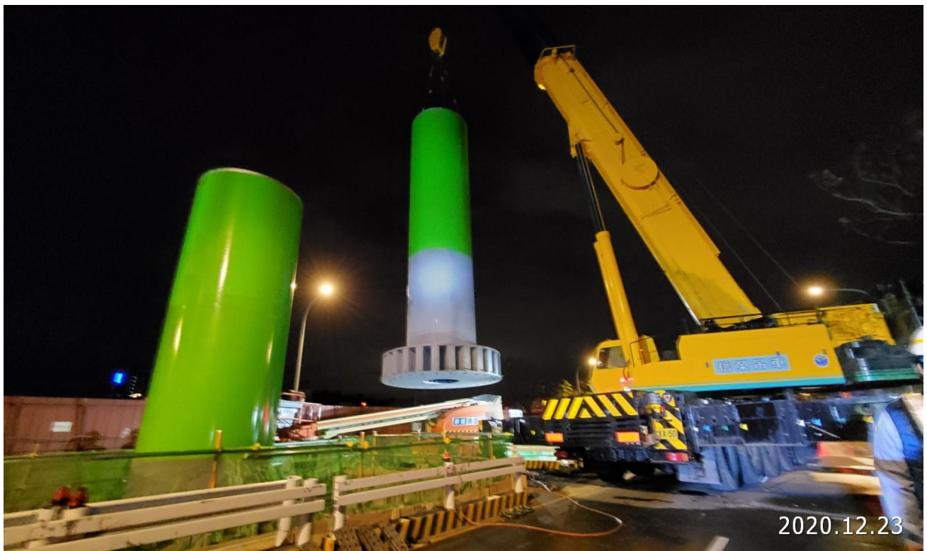
蘆竹中正北路 G13 車站鋼柱吊裝
