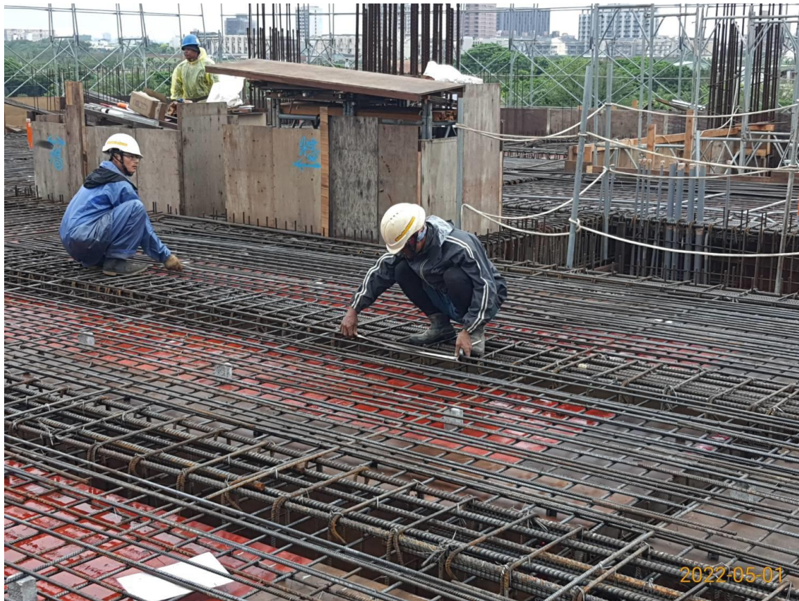
大園坑菓路 G32 車站出入口 3 樓版模板組立
