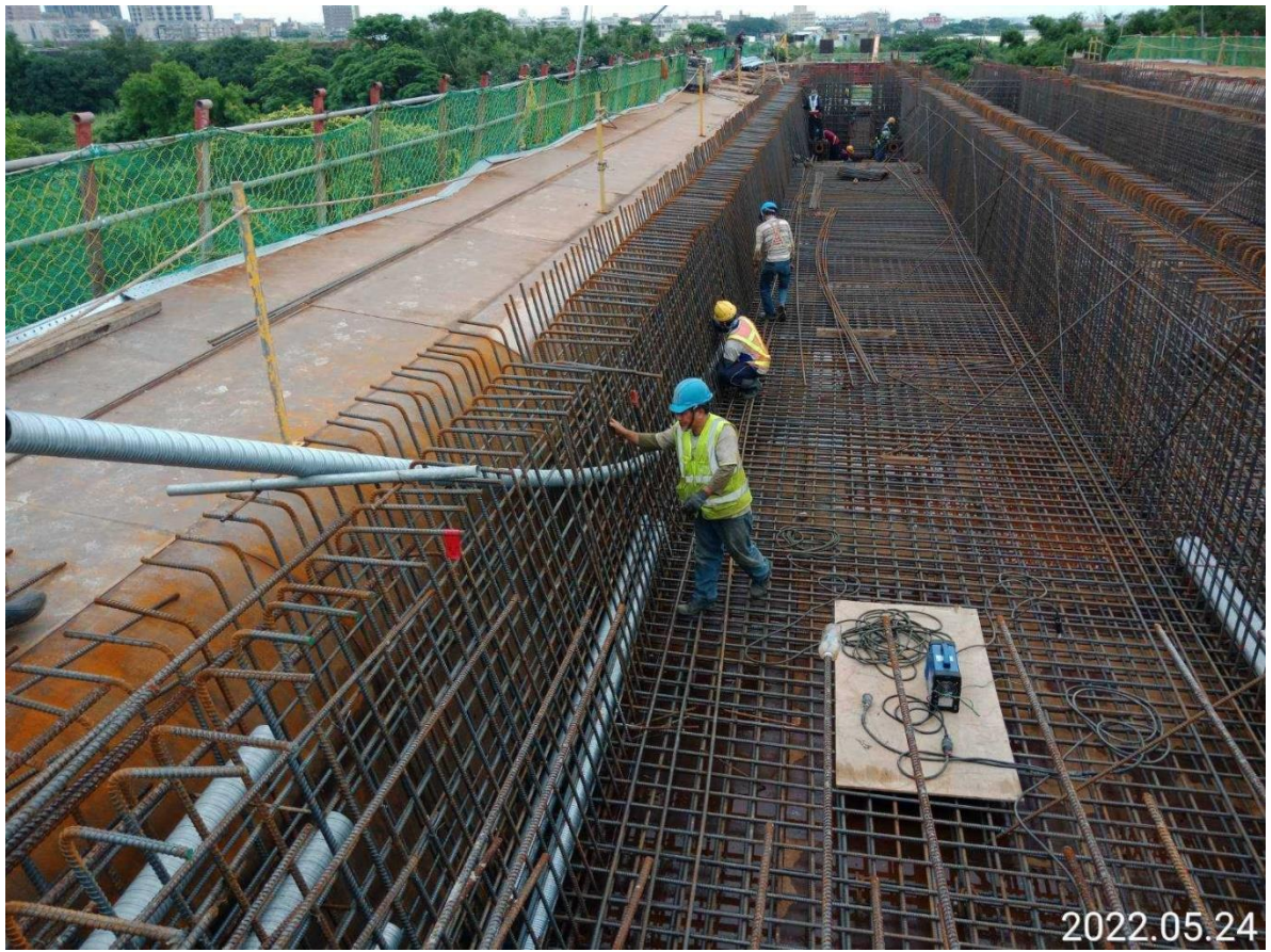
大園坑菓路 場撐箱型梁鋼筋綁紮
