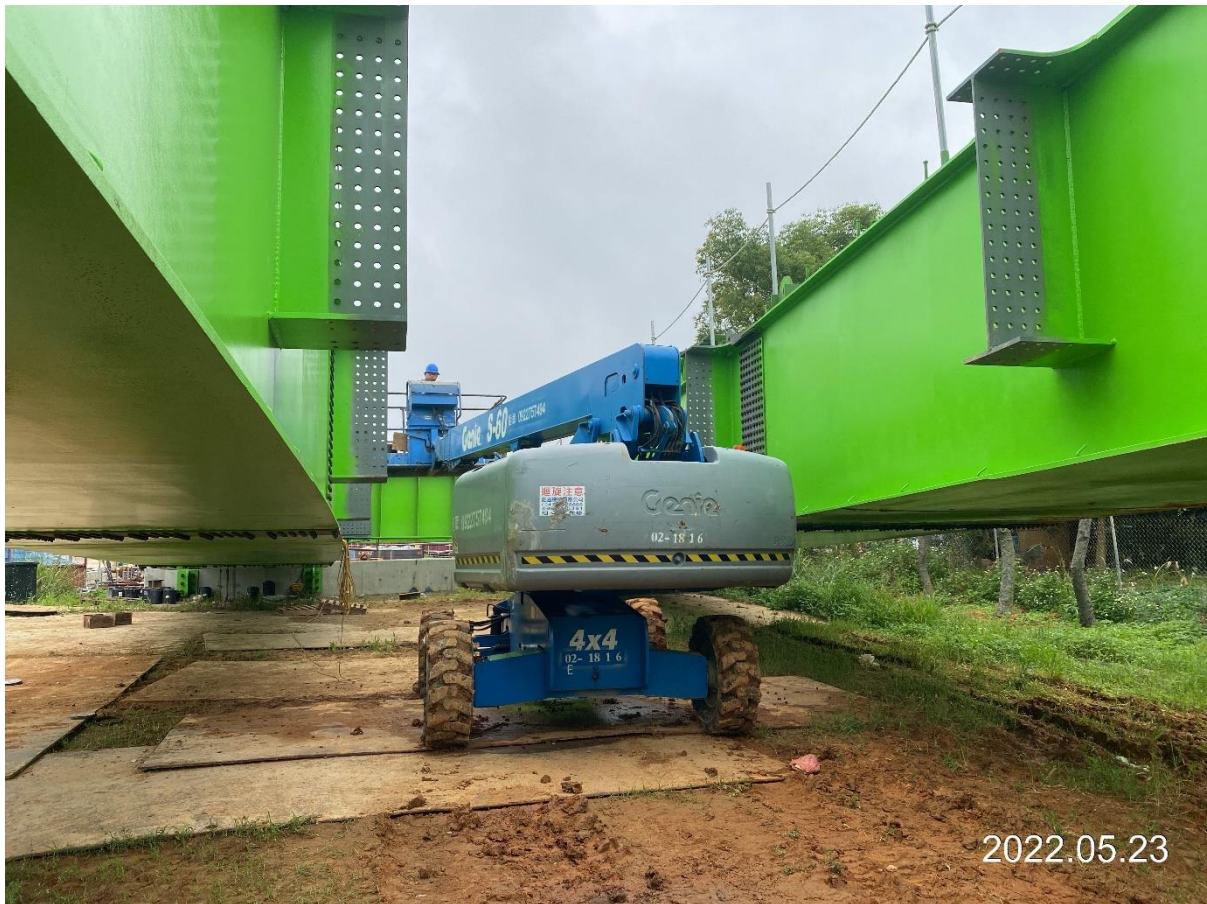
蘆竹中正北路 鋼箱梁施作
