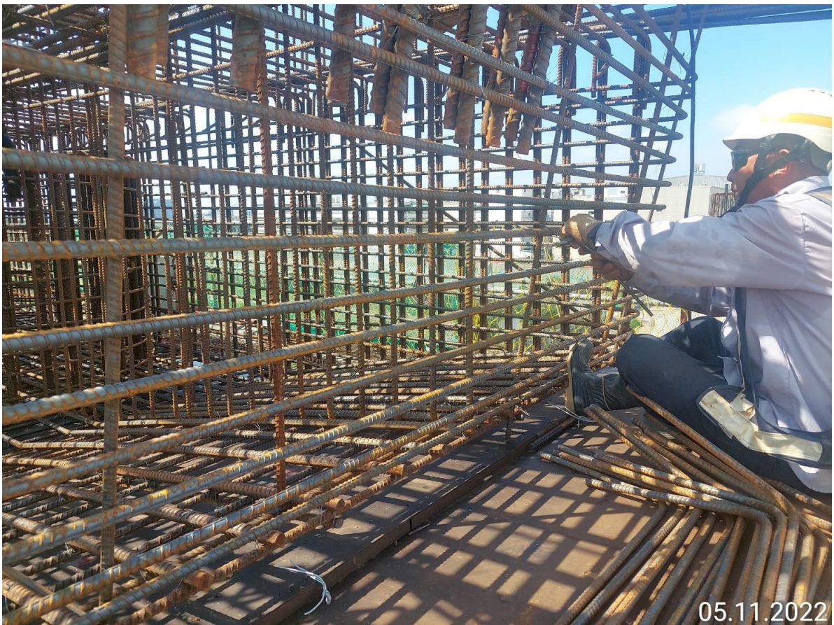
大園坑菓路 帽梁鋼筋綁紮
