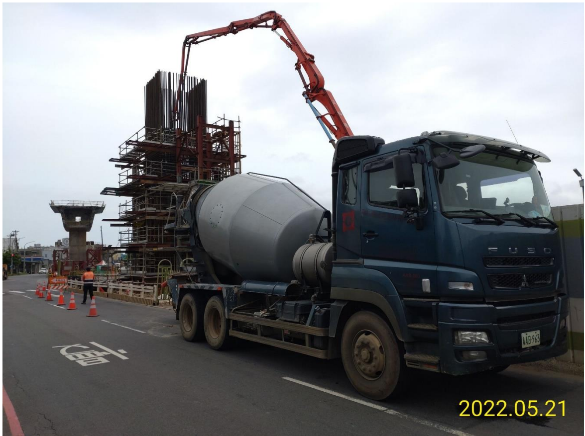
大園三民路二段 墩柱混凝土澆置
