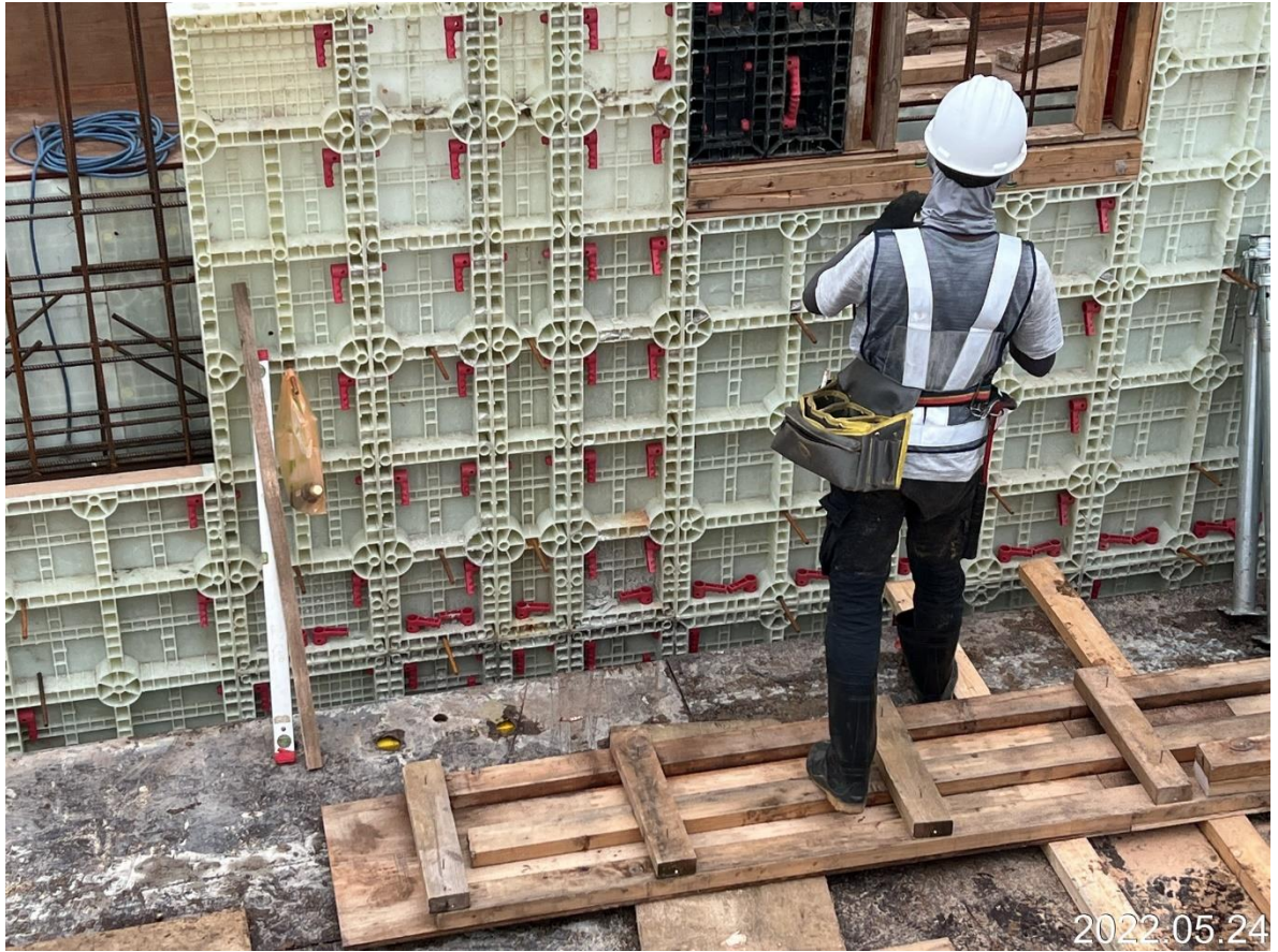
八德新關道路 G02 車站出入口模板組立
