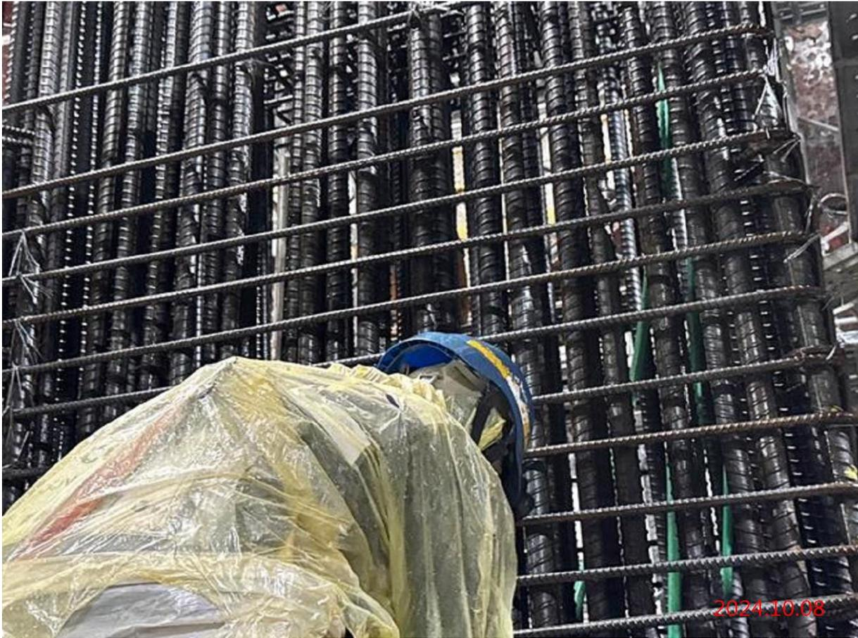
G08\_土開區 B7F 及站體區 B4F 獨立柱鋼筋綁紮
