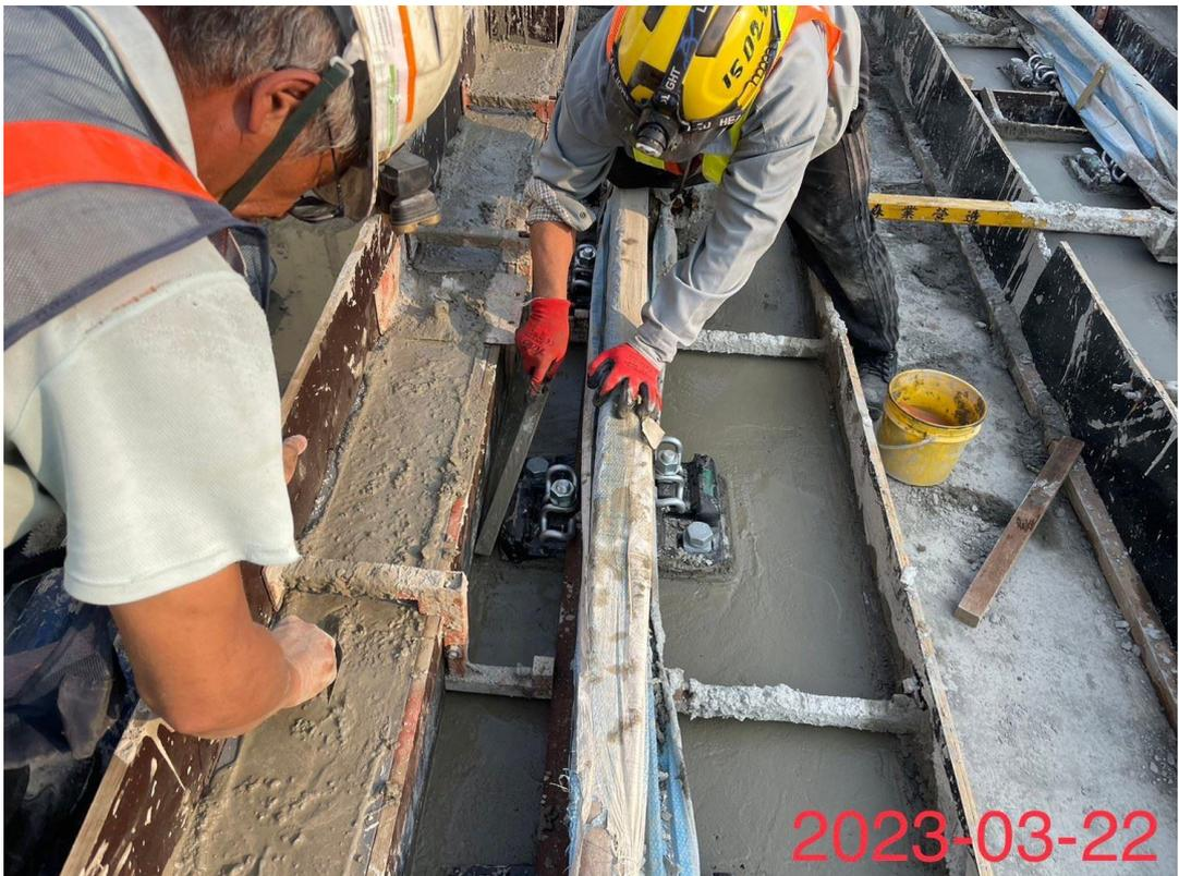
G13~G13a 上行線道床混凝土澆置(U42-U52)
