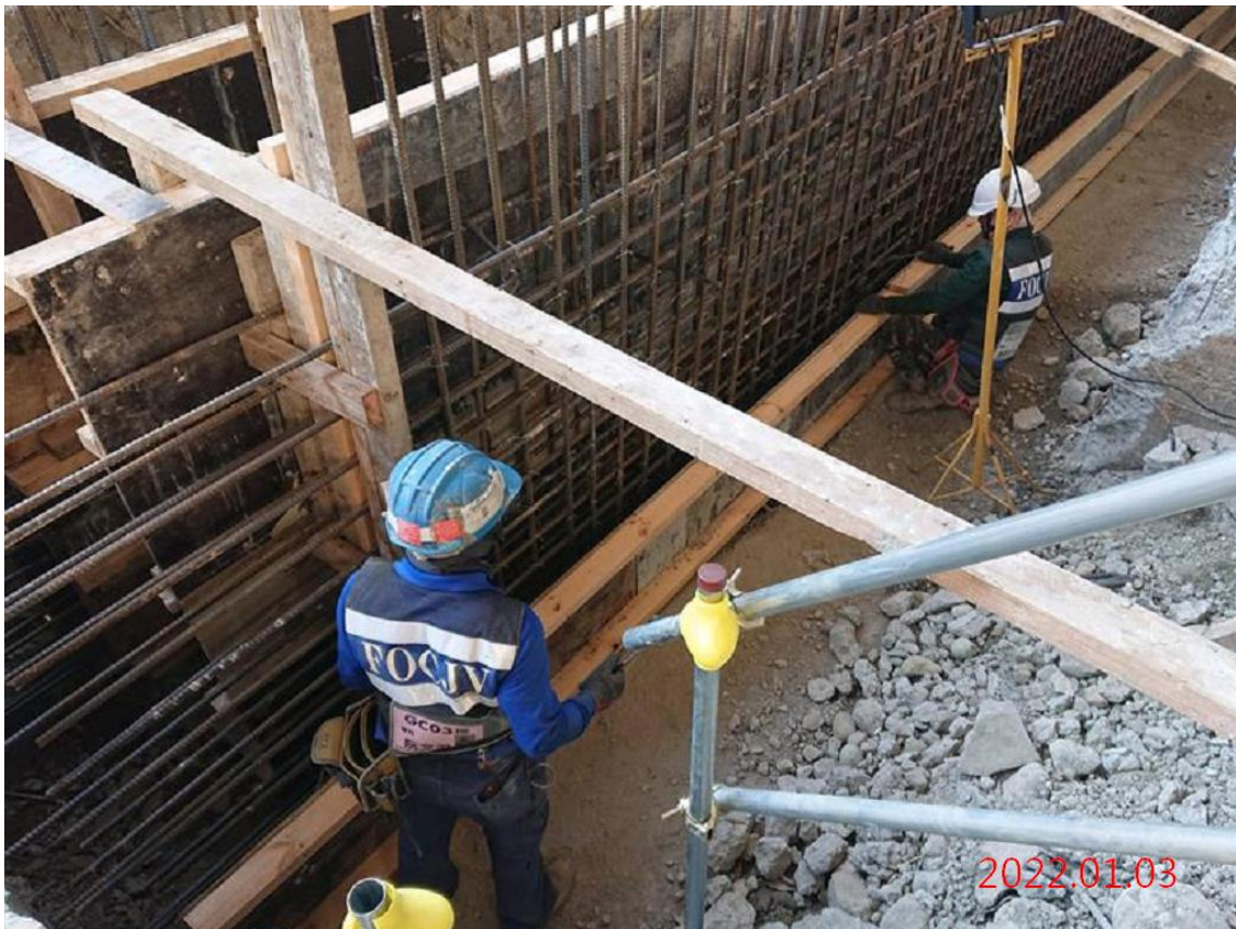
G08 站_深導溝施作
