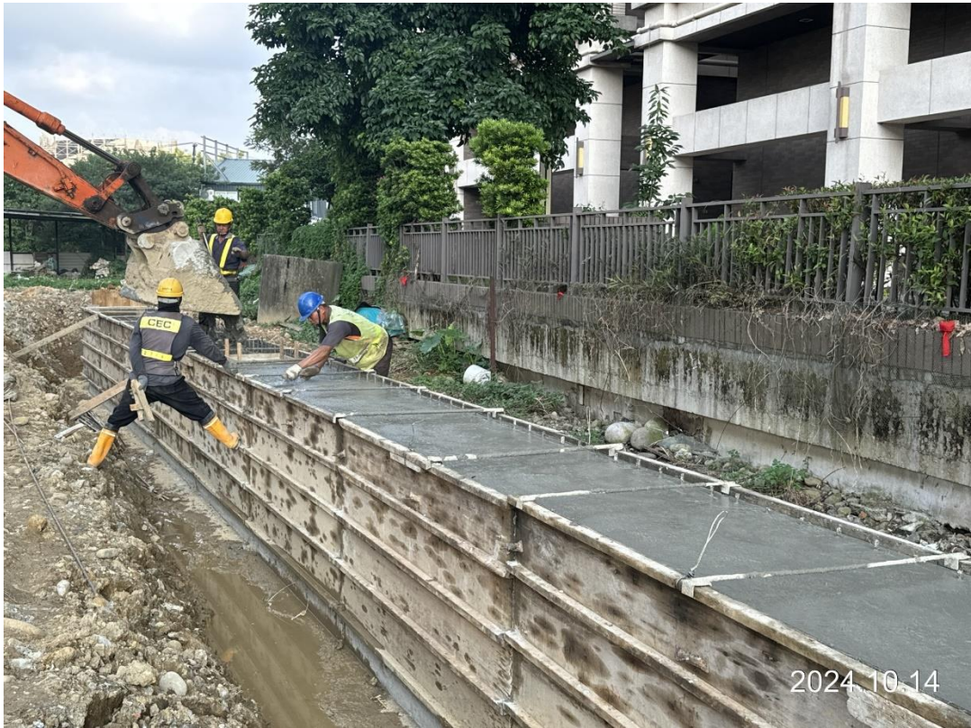
南段_邊溝（4k+520~540）頂版澆置完成
