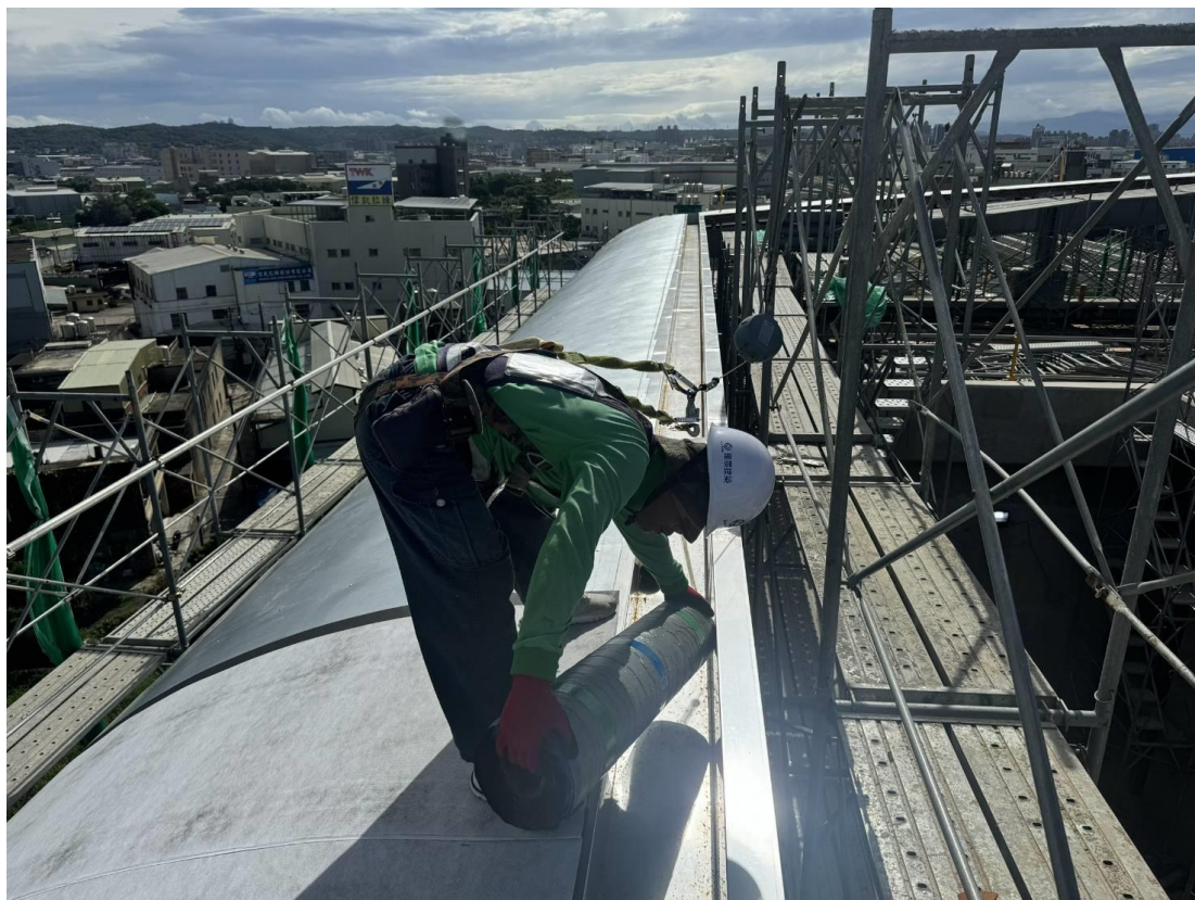
G14 車站站體金屬屋頂板屋面板施作
