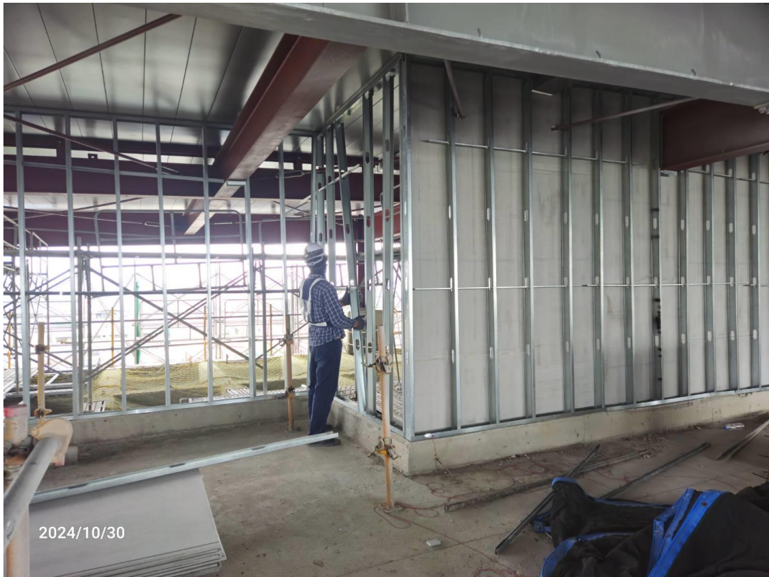
G14 車站站體屋頂層輕隔間封板
