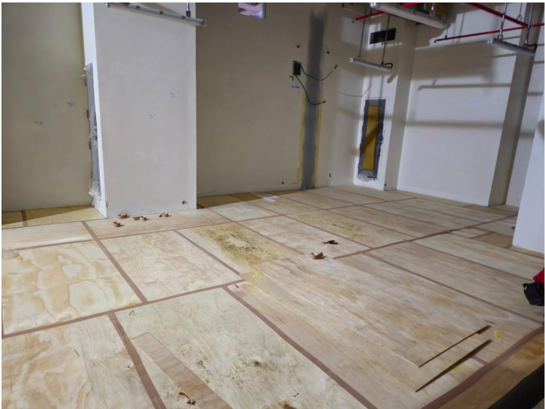
G14 車站站體移交機房地坪保護完成
