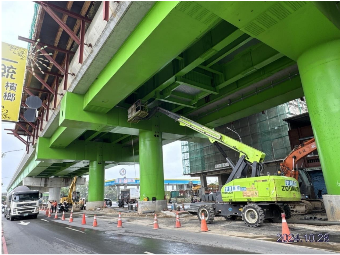
G14 站 DU14-03 排水管安裝吊裝
