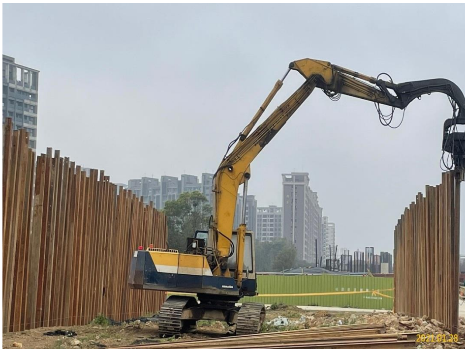
南出土段鋼軌樁打設
