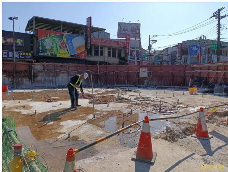
VS6 通風豎井地盤處理鑽孔施作
