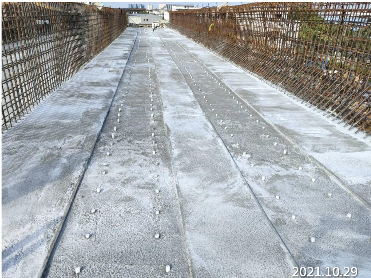
八德新關道路 場鑄箱型梁頂版混凝土澆置完成
