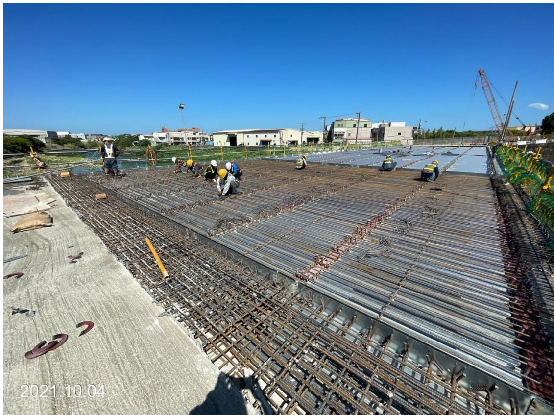
大園坑菓路 崁下橋交維便橋鋼筋綁紮
