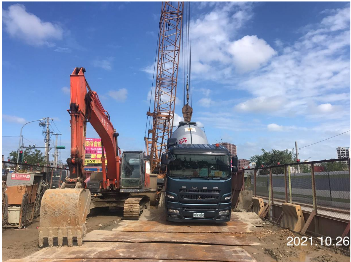
大園三民路二段 基樁混凝土澆置
