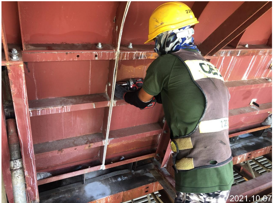
蘆竹中正北路 場撐箱型梁模板組立
