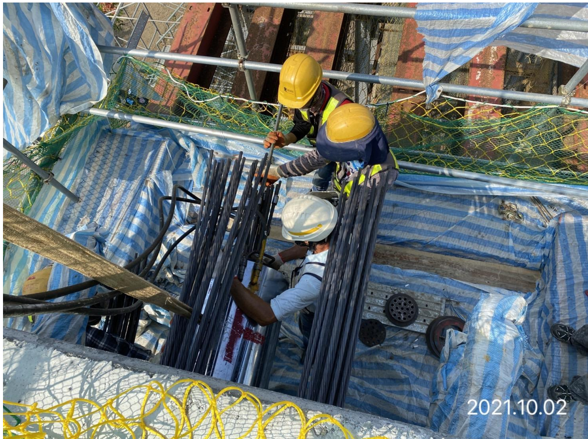
蘆竹南崁路二段 帽梁預力施拉
