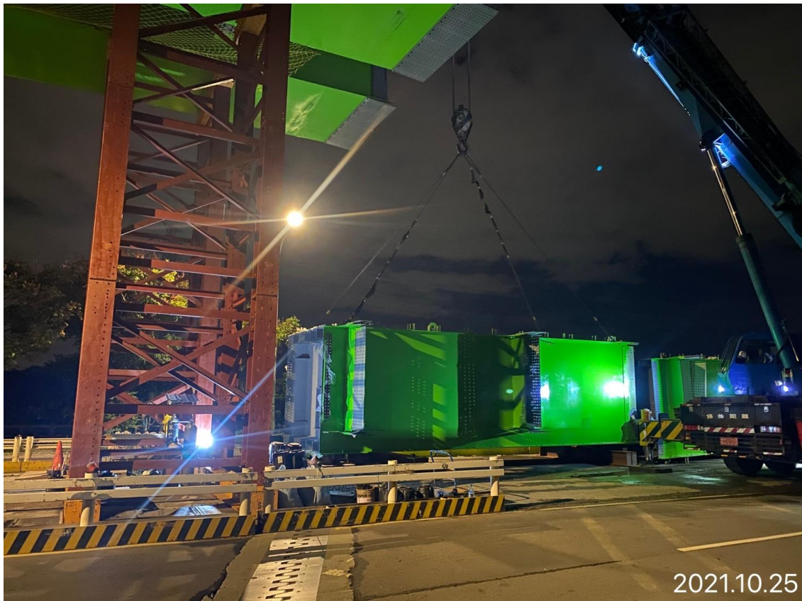
蘆竹中正北路 鋼箱型梁夜間吊裝
