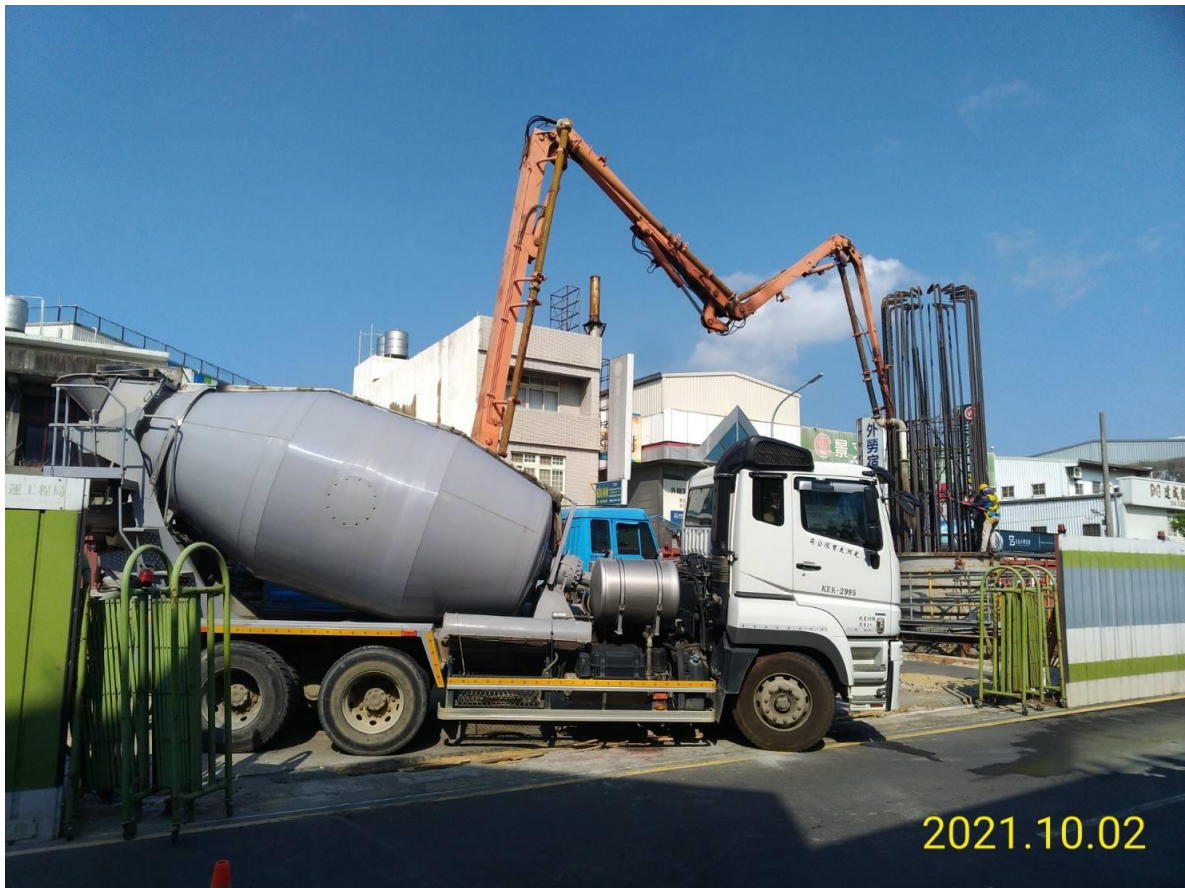
蘆竹南崁路二段 墩柱混凝土澆置
