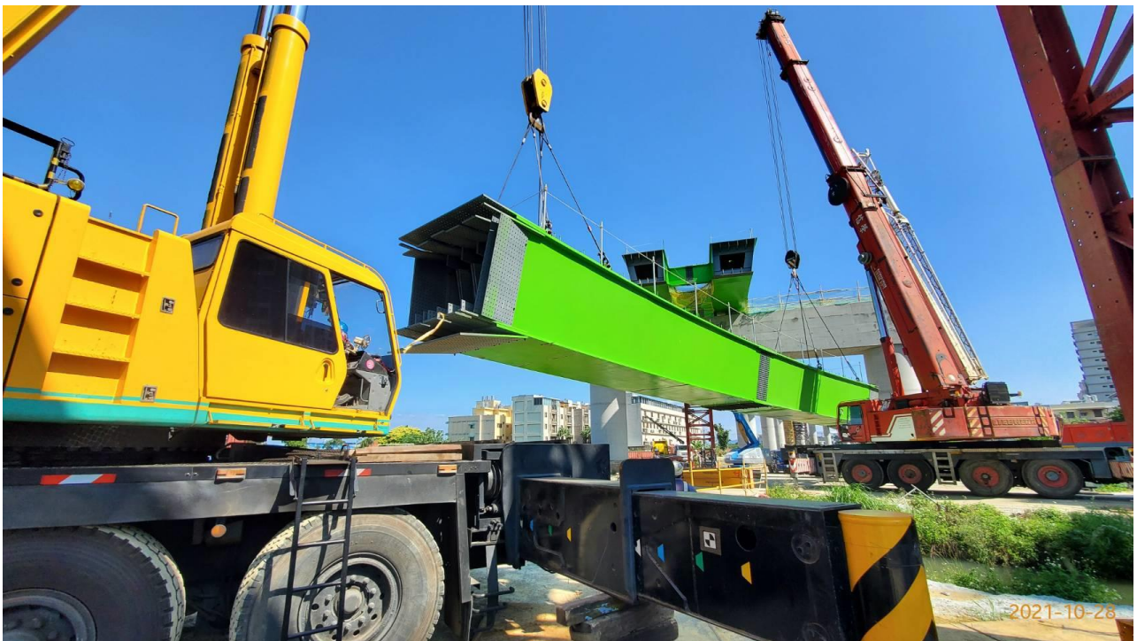
八德新闢道路 鋼箱型梁吊裝
