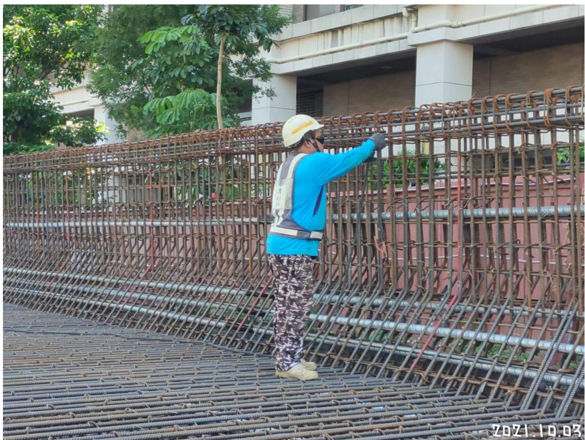
八德新關道路 預鑄混凝土 U 型梁預力套管施作
