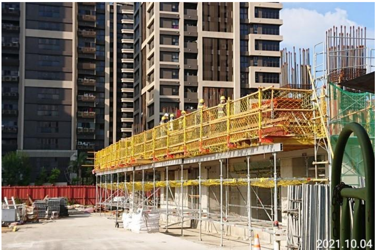
八德新闢道路 G01 車站出入口 2 樓模板組立
