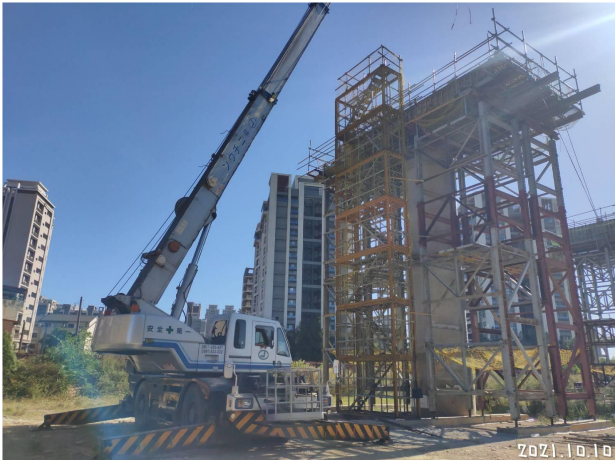
八德新闢道路 帽梁鋼模組立
