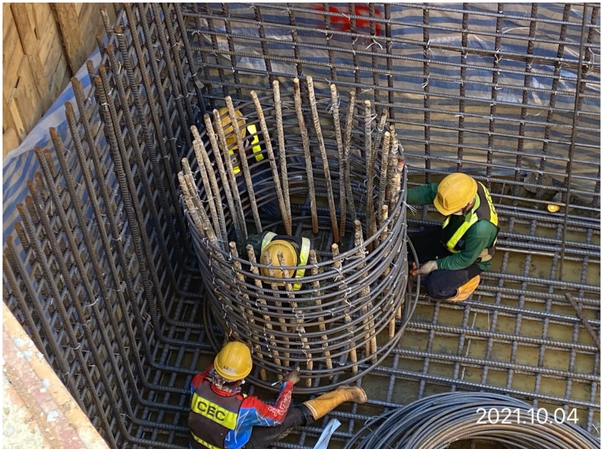
蘆竹南崁路二段 樁帽鋼筋綁紮
