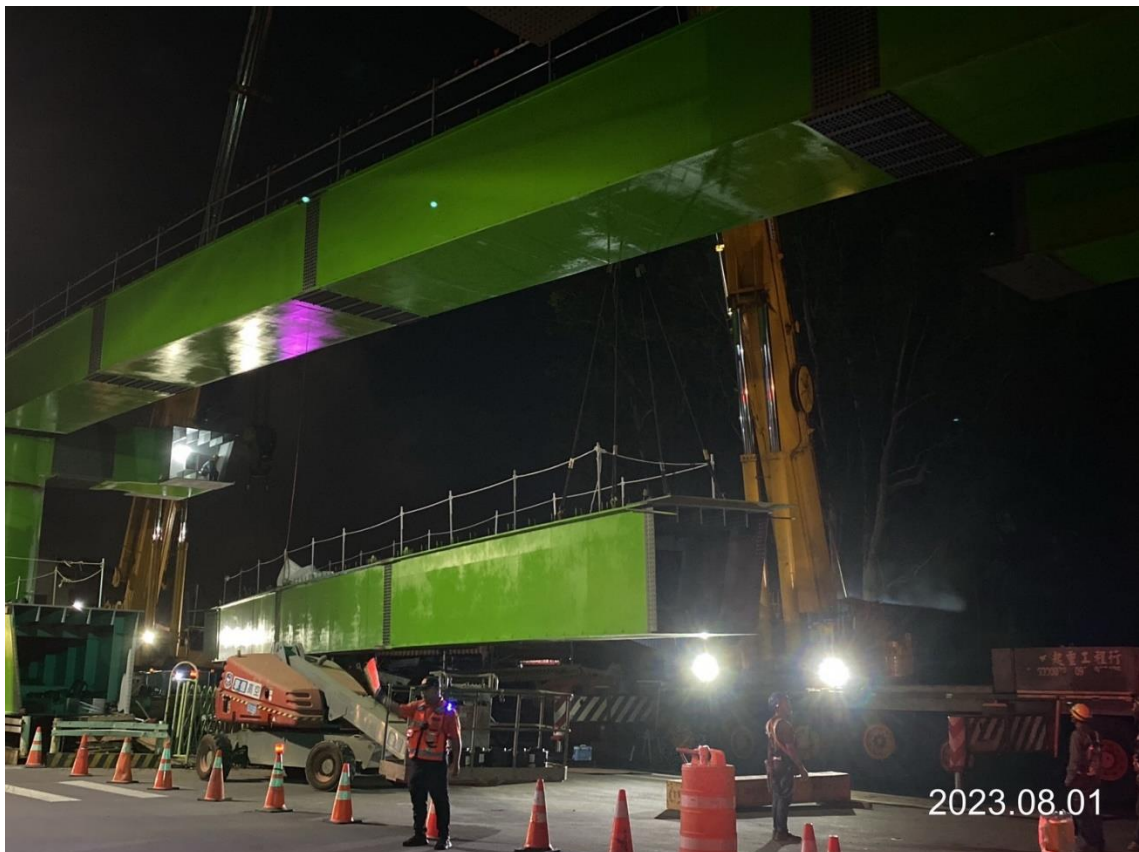
DU14-03 鋼箱梁吊裝 C05~C07 起吊
