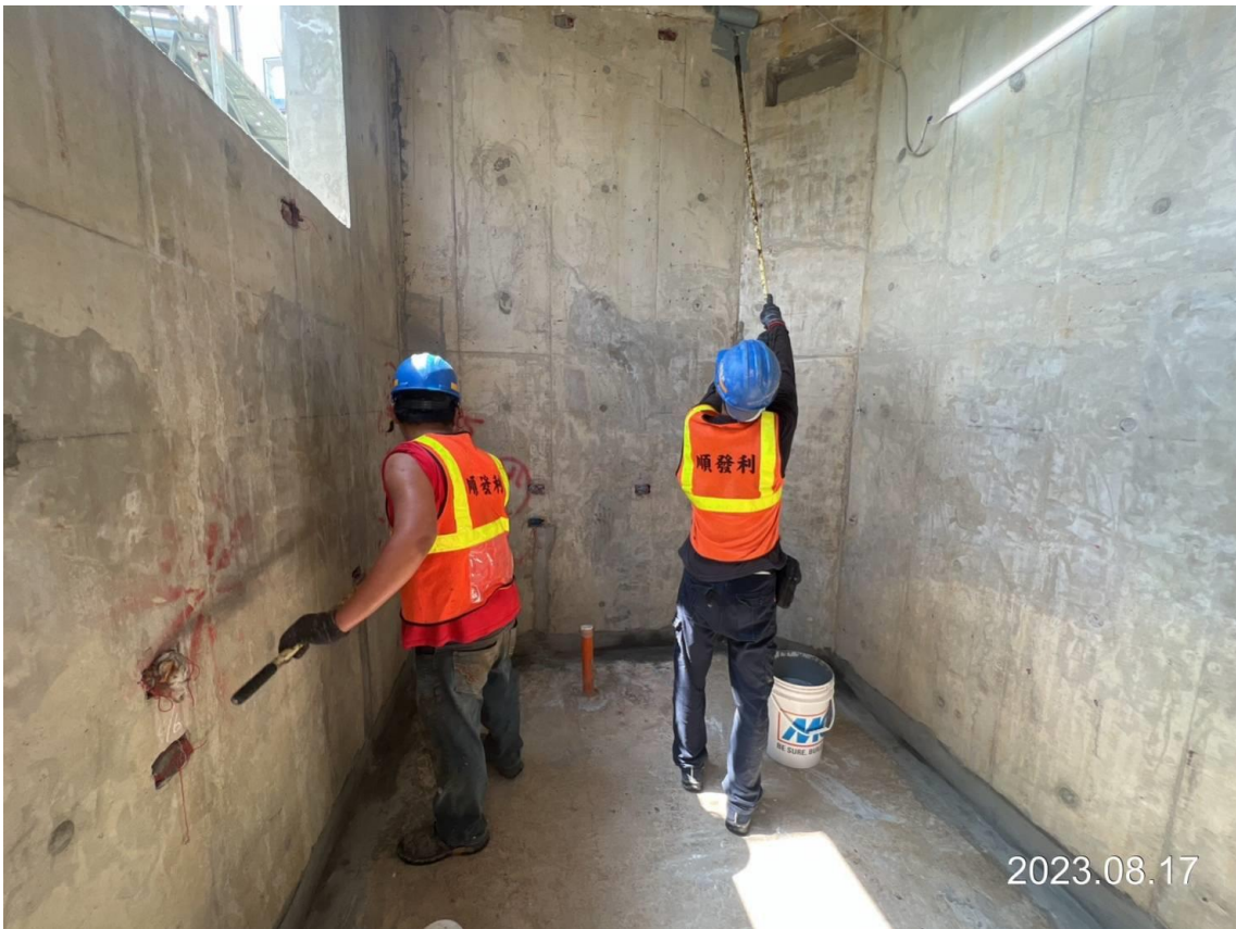
G02 車站出入口三樓廁所防水施作
