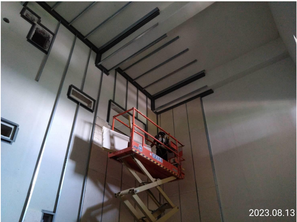
G13a 車站出入口二樓機房吸音牆板施作
