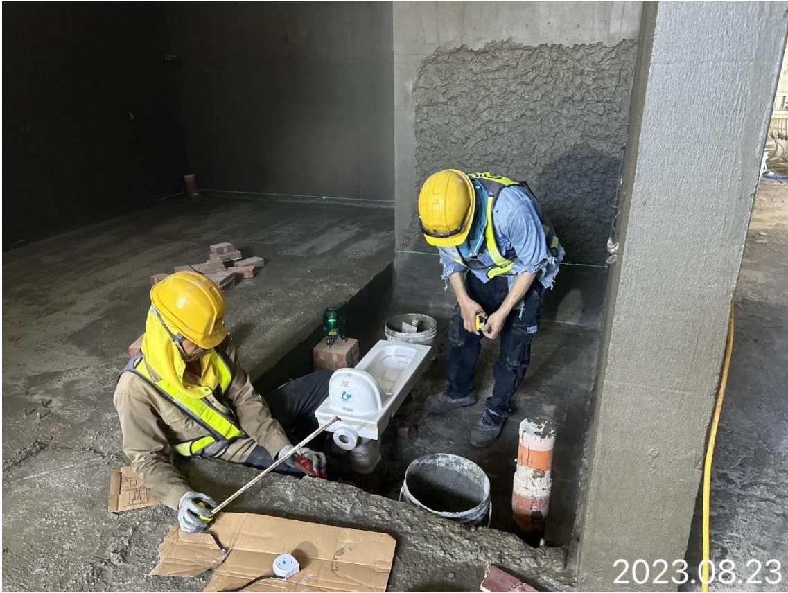
G01 站 1 樓女廁蹲便裝設
