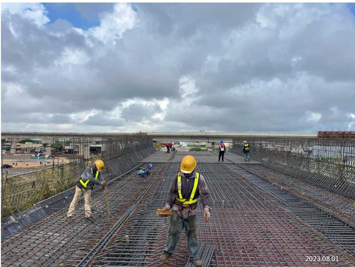
DU14a-01(PD-10~PD-9)第二階段頂版鋼筋綁紮
