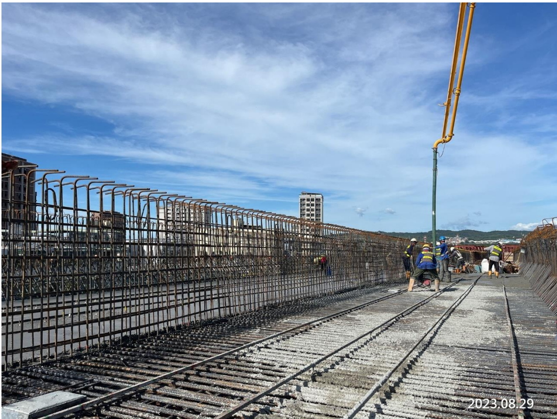
PD-9~PD-8 第三階段頂版混凝土澆置
