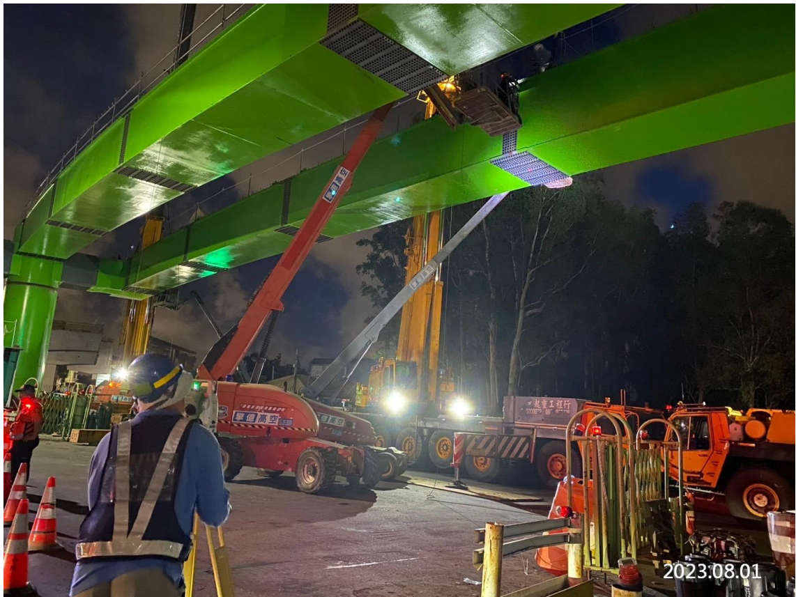
DU14-03 鋼箱梁吊裝接合穿鎖
