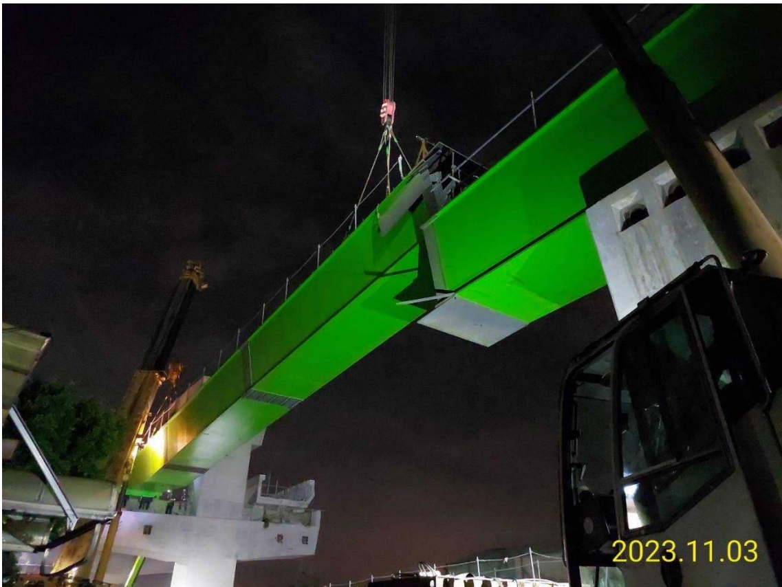
DU14-04(A09~A11)鋼箱梁吊裝
