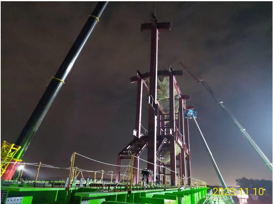
G14 車站站體鋼結構吊裝
