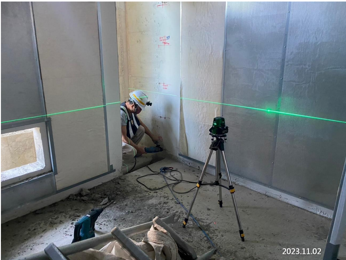
G32 車站出入口二樓門框安裝
