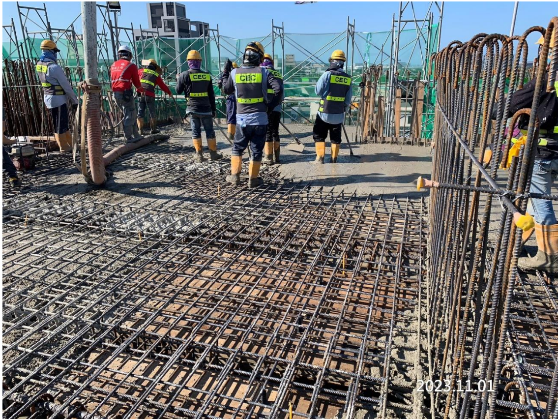
G31 車站出入口 2 樓柱牆第二昇層及 3 樓梁版混凝土澆置
