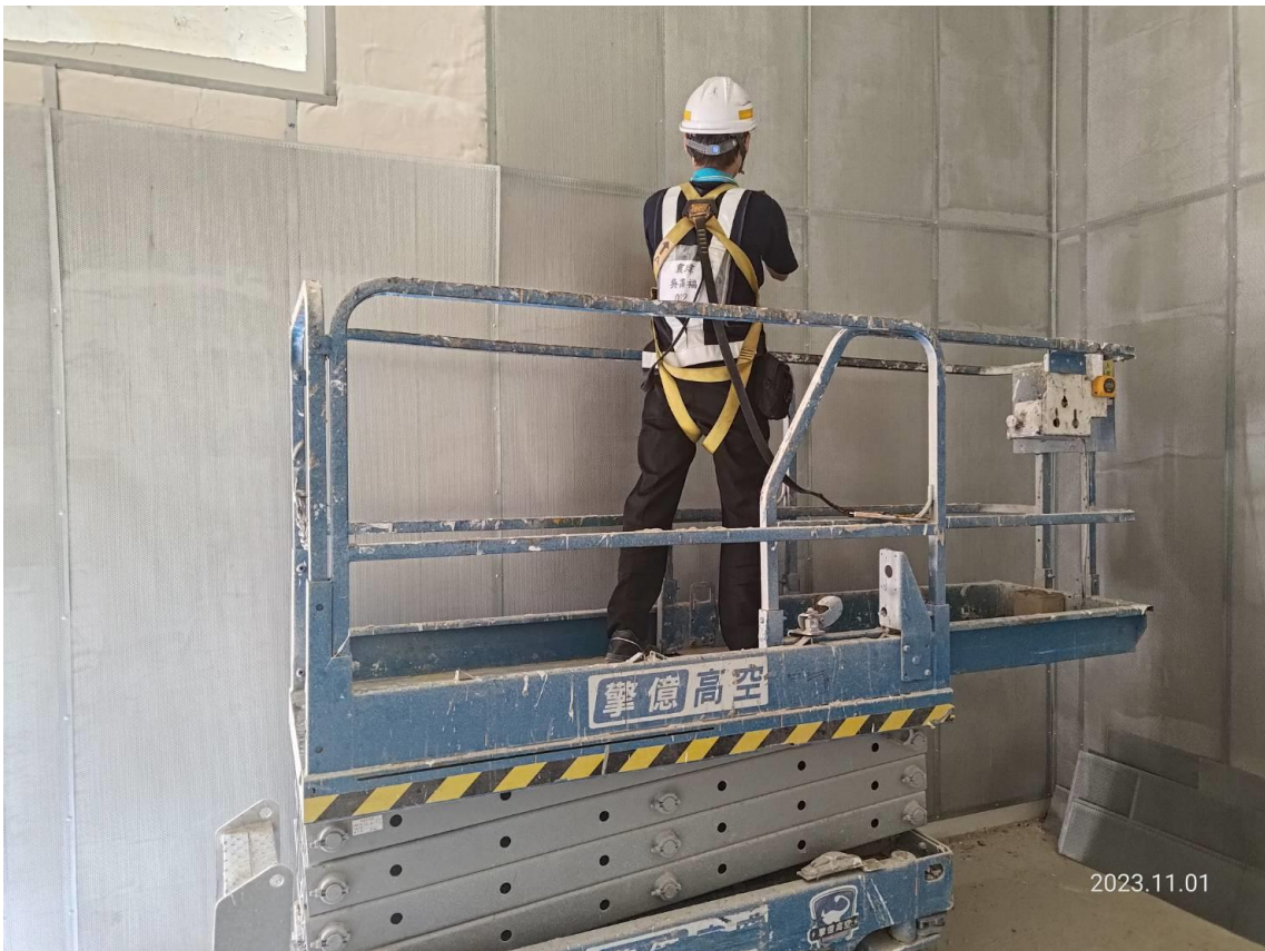
G32 車站出入口三樓通風機房吸音牆板施作
