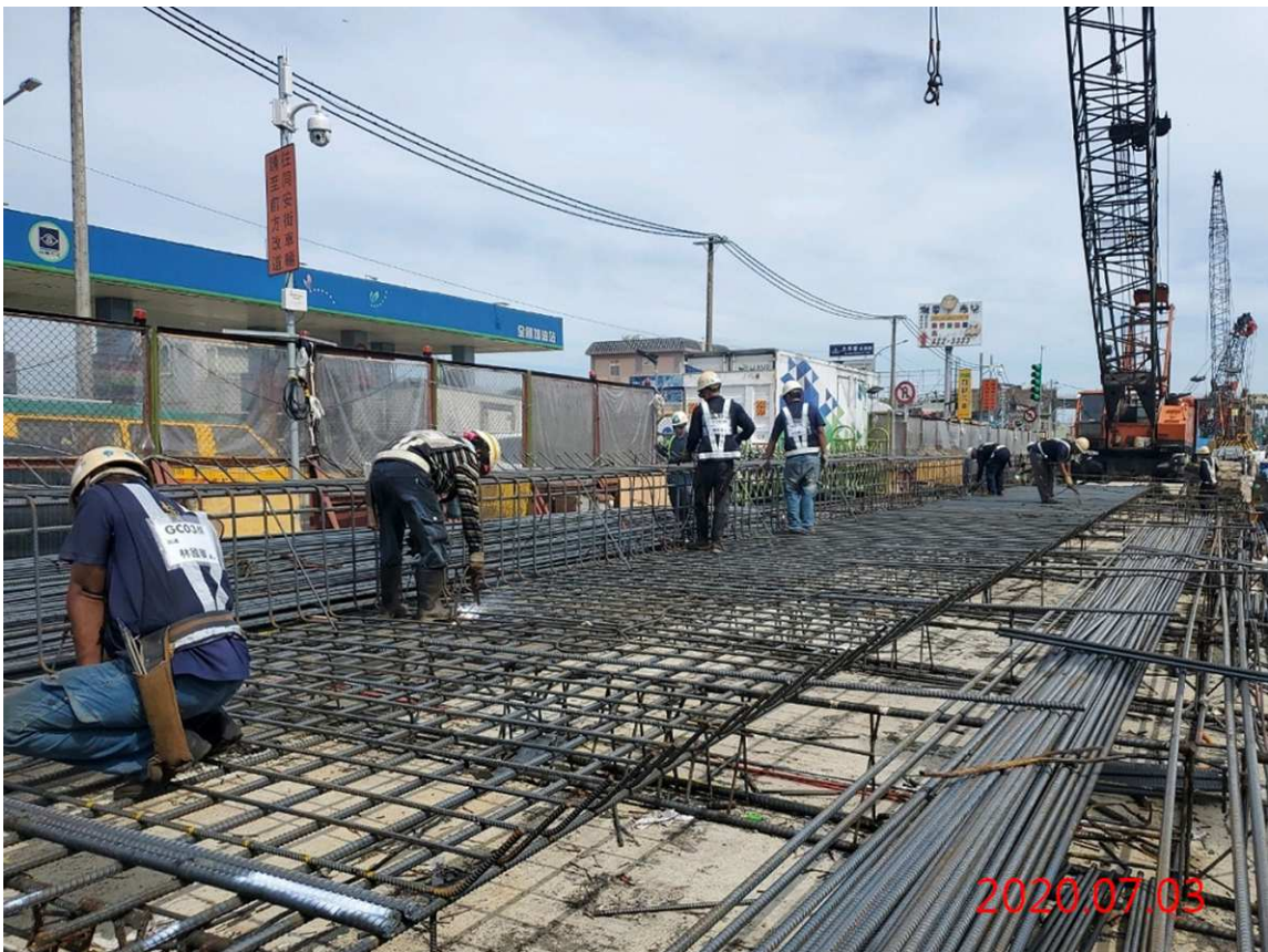
G12 站_連續壁鋼筋籠組立
