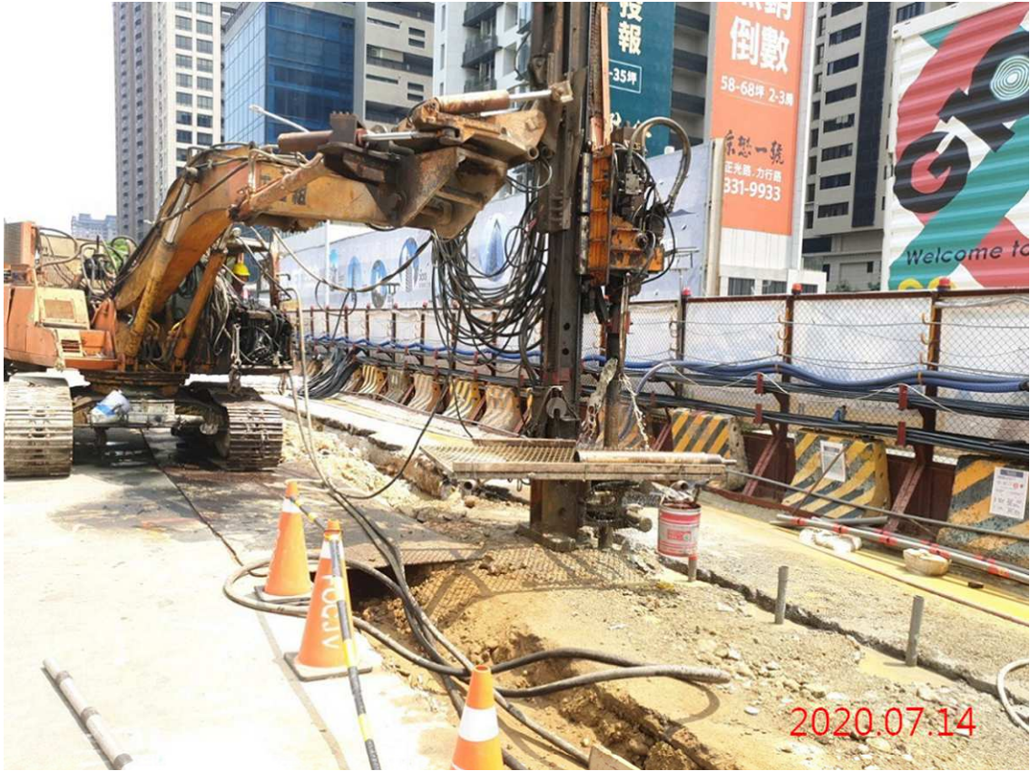
G10 站_槽溝保護鑽孔
