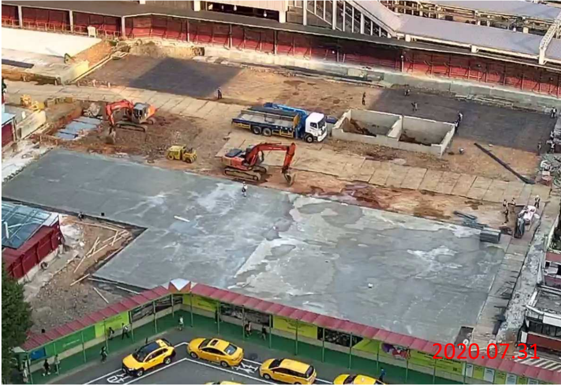
G07 站_連續壁作業鋪面設置
