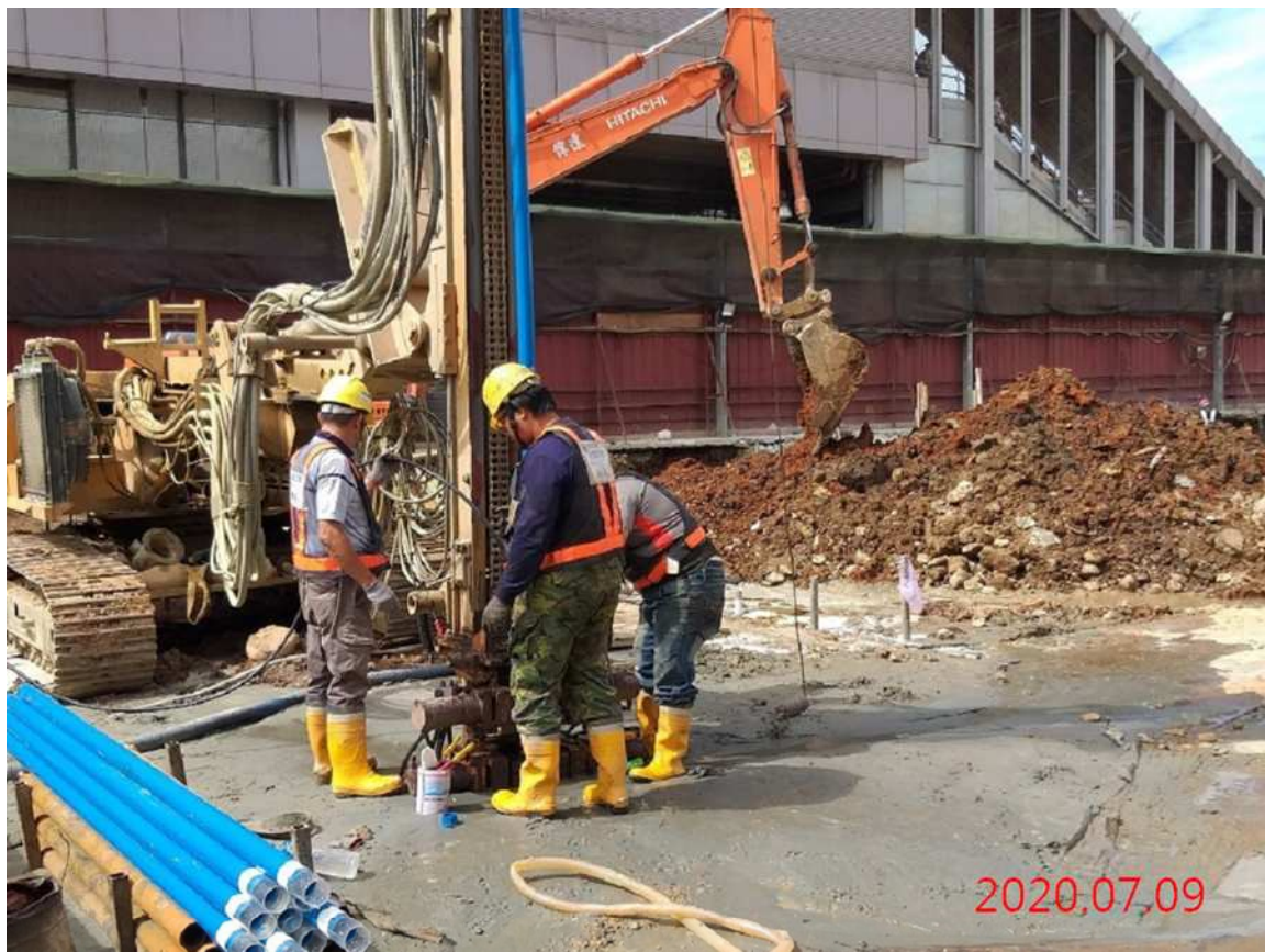
G07 站_槽溝保護鑽孔
