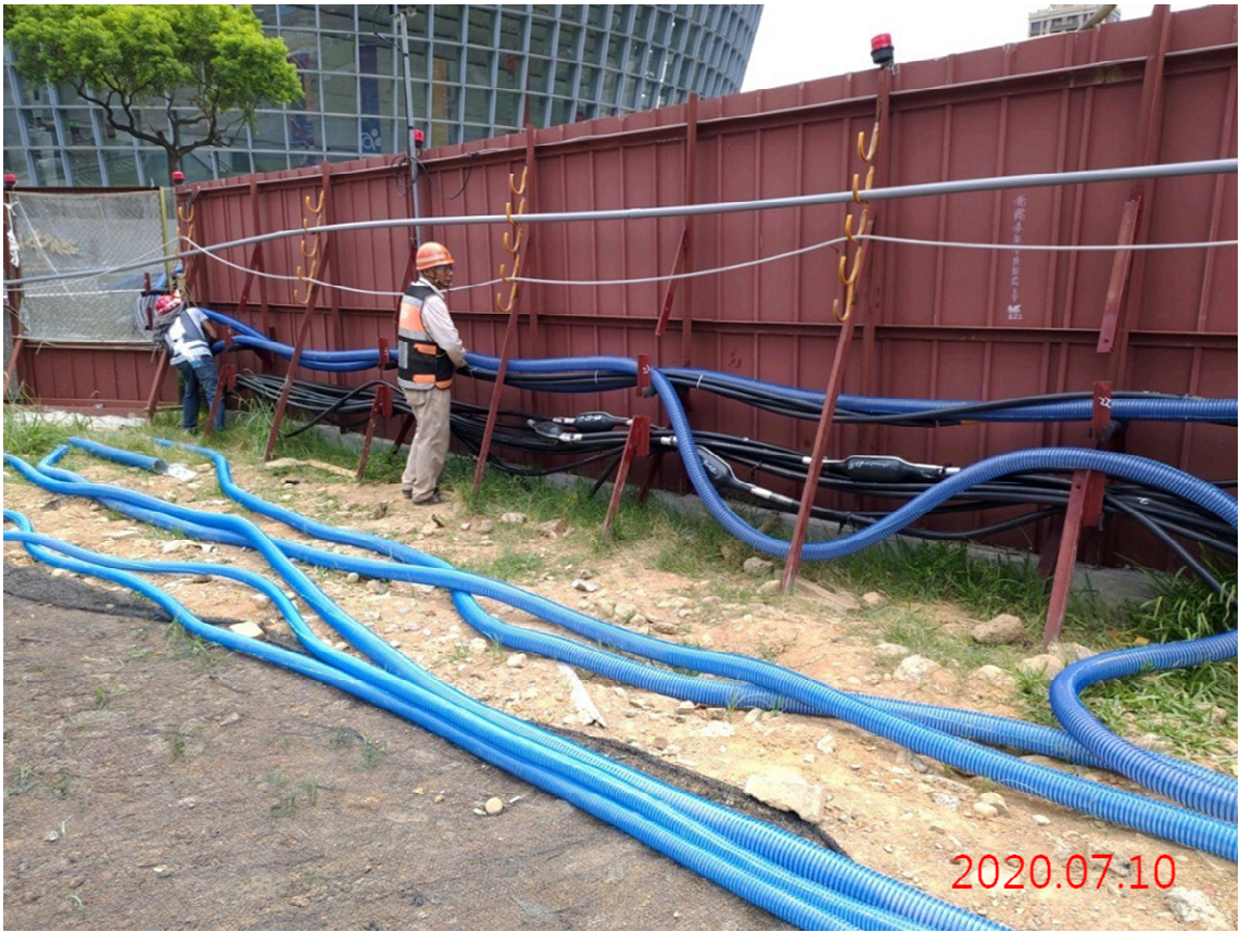
G11 站_管線吊掛圍籬保護
