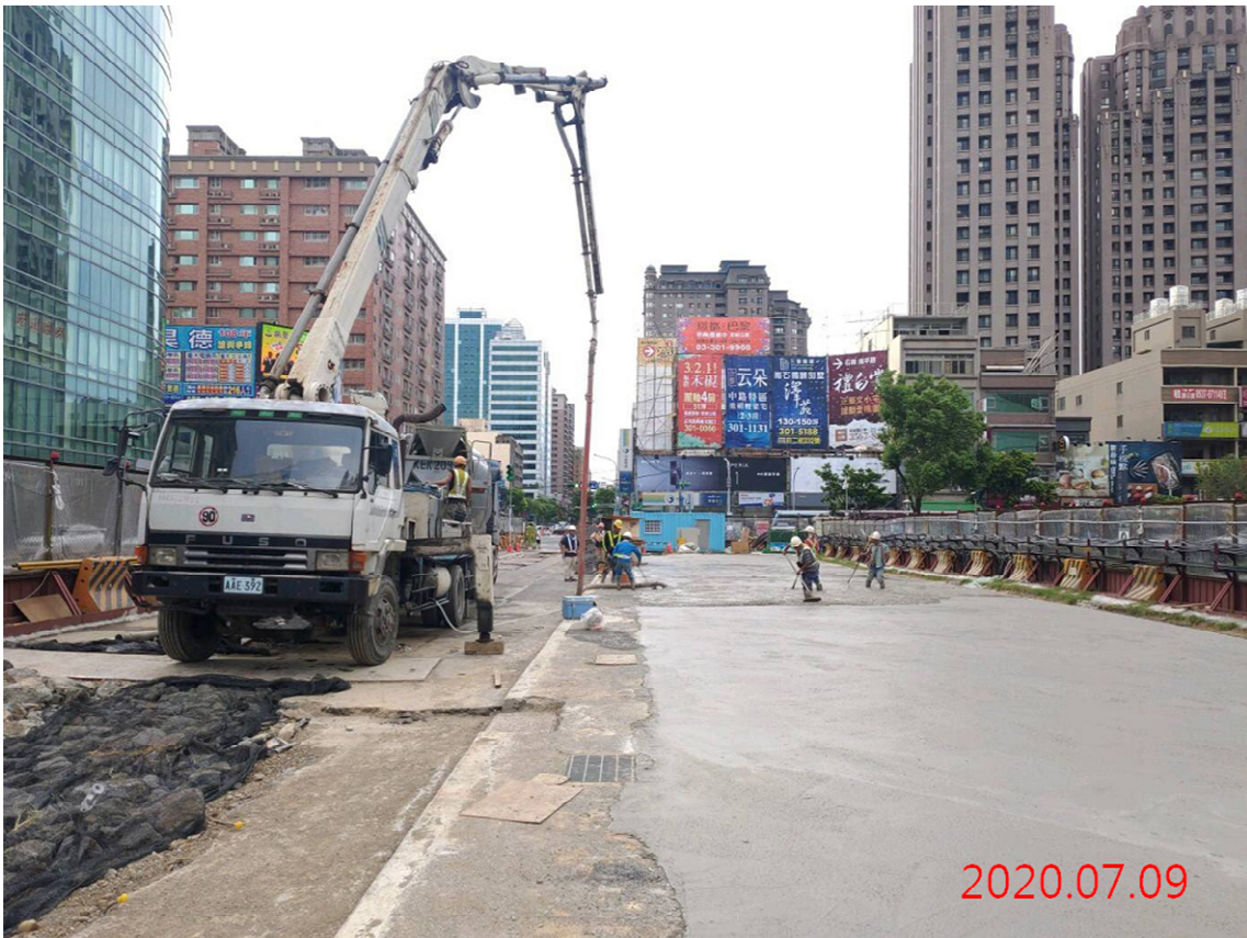
G11 站_連續壁作業鋪面設置
