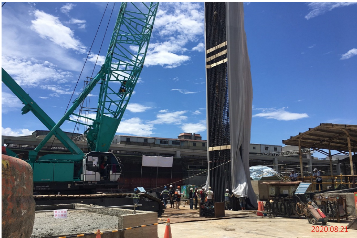
G07 站_連續壁鋼筋籠吊放
