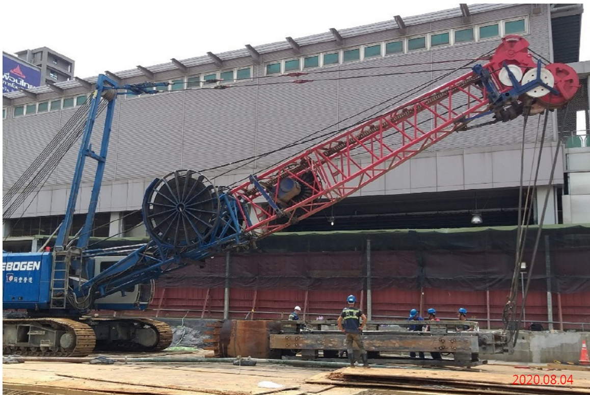
G07 站_連續壁挖掘機具組立
