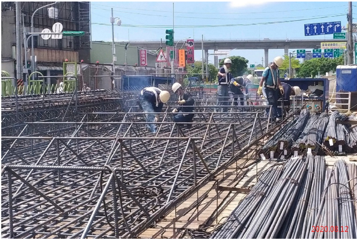
G12 站_連續壁單元鋼筋籠組立
