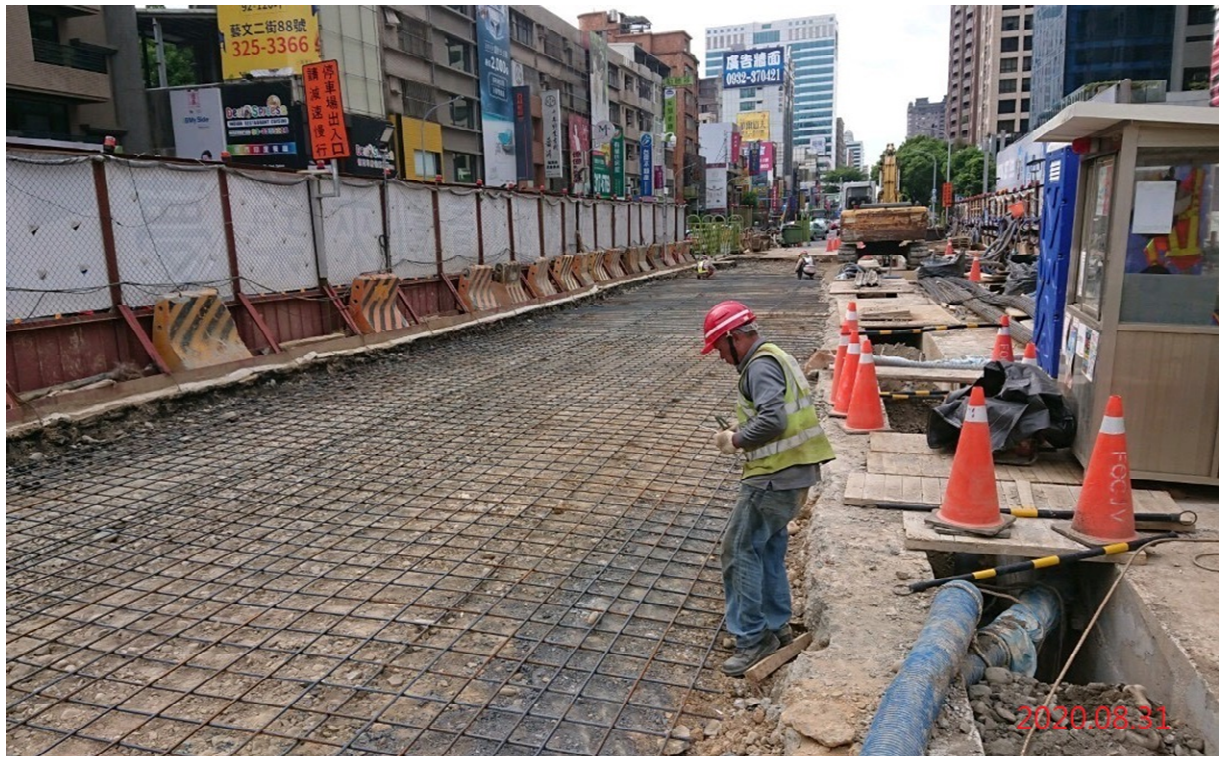
G10 站_北工區鋪面鋼筋鋪設
