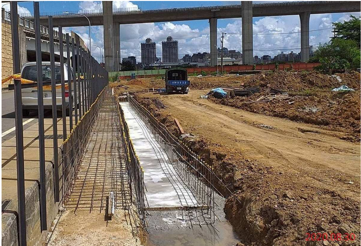
北出土段_工區圍籬架設及臨時灌溉排水工程
