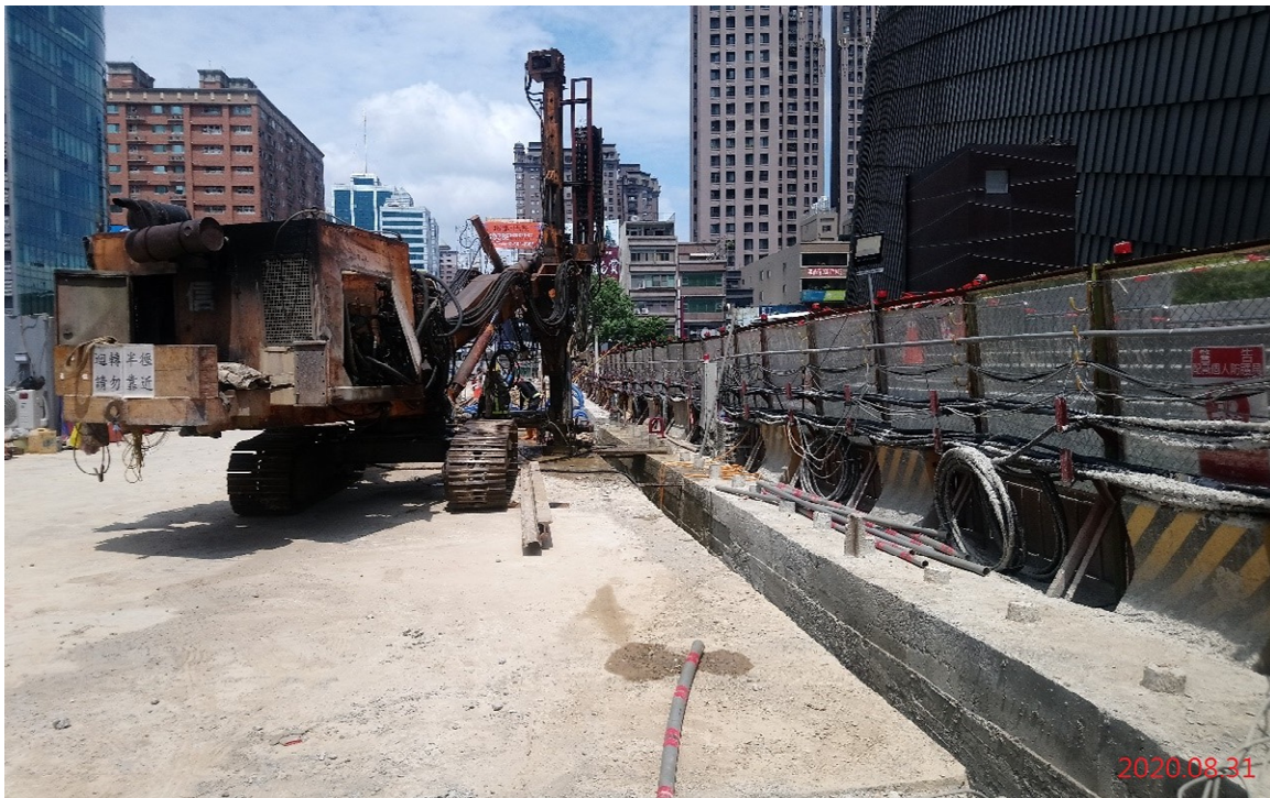
G11 站_連續壁地盤改良作業
