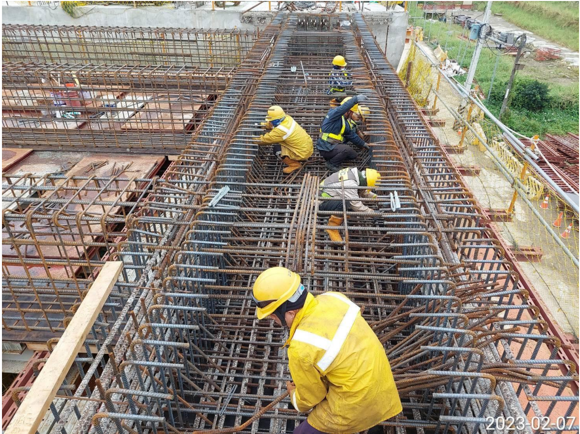
TG3~TG4 軌道梁鋼筋綁紮
