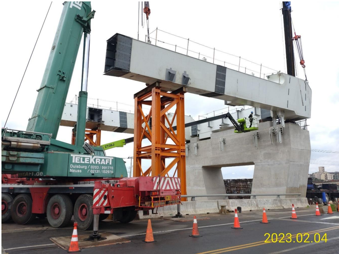
鋼構組_DU31-08(AB01~02)箱梁吊裝作業
