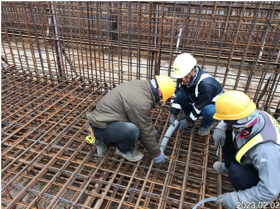
預鑄場_U13a13-01(DN)預埋管安裝
