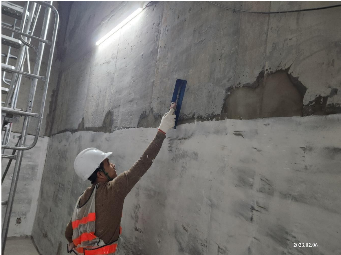
G13 車站出入口二樓油漆批土作業
