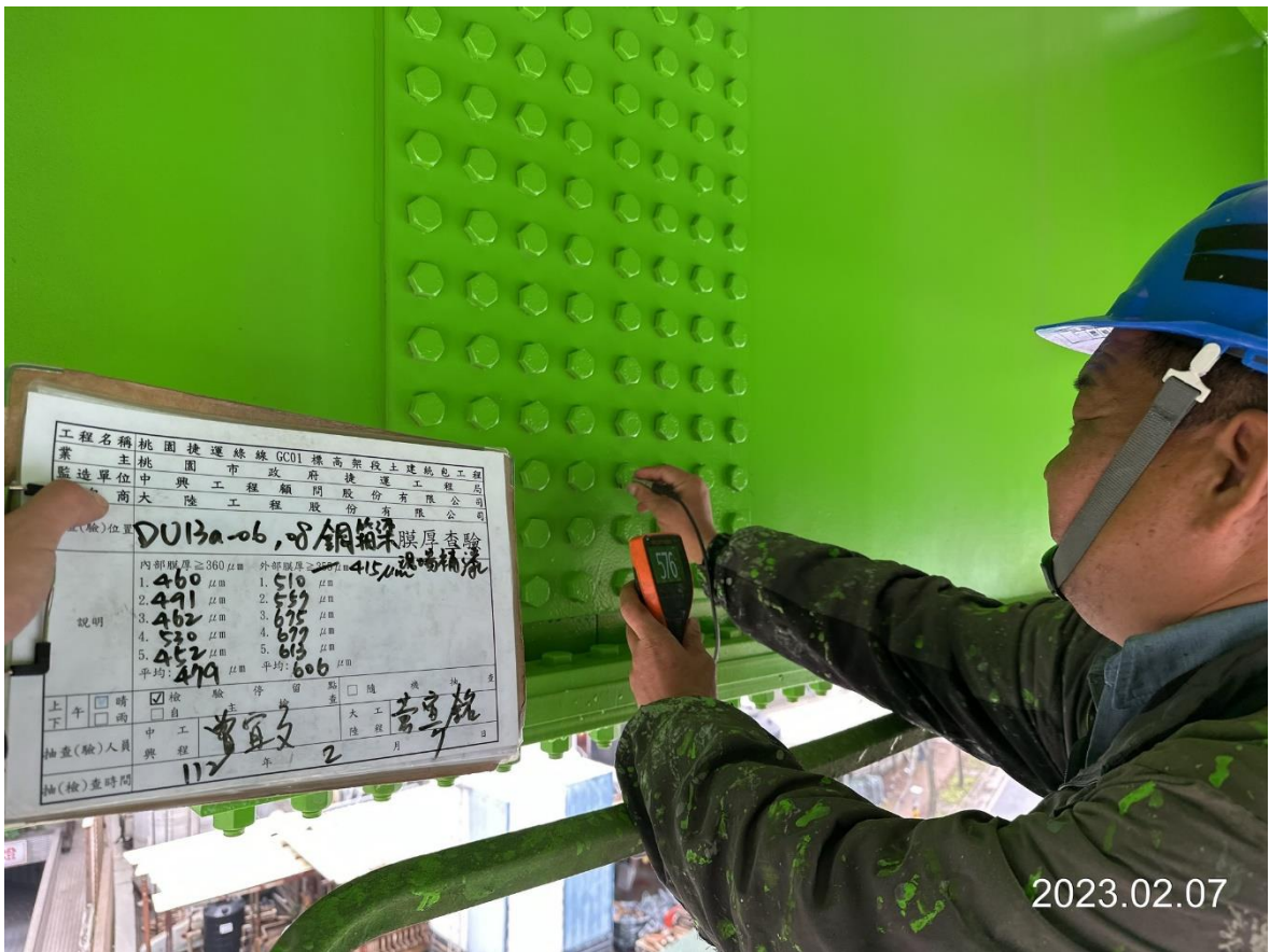
DU13a-06, DU13a-08 鋼橋現場補漆查驗
