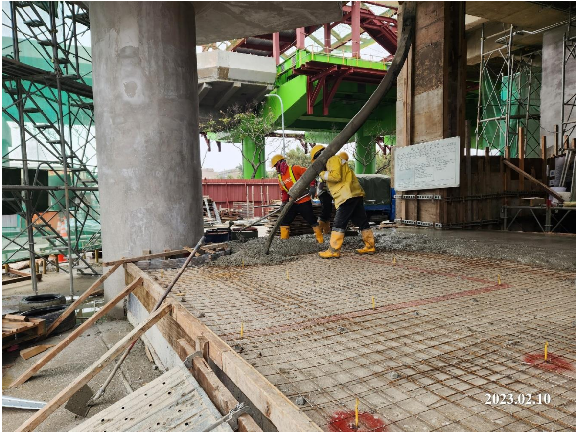
G13 車站出入口一樓墊層混凝土澆置
