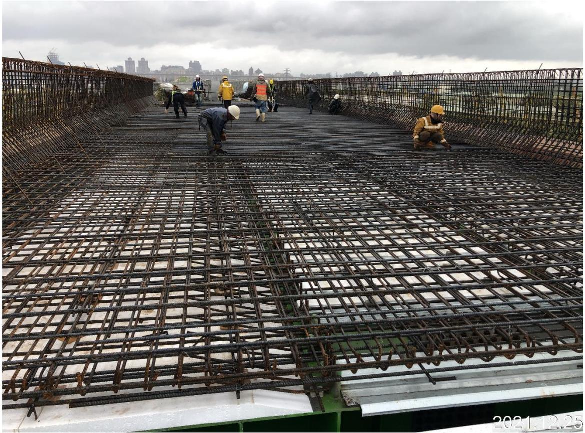
蘆竹中正北路 場撐箱型梁鋼筋綁紮
