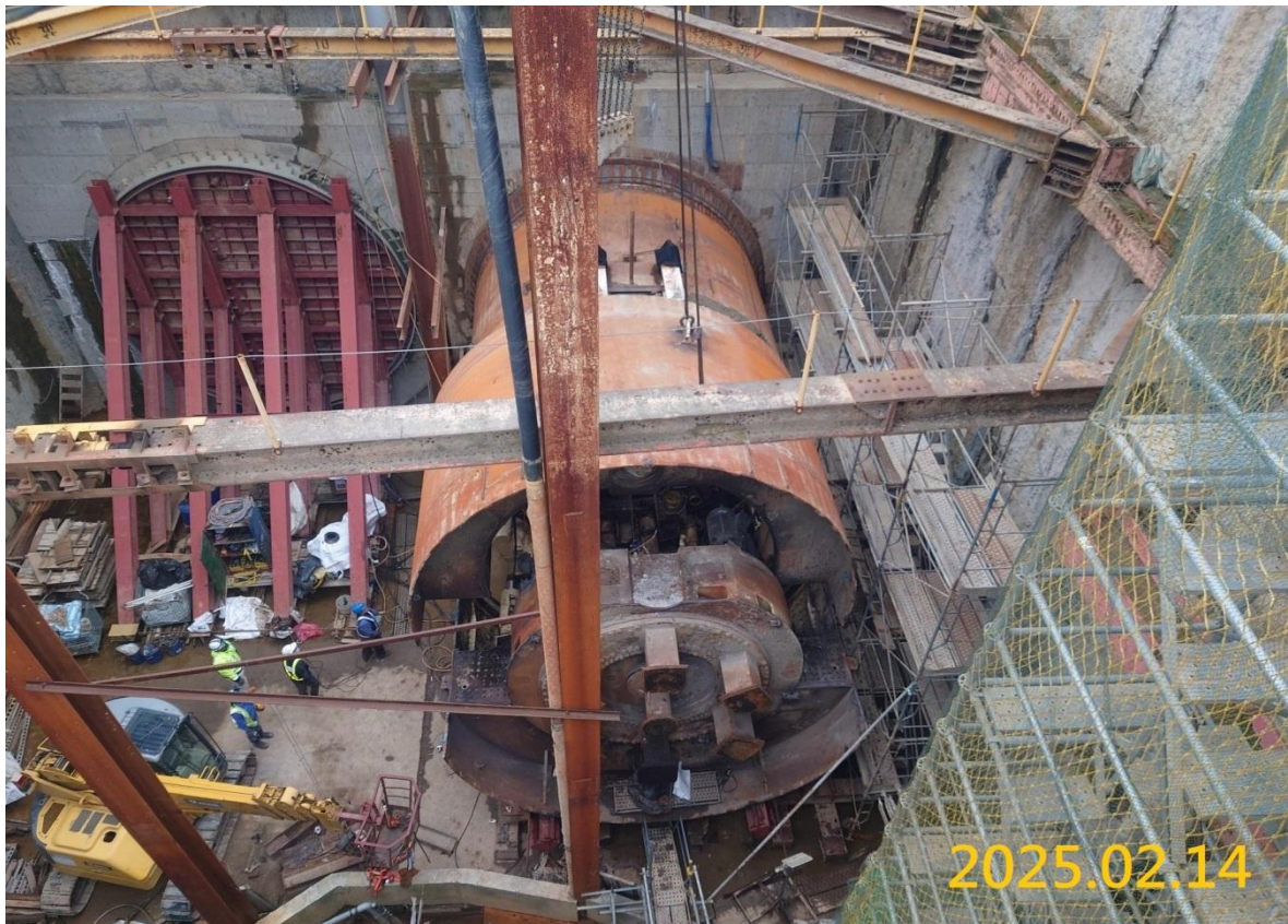
南出土段潛盾隧道到達端潛盾機拆機
