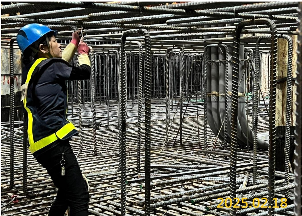
G05 站結構底版施作
