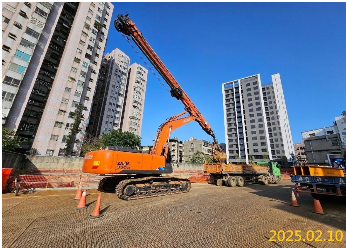
G04 出入口 A 土方開挖
