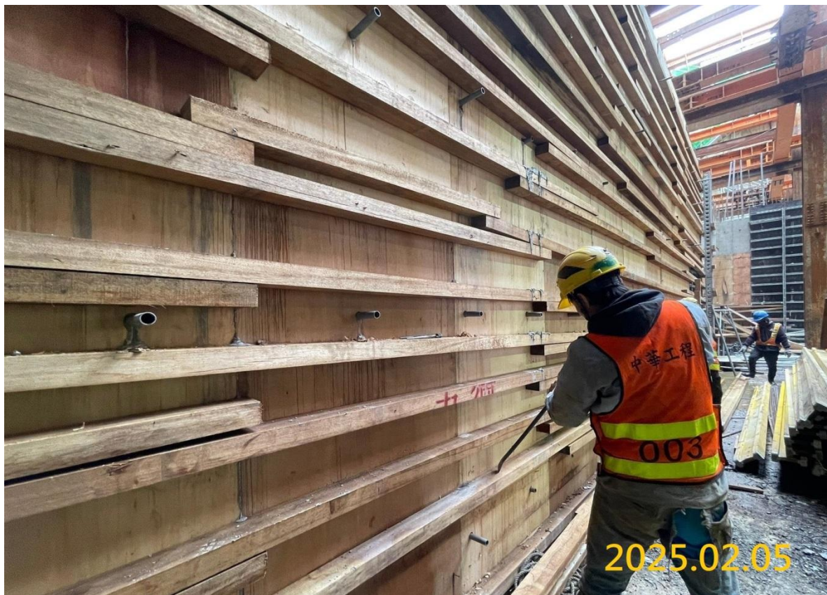
G03 出入口 B3F 結構隔間牆施作
