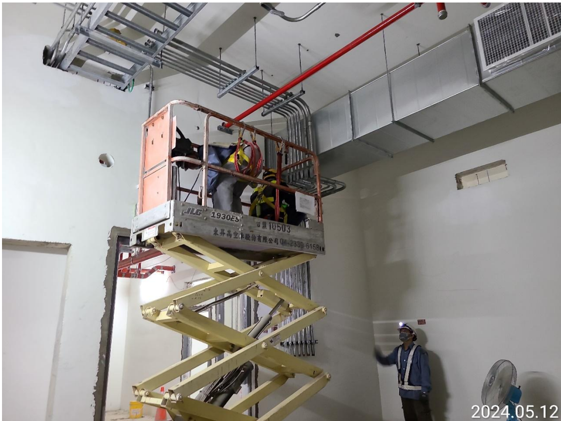
G32 站電氣管路施作
