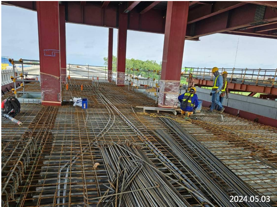
G14 車站站體月台層鋼筋加工綁紮
