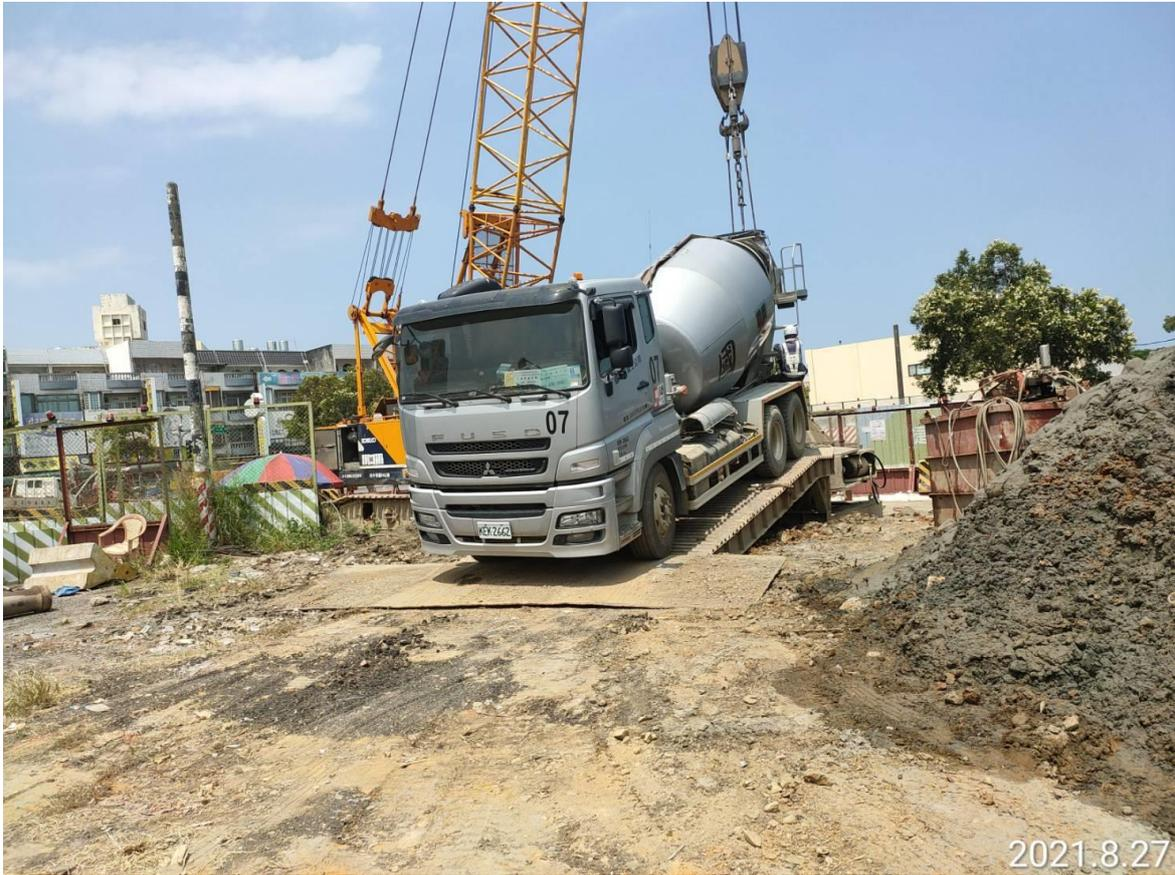
大園坑菓路 基樁混凝土澆置
