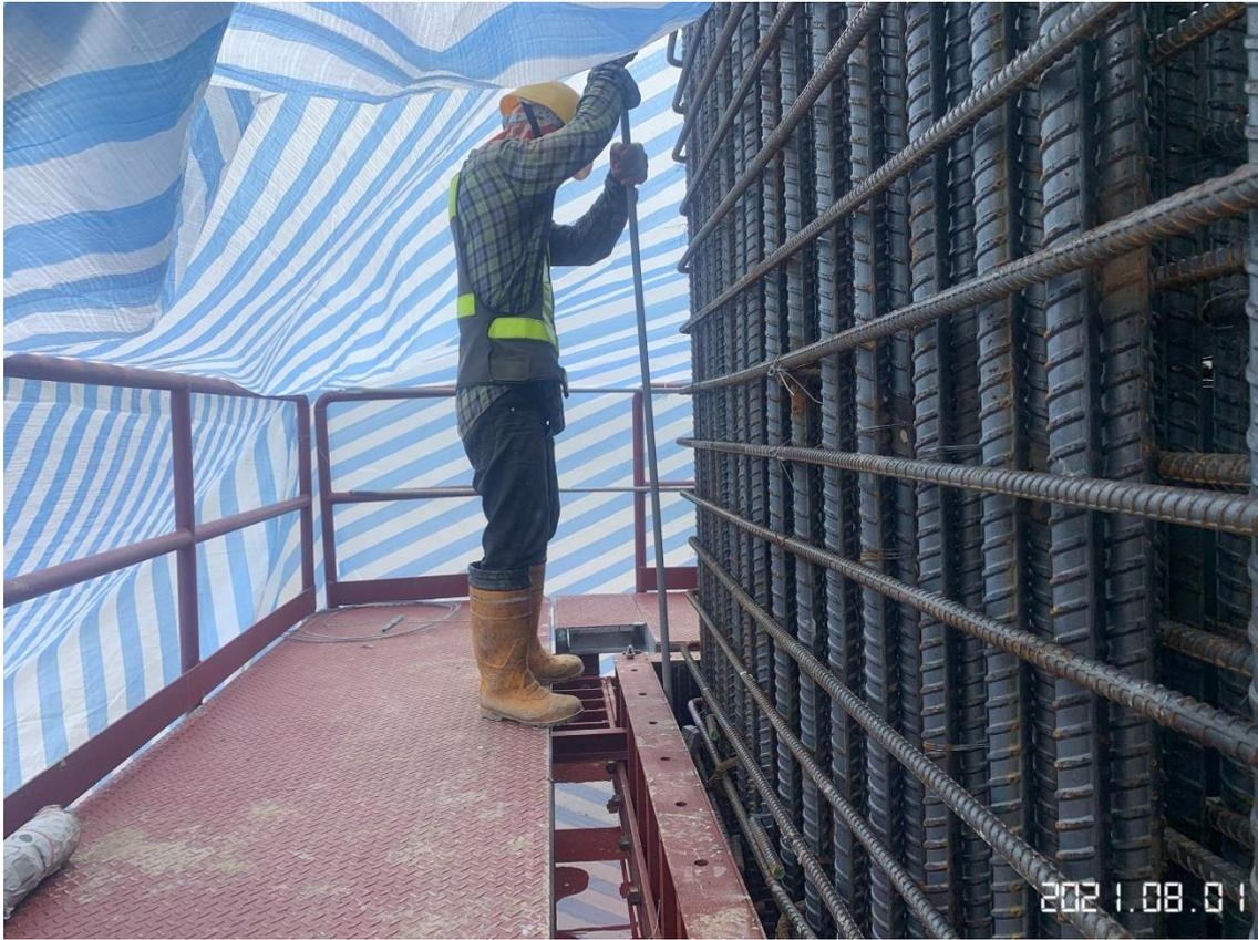
蘆竹中正北路 墩柱混凝土澆置搗實
