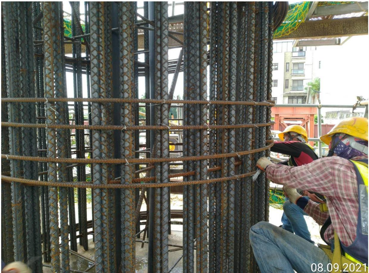
八德新闢道路 墩柱鋼筋綁紮
