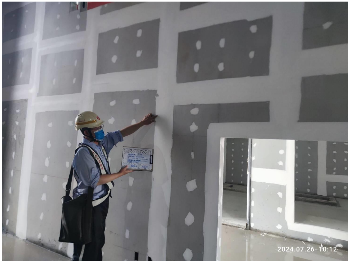
G14 車站站體穿堂層填縫處理查驗
