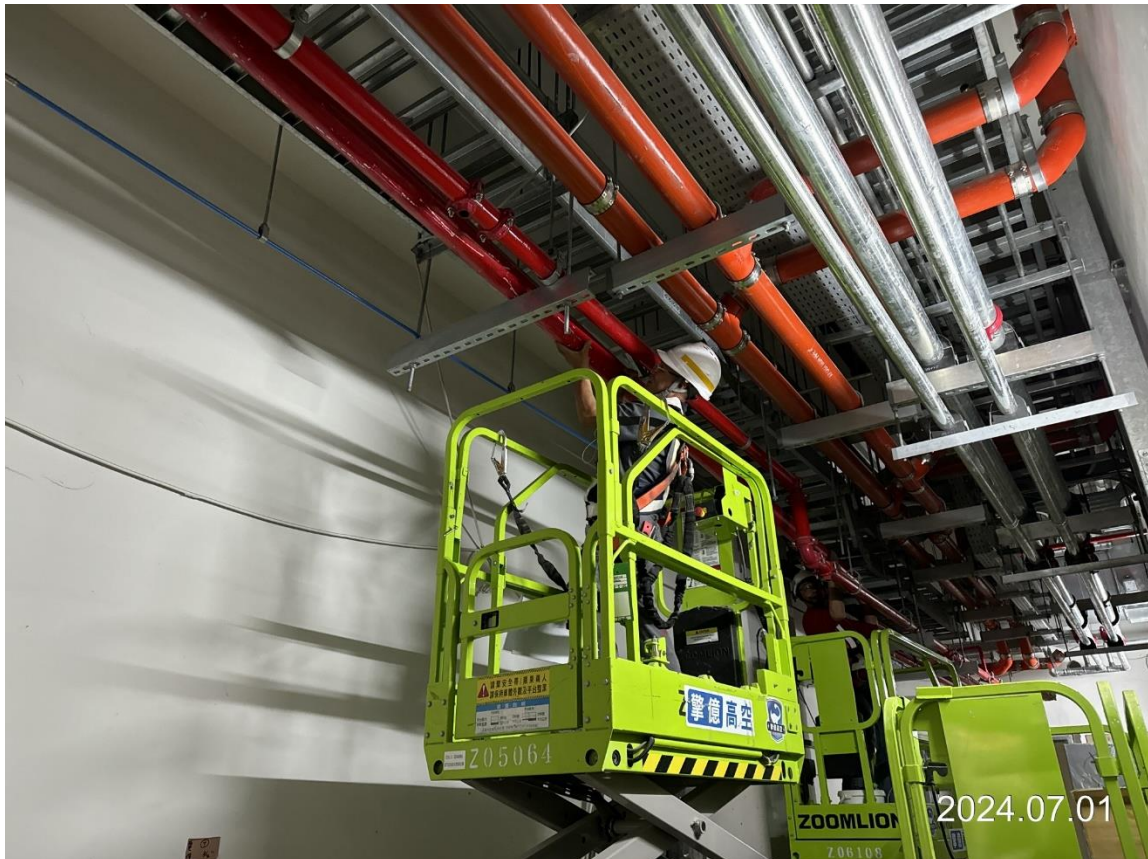
G32 站 3F 消防管路施作
