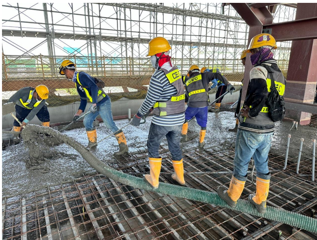
G14 車站站體月台層混凝土澆置
