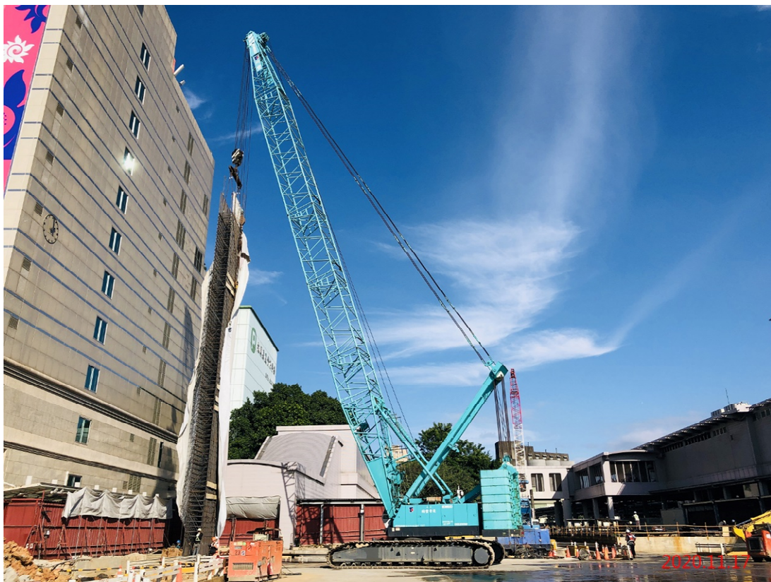
G07 站_連續壁單元鋼筋籠吊放
