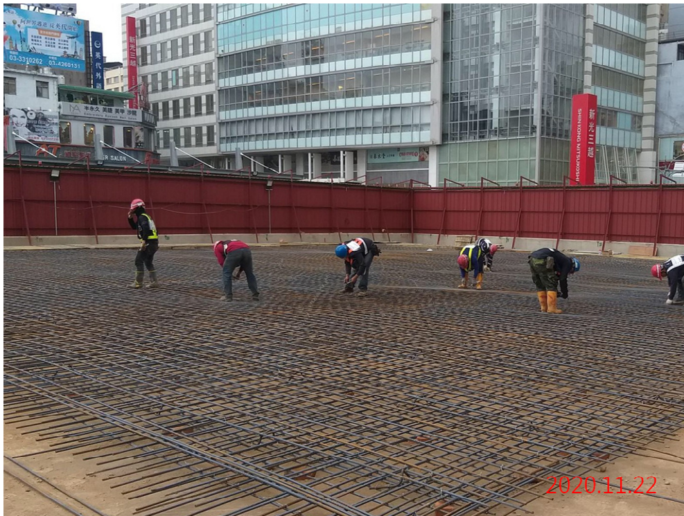
G07 站_第 2 階段連續壁工作平台鋪面鋼筋綁紮
