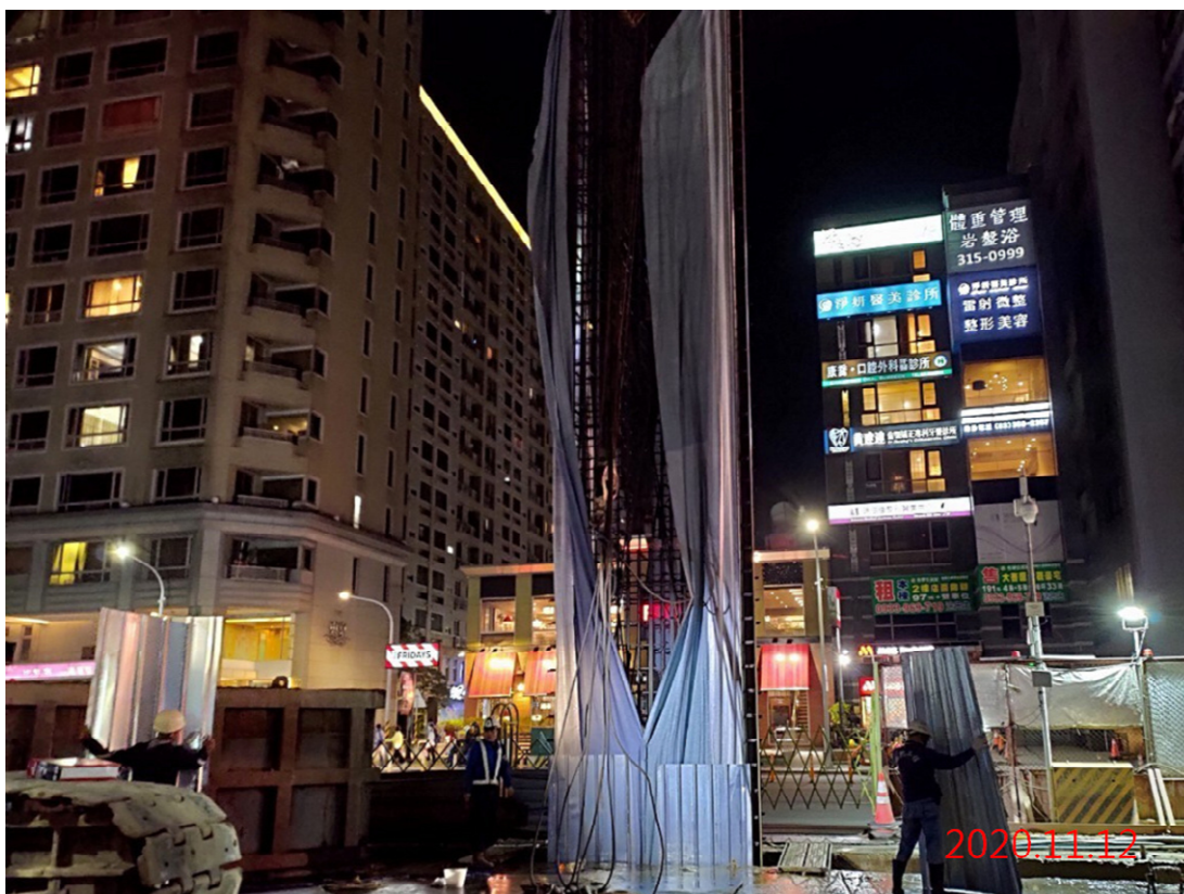
G11 站_連續壁單元鋼筋籠吊放
