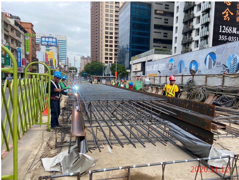
G10 站_D041 單元鋼筋籠組立
