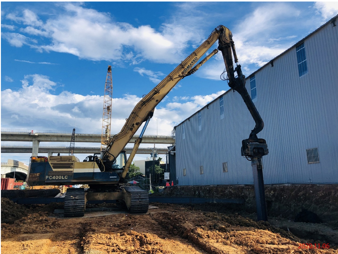
北出土段_H 型鋼檔土支撐排樁施作
