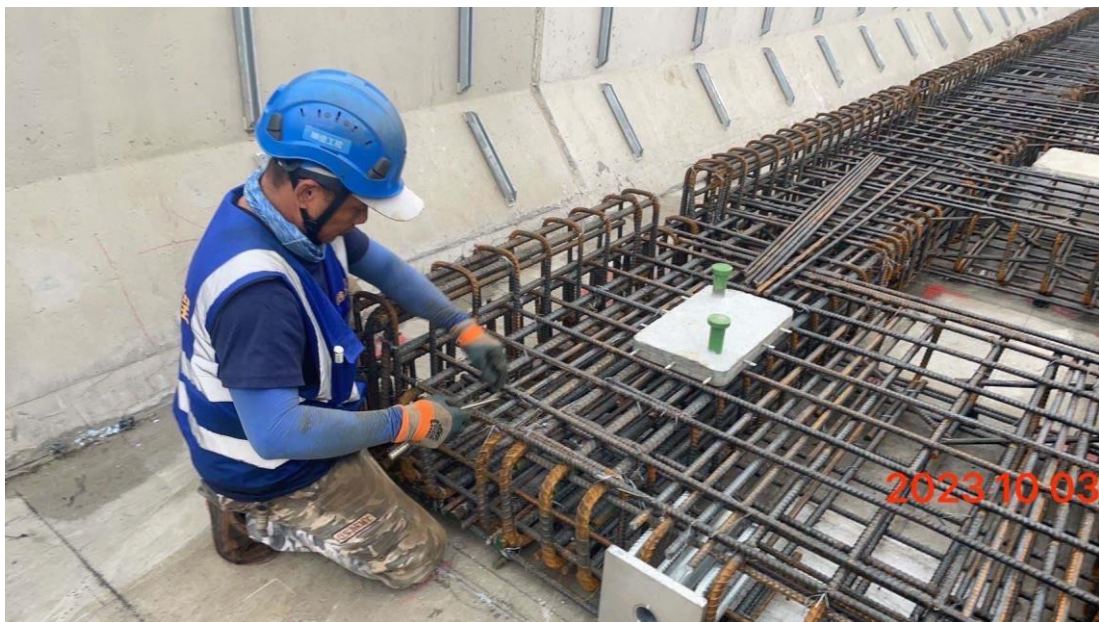
G13a~G14 道床鋼筋綁紮加工作業(G13a-G14-FU1~FU4)
