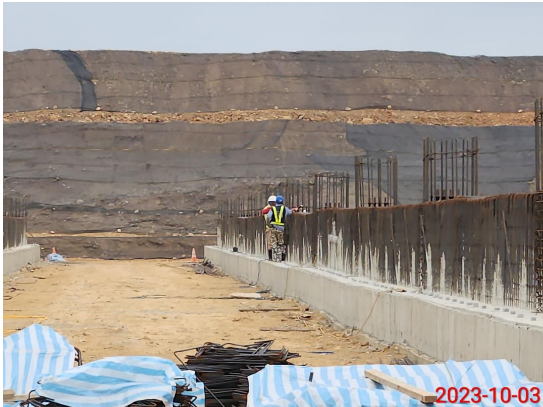
北機廠-駐車廠 G line 基礎版模版組立、I line 基礎預埋螺栓固定
