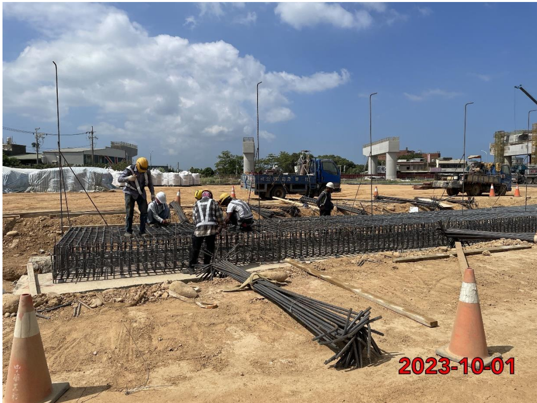
北機廠-擋土牆牆線 3(0K+220~0K+240)基礎鋼筋綁紮作業
