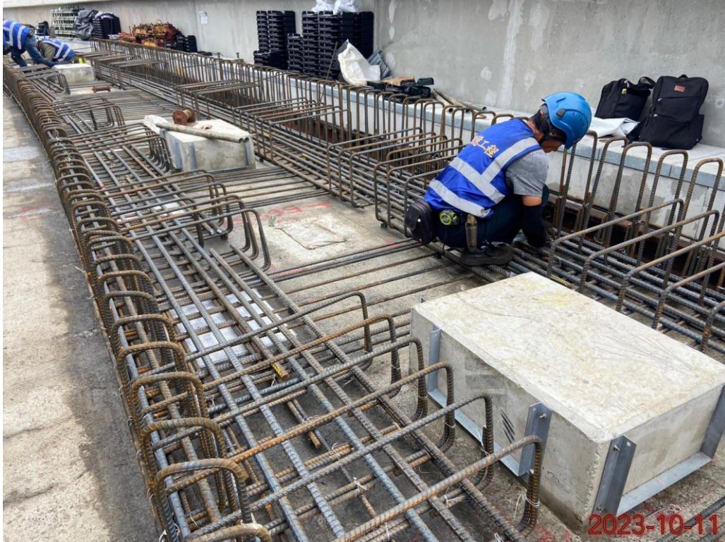
G13a~G14 道床鋼筋加工作業(G13a-G14-FU1~FU4)
