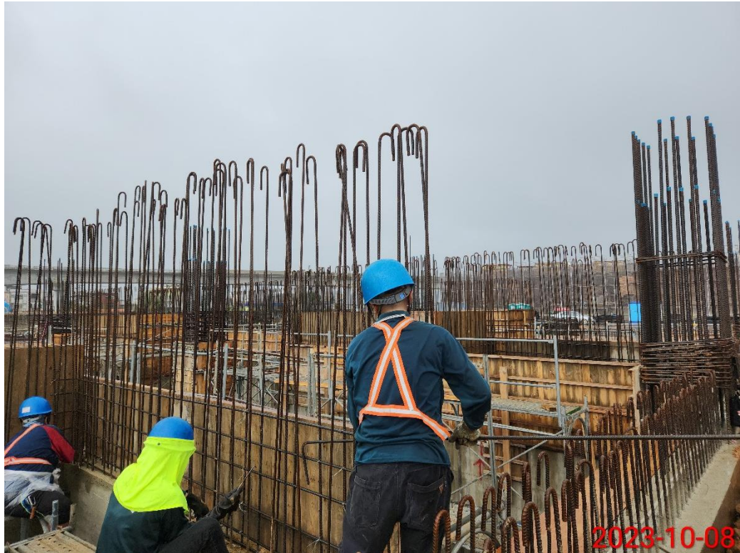
北機廠-管理中心 B1F 牆鋼筋綁紮與搬運
