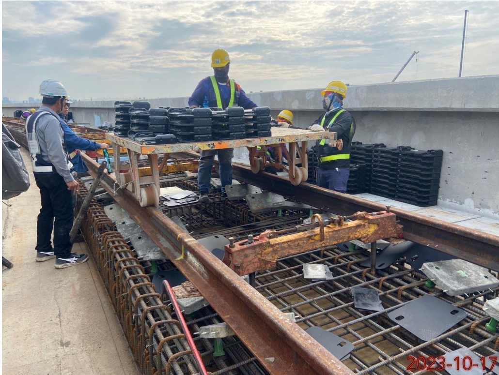
G13a~G14 預鑄基底及基板佈設安裝(G13a-G14-FU1~FU4)
