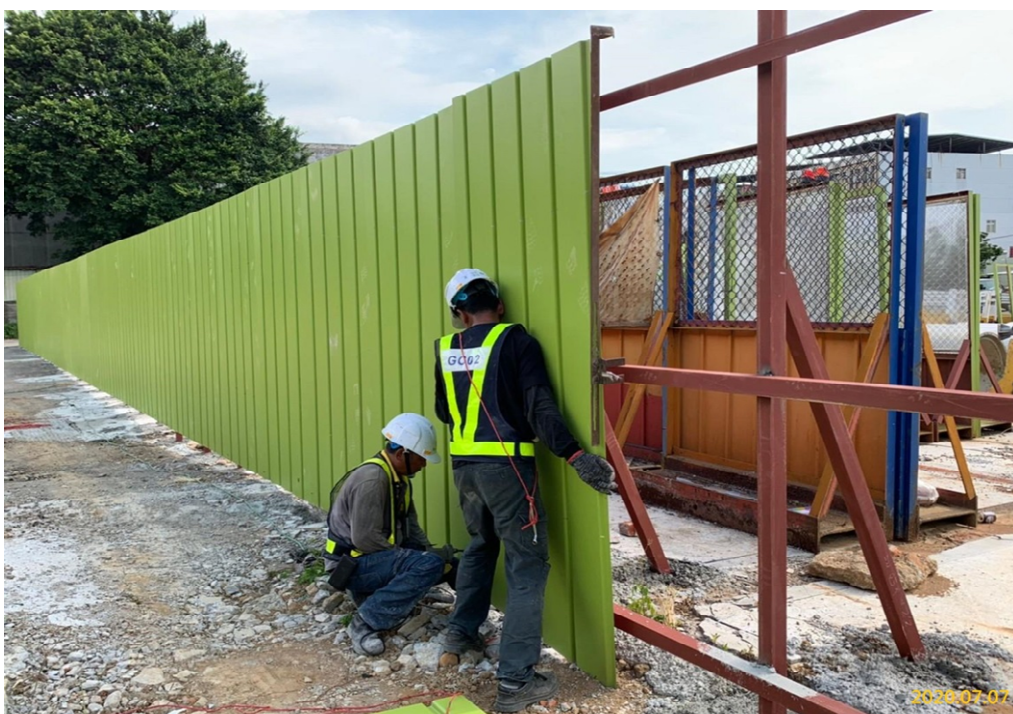
VS5 通風豎井(介壽路中華電信旁)施工圍籬施作
