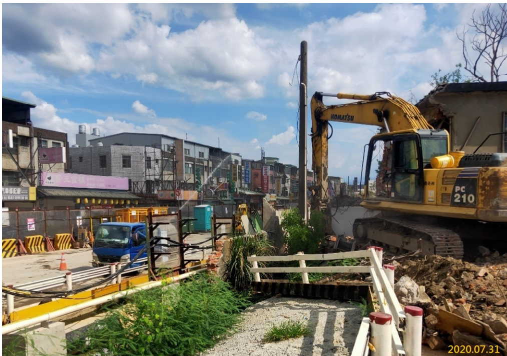
G03 站(巧克力街附近)既有建物拆除
