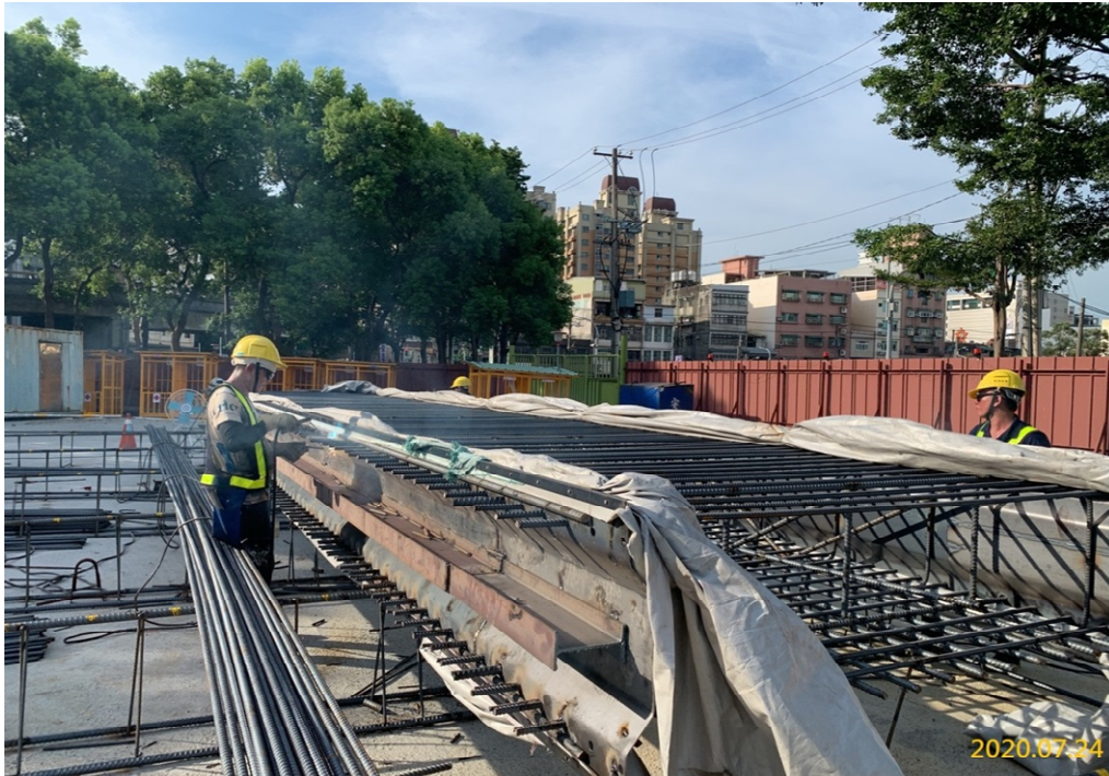
VS6 通風豎井(福豐公園)連續壁單元鋼筋籠組立
