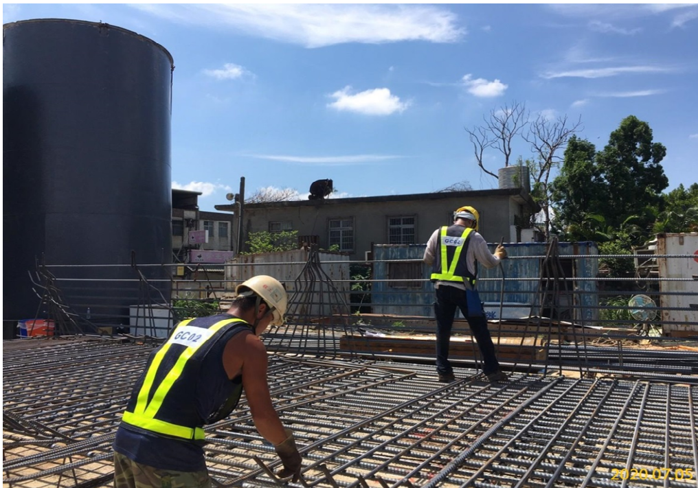
G03 站(巧克力街附近)連續壁單元鋼筋籠組立
