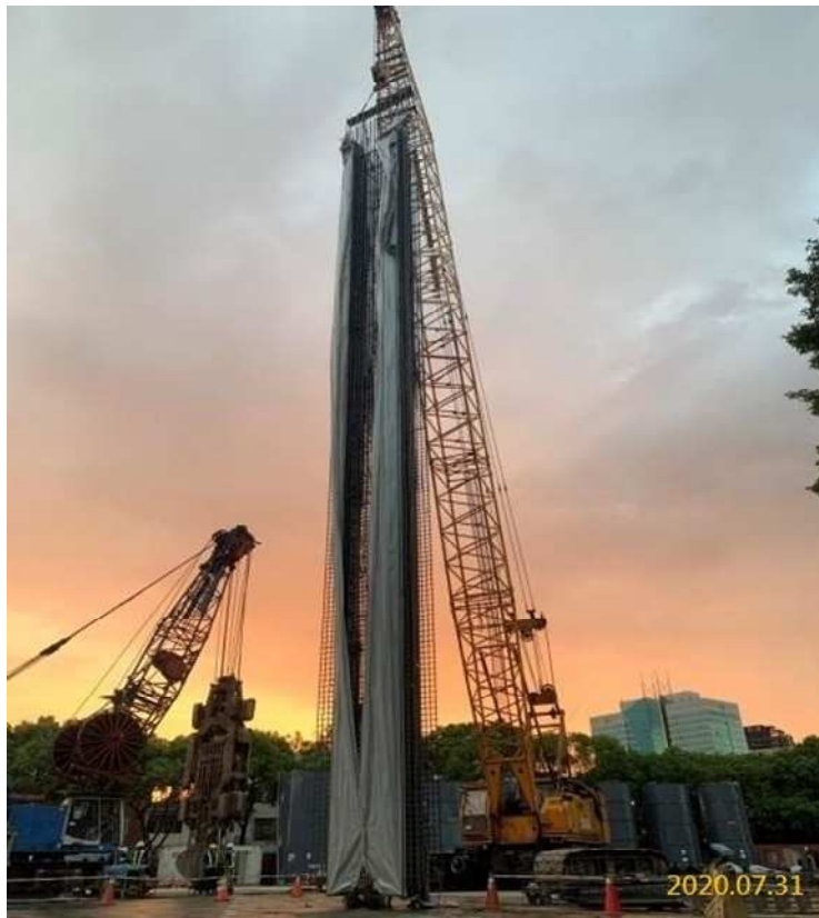
VS6 通風豎井(福豐公園)連續壁單元鋼筋籠吊放
