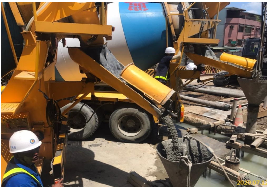
G03 站(巧克力街附近)連續壁單元混凝土澆置
