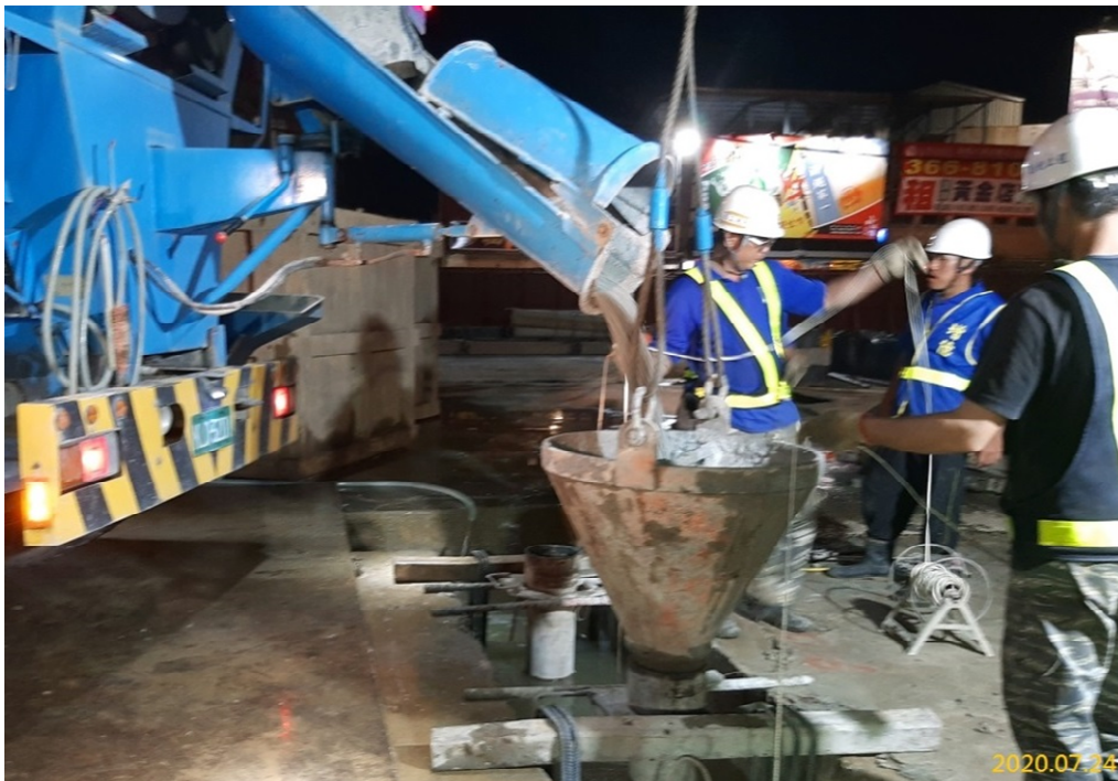
VS6 通風豎井(福豐公園)連續壁單元混凝土澆置
