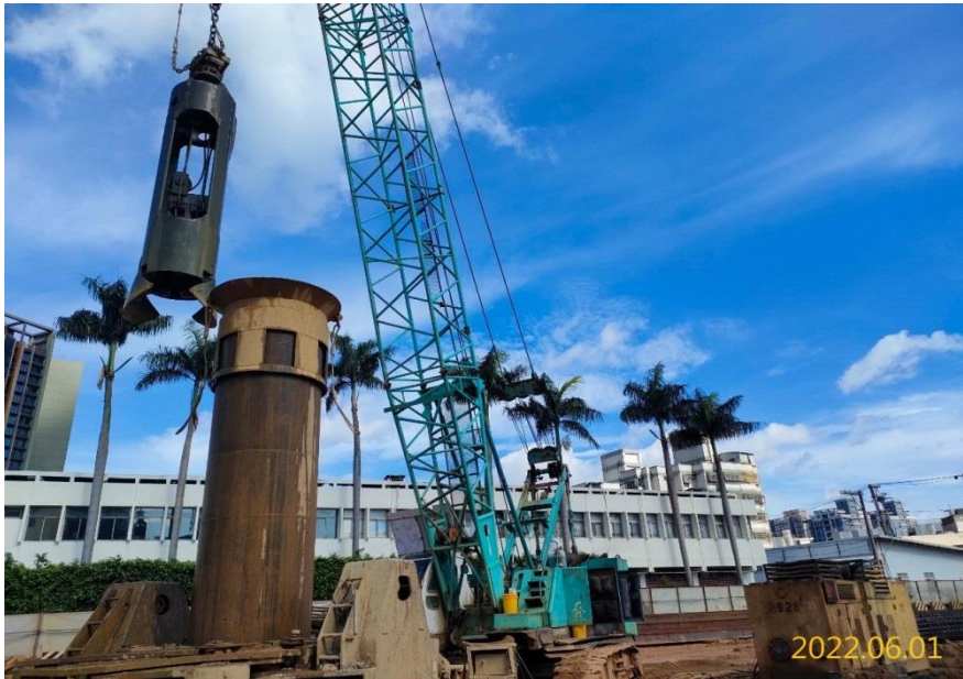
G05 站中間柱施作
