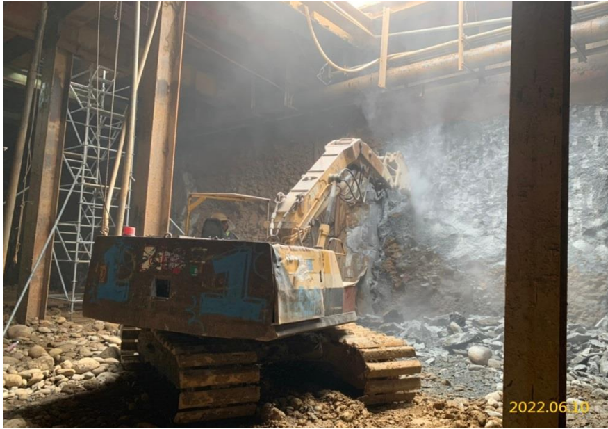
G03 站連續壁施工
