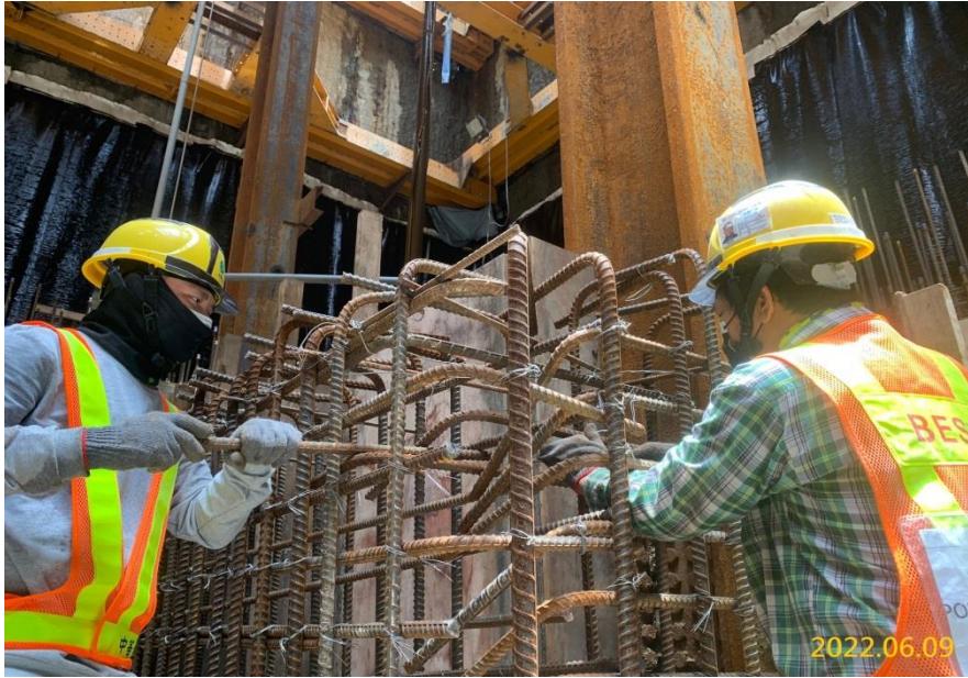
VS6 通風豎井結構體鋼筋綁紮
