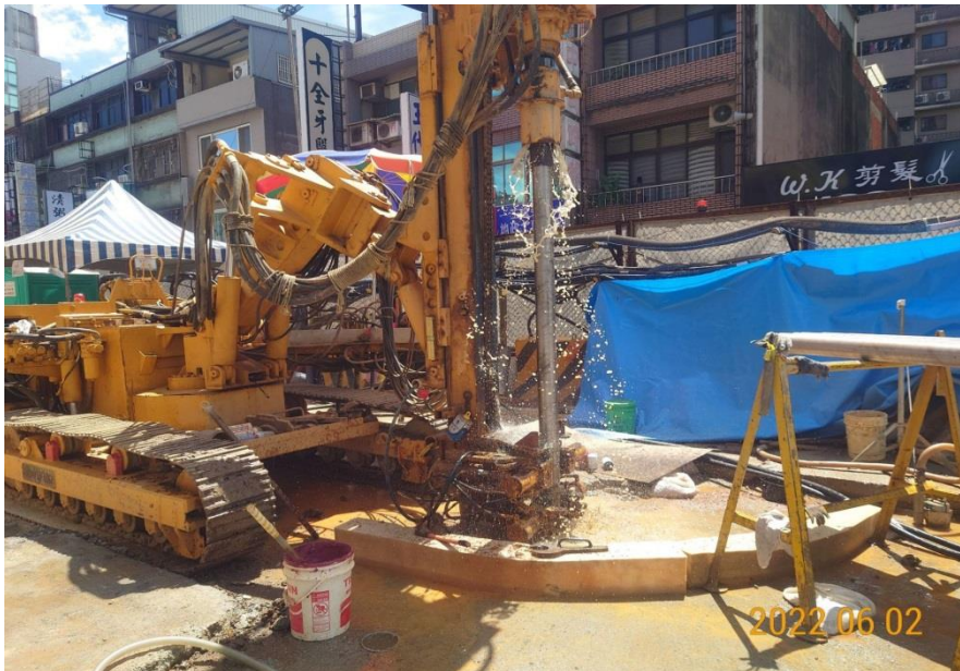
G04 站地盤處理
