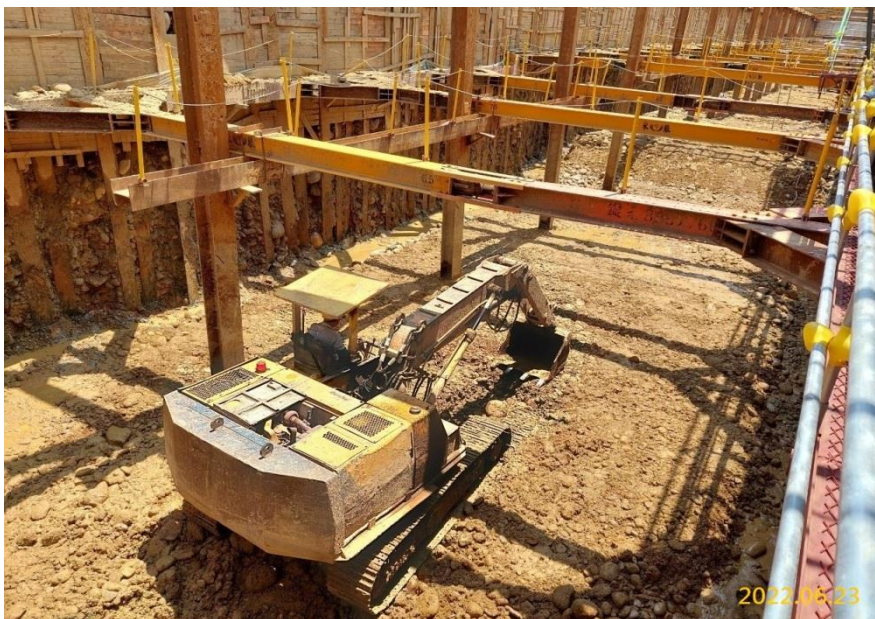
南出土段土方開挖及水平支撐架設
